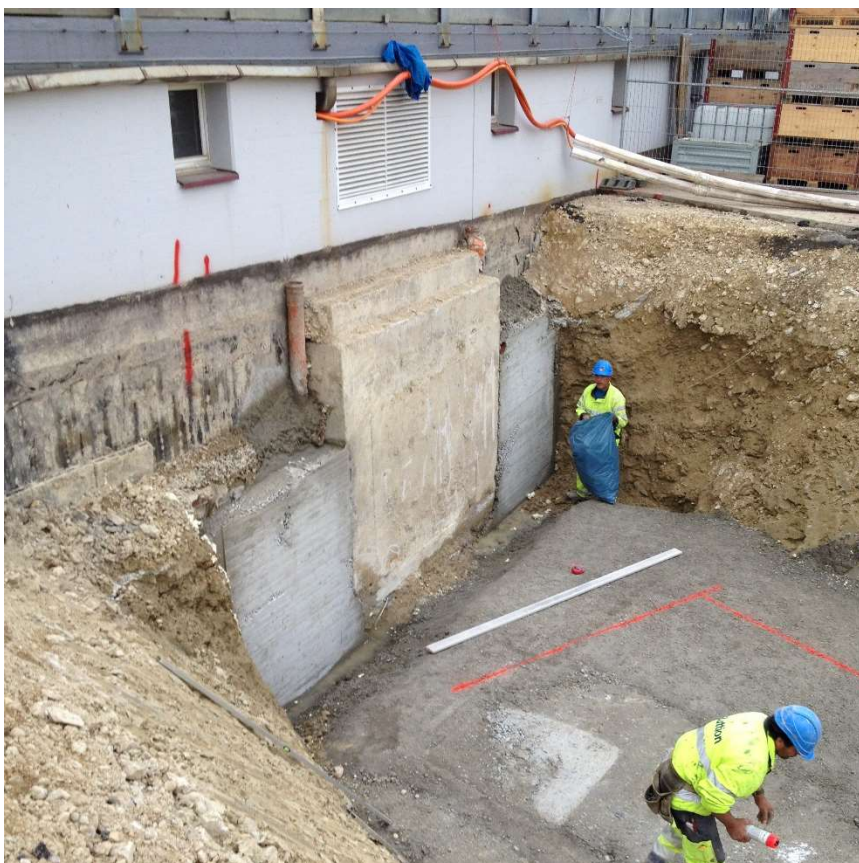
Reprise en sous-œuvre en façade d'une construction
