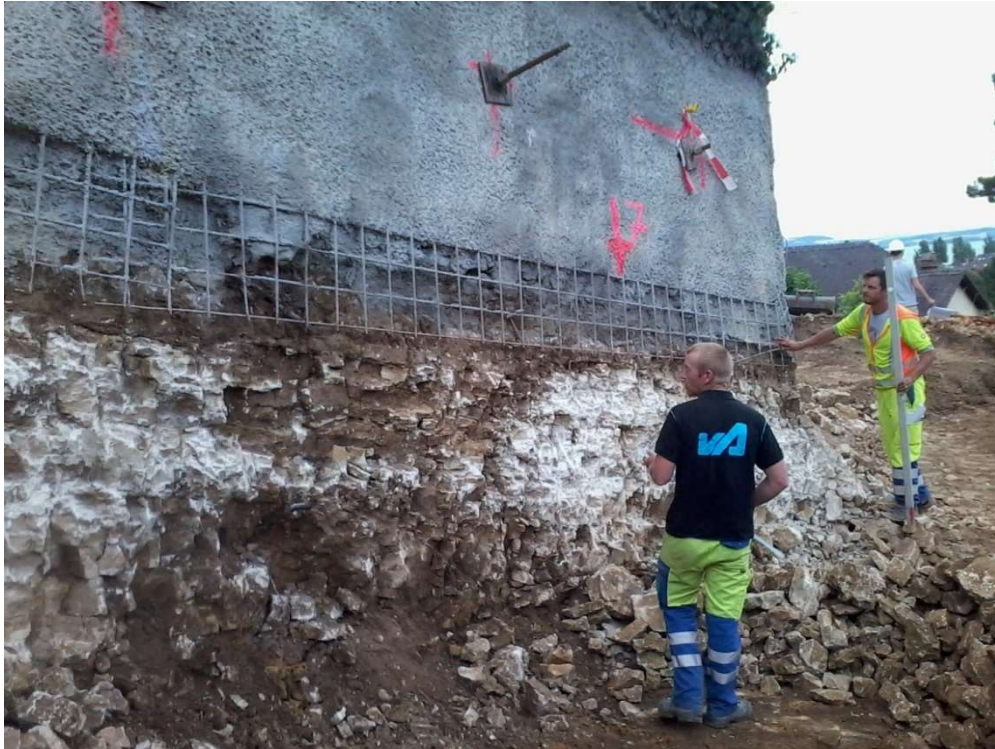
Soutènement vertical d'une fouille (clouage + gunitage)
