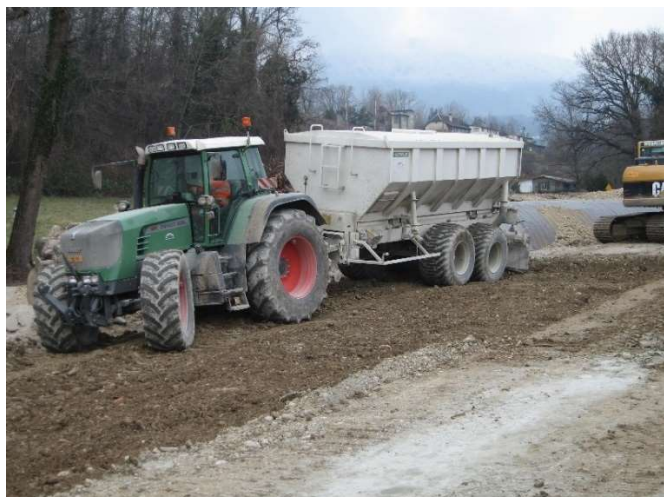
Amélioration du sol de fondation par ajout de ciment (stabilisation)
