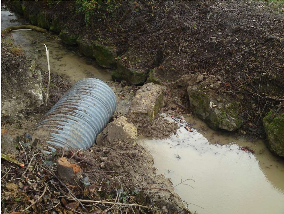
Déviation d'un cours d'eau pour permettre les travaux dans le lit du ruisseau
