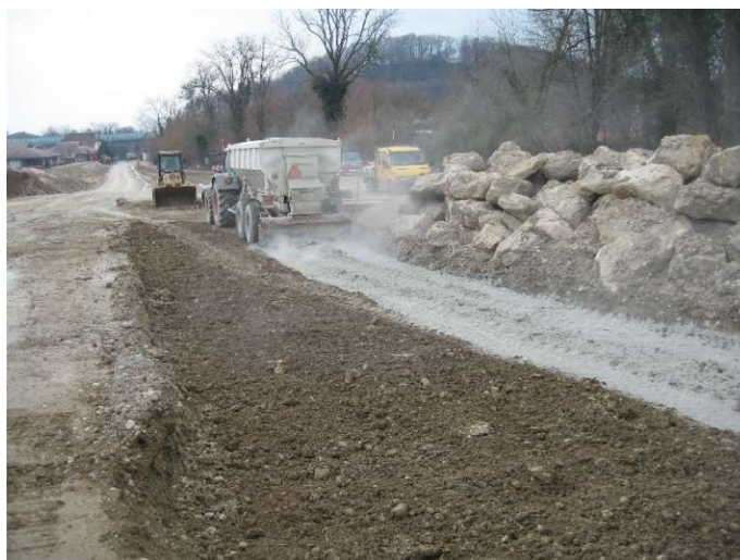
Amélioration du sol de fondation par ajout de ciment (stabilisation)
