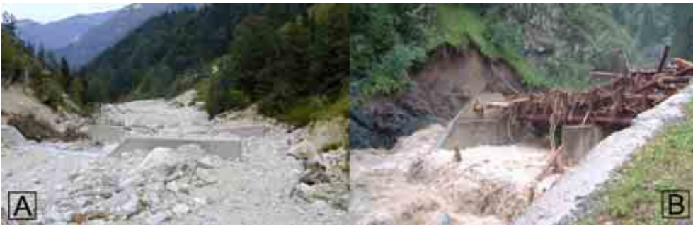
Abb. 11: Umgehung: (A) Umgehung aufgrund Anlandung und zu geringer seitlicher Einbindung; (B) Umgehung aufgrund Verklausung des funktionalen Teiles und fehlender seitlicher Einbindung (Foto: Walser Otto)
