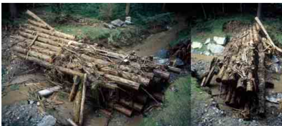
Abb. 15: Auftriebsbruch: aufgeschwommene und gekippte Holzkastensperre
