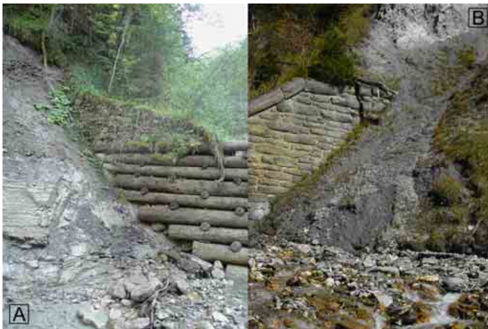
Abb. 10: Seitlicher Flankenwiderstand: (A) Fehlender Flankenwiderstand bei einer Holzkastensperre (Mechanismus 1); (B) Flächenerosion (Mechanismus 3)
