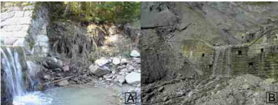
Abb. 8: Seitlicher Flankenwiderstand: (A) Mechanismus 1; (B) Erosion der seitlichen Flanke durch eine Kombination aus Mechanismus 1 und 3
