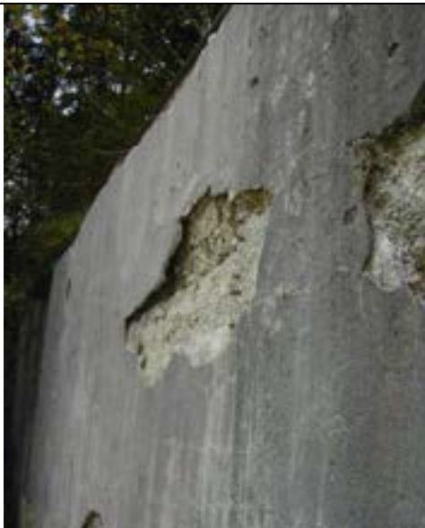
Verwitterung von Konstruktionsbeton: Abplatzung an der Luftseite einer Sperrplatte (SKL K) ©Suda
