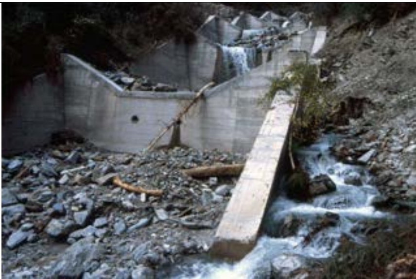
Ausgebildete Umgehung, Bauwerk standsicher (SKL K) ©Hübl
