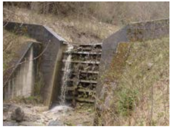
Durch Geschiebe verklauste Abflusssktion (SKL H) ©BOKU/IAN
