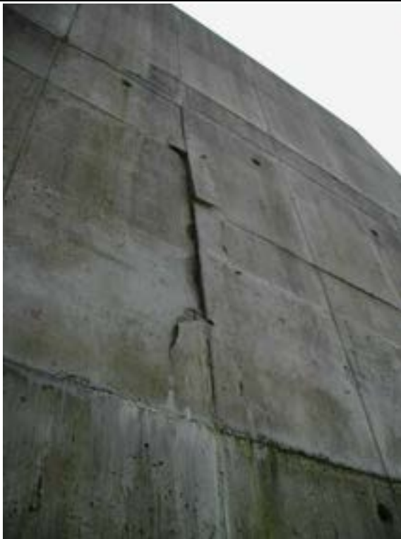
Verwitterung von Konstruktionsbeton: Abplatzung an der Luftseite einer Sperrplatte (SKL K) ©Suda
