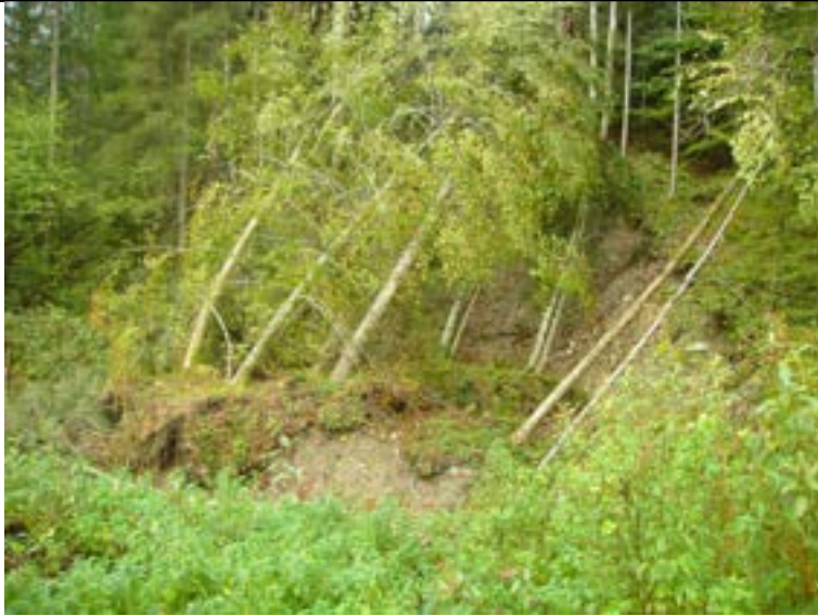
Böschungsbruch, (SKL H) ©Suda
