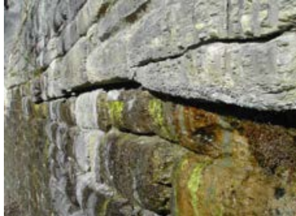
Ausblühungen (oberer Bereich), Aussinterungen (im unteren Bereich), häufig (SKL K) © Suda
