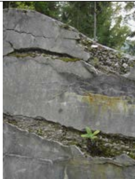
Abplatzungen an vorgeschädigten Bereichen (Arbeitsfuge) im Bereich der Krone (SKL K) ©Suda
