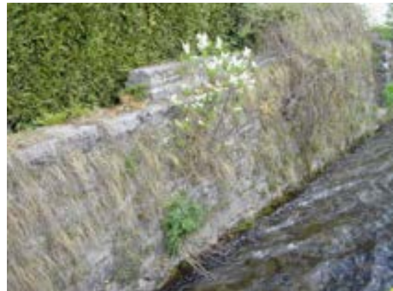
Bewachsener Mauerkörper (SKL U) ©Suda
