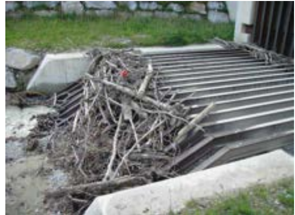
Durch Geschiebe verklauste Abflusssktion (SKL H) ©BOKU/IAN
