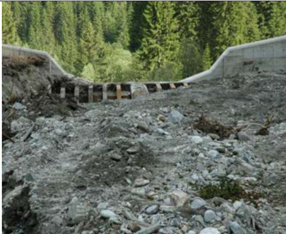
Gefülltes Retentionsbecken (SKL H) ©BOKU/IAN
