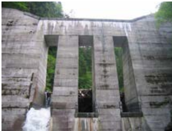
Teilverklauste Dolensperre (SKL K) ©Suda
