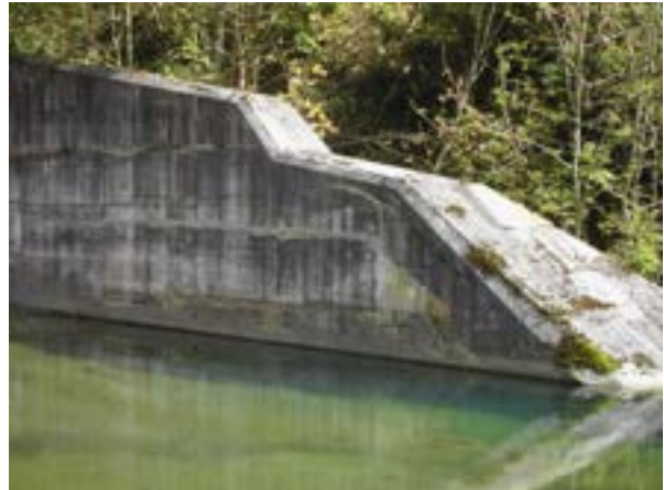
Aussinterungen entlang von Arbeitsfugen und Rissen (SKL K) ©Suda
