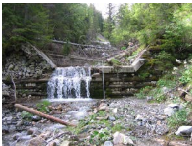
Abtrag der Füllung infolge einer Beschädigung der tragenden Hölzer (SKL K) ©Suda
