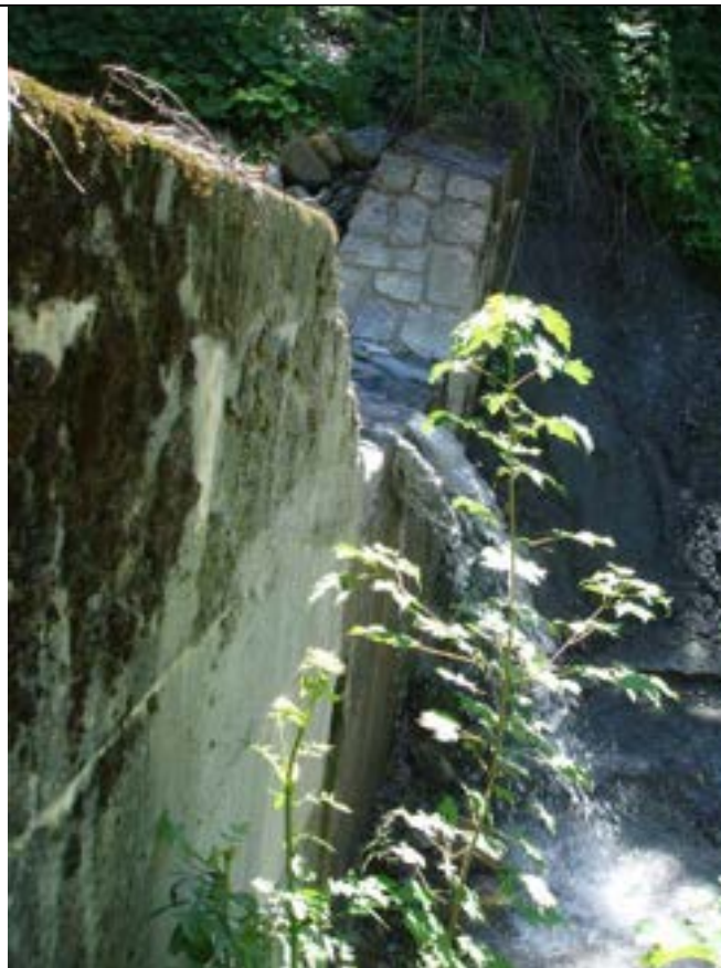
Gekippte Holzkastensperre infolge von Auftriebsbruch (SKL H) ©BOKU/IAN
