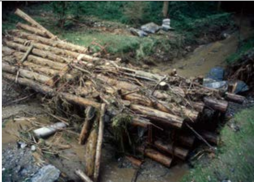
Gekippte Holzkastensperre infolge von Auftriebsbruch (SKL H) ©BOKU/IAN
