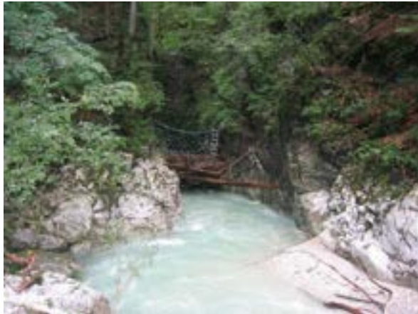
Verklauste Filtersperre (Netzsperr) (SKL H) ©WLV
