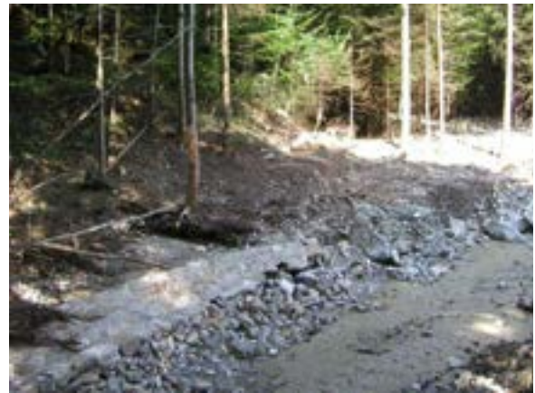
Verlust der Standsicherheit (SKL H) ©WLV
