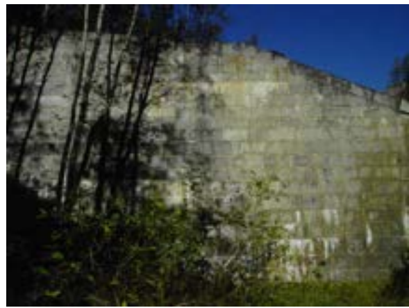
Ausblühungen (oberer Bereich), Aussinterungen (im unteren Bereich), häufig (SKL K) © Suda
