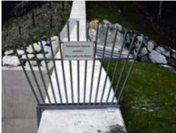
Absperrgitter mit Hinweistafel ©Suda
