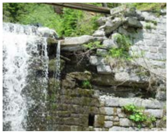
Verformung in der Folge von Überlastung durch seitlichen Hangdruck (SKL K) ©Suda
