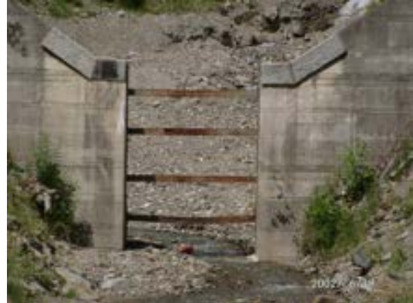
Verformte Balken (SKL U) ©BOKU/IAN
