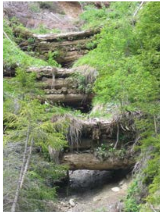
Unterströmung des gesamten Sohlbereiches von Grundschwellen (SKL H) ©Suda
