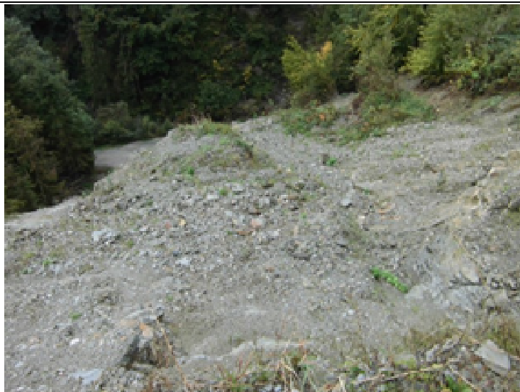
Hangmure oberhalb der Gerinnestrecke, (SKL H) ©WLV
