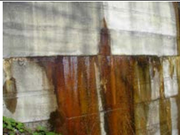
Aussinterungen entlang von Arbeitsfugen und Rissen (SKL K) ©Suda
