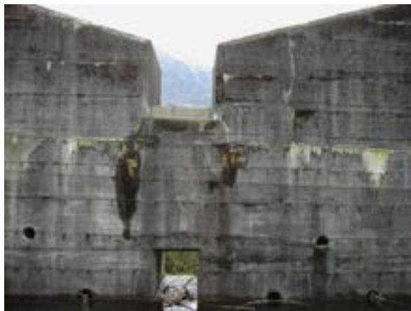
Rötliche Aussinterungen an Arbeitsfugen (SKL K) ©Suda
