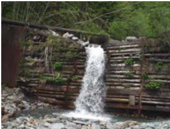
Deformation von Stahlträgern (SKL K) ©Suda
