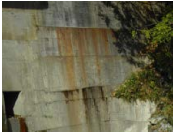
Rötliche Aussinterungen an Arbeitsfugen (SKL K) ©Suda
