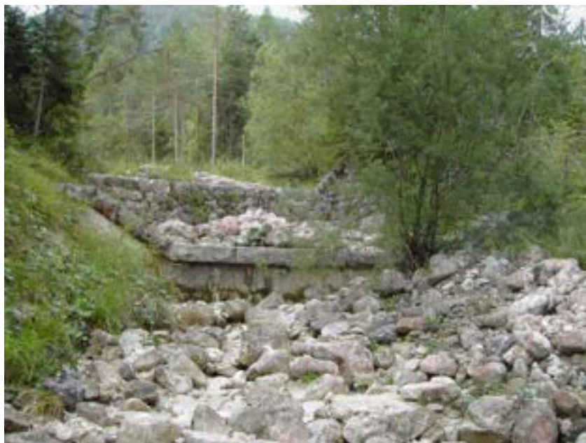
Geschiebeanlandungen zwischen Konsolidierungssperren (SKL K) ©Suda
