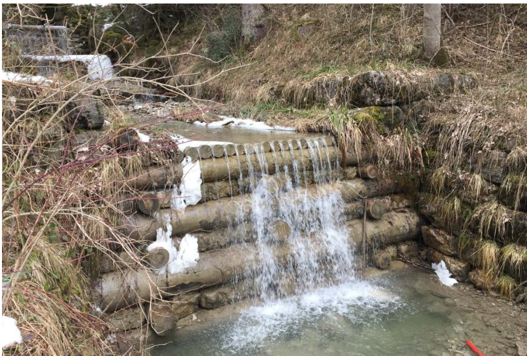
Abb. 2: Alte Sperre (ca. 20 jährig) noch mit Steinausfachung, Leitmauerwerken und Längsdielen (Bild: fobatec).
