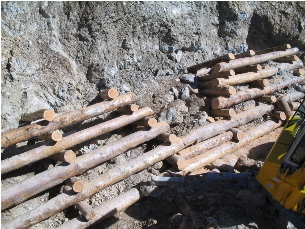
Abb. 1: Sperre ohne Füllhölzer, da flacher Anzug und Pflanzung bewurzelter Gehölze folgen (Bild: F. Bott)
