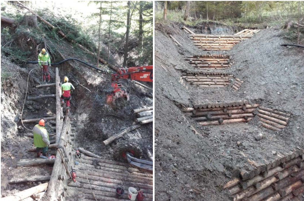
Abb. 2: Eingesteckte Flügel, und fertige Verbauung in der Steiermark (Weitbacher, WLV).
