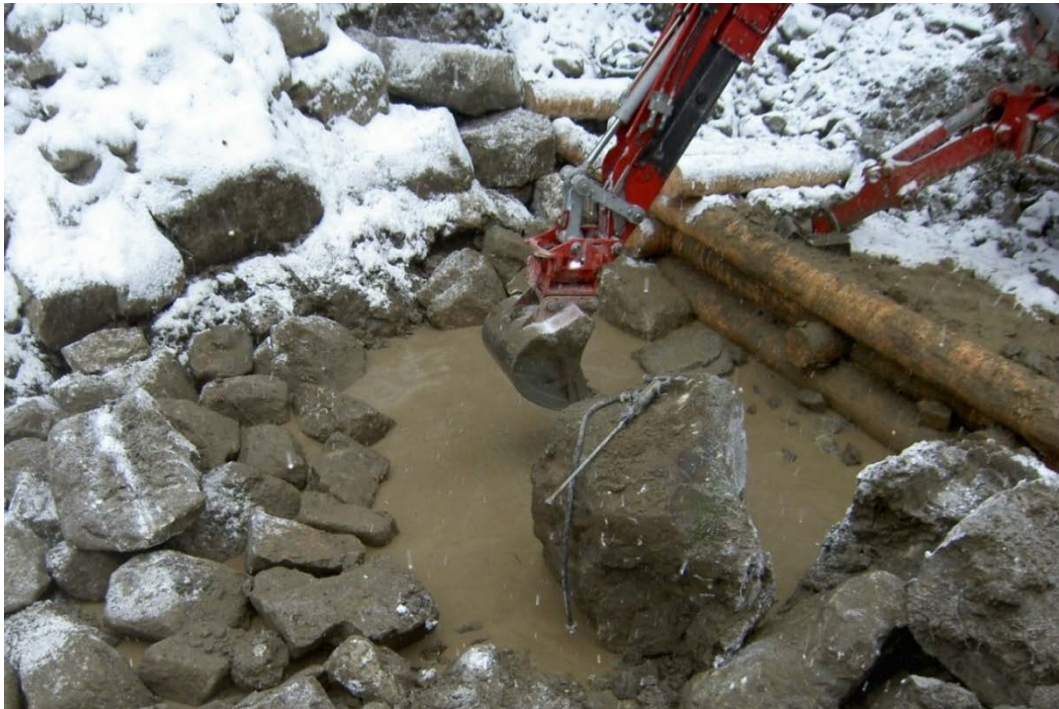
Abb. 1: Für den Kolkchutz wurde ein Becken aus Blöcken geschichtet (Bild: B. Ettlin).
