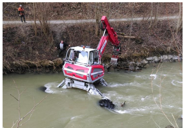
Schreitbagger im Einsatz (Foto 2015, Kästli Bau AG)
