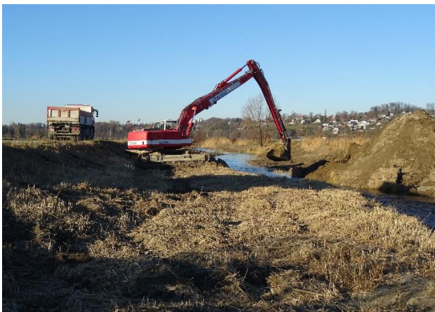
Langarmbagger im Einsatz (Foto 2016, Kästli Bau AG)
