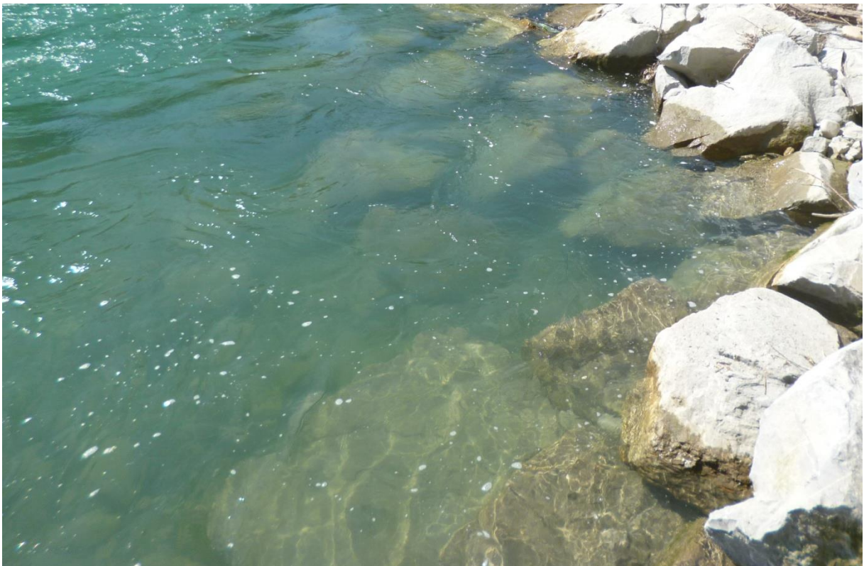
Uferverbau nach abgeschlossenen Arbeiten (Foto 2015, Kästli Bau AG)
