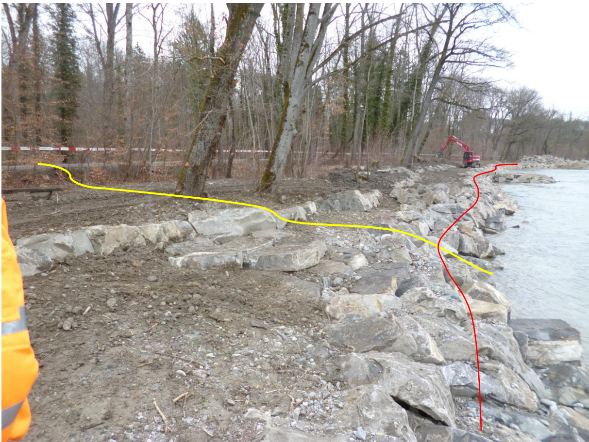
Ein schwach undulierender (rot) und abgestufter (gelb) Blocksatz (Foto 2013, Kästli Bau AG)
