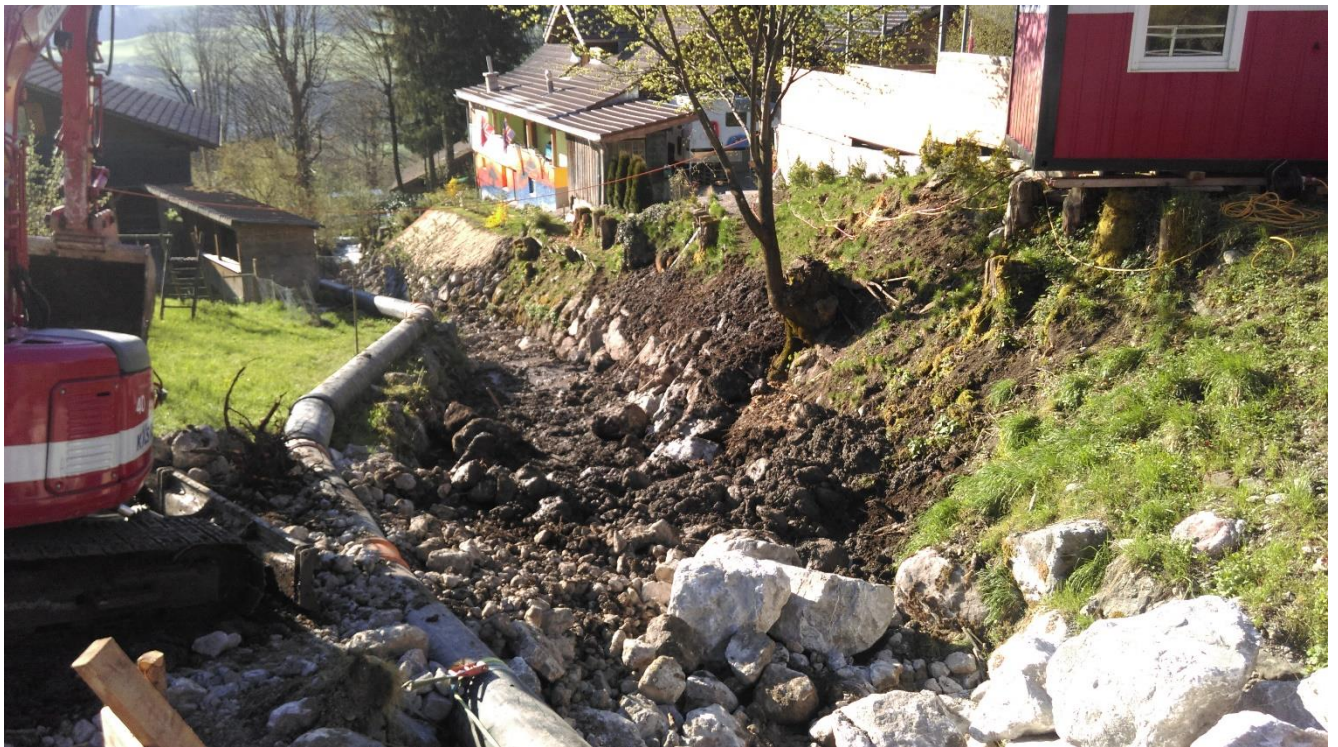
Eine vollständig verrohrte Wasserhaltung verhindert jegliche Trübung (Foto 2015, Kästli Bau AG)
