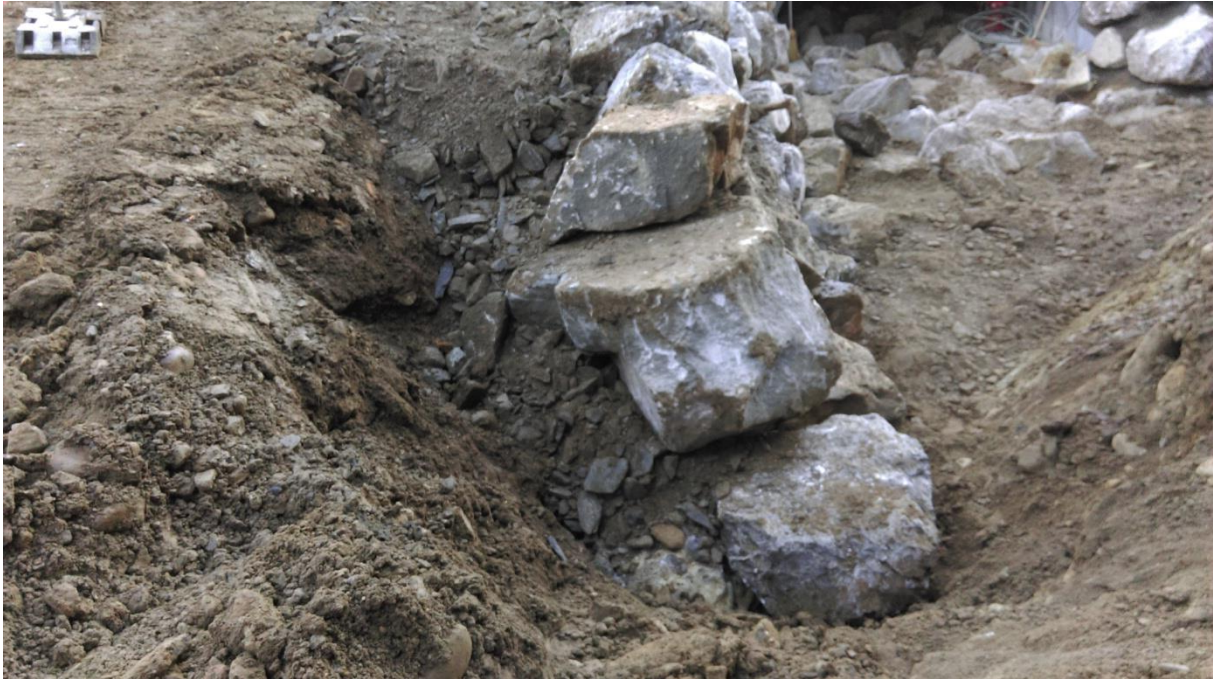
Ein steiler Blocksatz in Auflastfilter gebettet während der Realisierung (Foto 2016, Kästli Bau AG)
