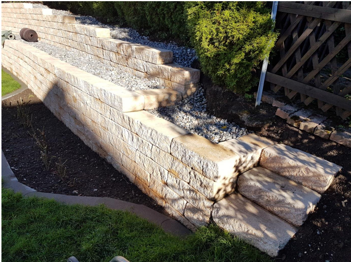
Sauber aufgeschichtete Gartenmauer (Foto von 2017, Kästli Bau AG)
