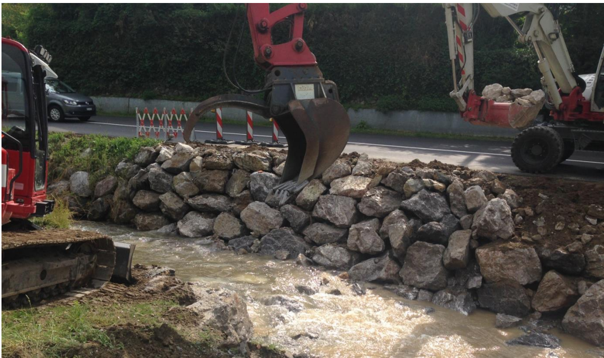
Frontansicht eines Blocksatzes einer Notfallmassnahme (Foto 2016, Kästli Bau AG)
