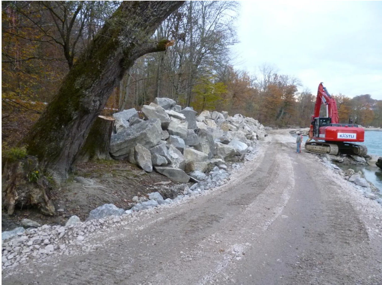
Blocksteindepot eines grossen Uferverbauts (Foto von 2012, Kästli Bau AG)
