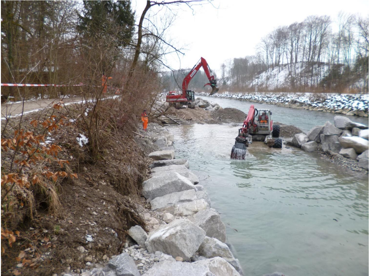
Verhinderung der Wassertrübung durch Abschirmung des Arbeitsbereichs mit einem Damm (Foto 2013, Kästli Bau AG)
