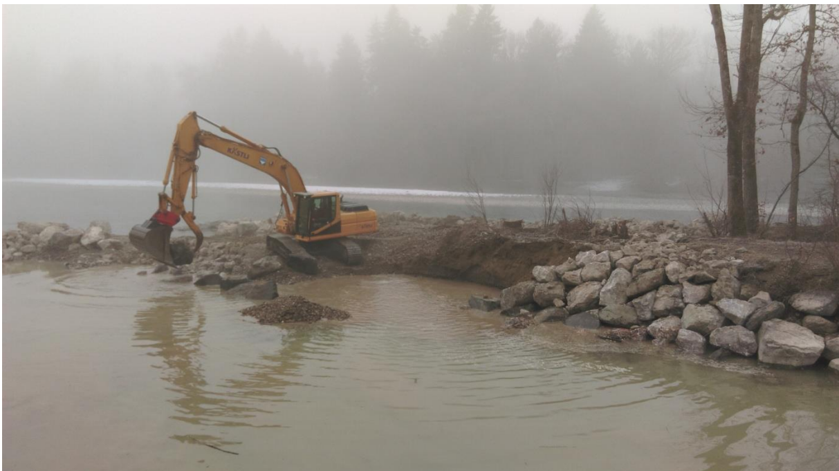
Neuer Uferverbau während der Ausführung (Foto 2015, Kästli Bau AG)
