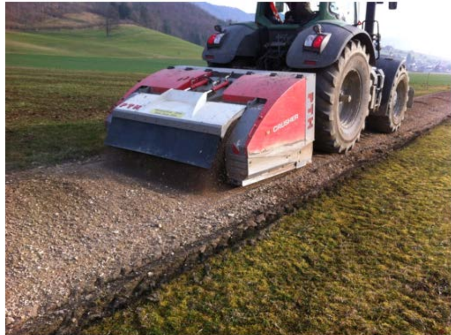
Aufbereiten von Verschleisssschichtmaterial mit mobilem Brecher
