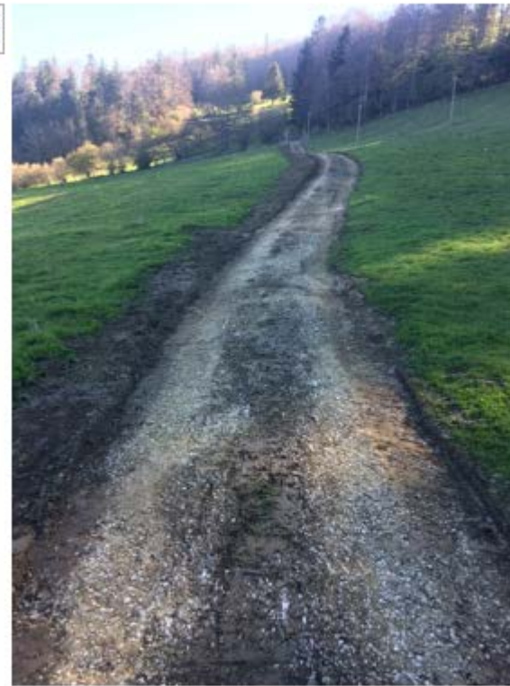
Aufgeführtes Material nach Bearbeitung mit mobilem Brecher, Vorplanie mit Grader erstellt
