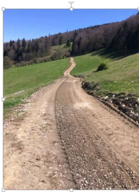
Aufgeführtes Material nach Bearbeitung mit mobilem Brecher, Vorplanie mit Grader erstellt
