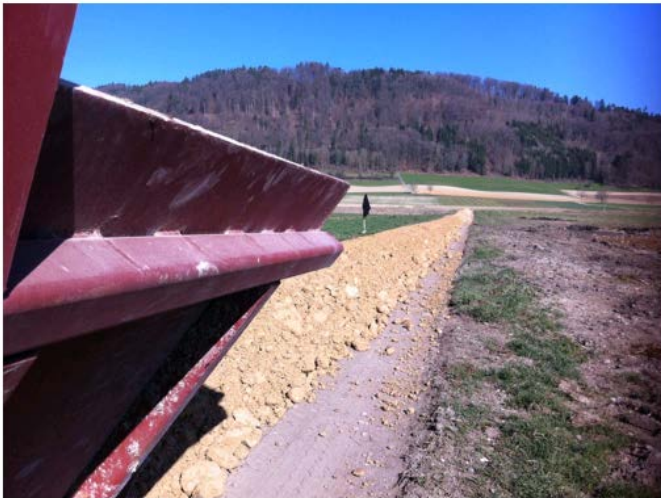
Aufführen von zugeführtem oder vor Ort abgebautem Verschleisssschichtmaterial
