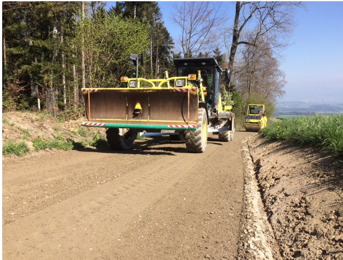
Profilieren der stabilisierten Foundationsschicht, mit unmittelbar darauf folgender Verdichtung.
