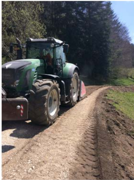
Auffräsen der best. Verschleisschicht mit mobilem Brecher zur Erstellung der Vorplanie / Reprofilierung
