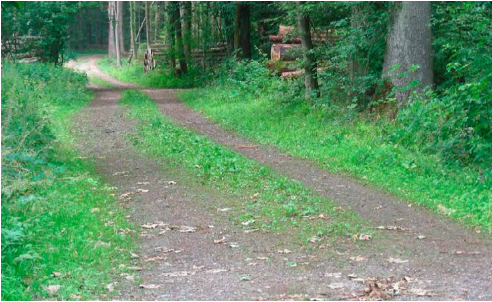
Abb. 18: Vernachlässigter Fahrhahnunterhalt, weshalb sich Vegetation in der Fahrhahnmitte ausbreiten konnte. Der Mittelstreifen sollte abgeschält werden, damit sich die Vegetation nicht weiter auf der Fahrhahn ausbreitet.
