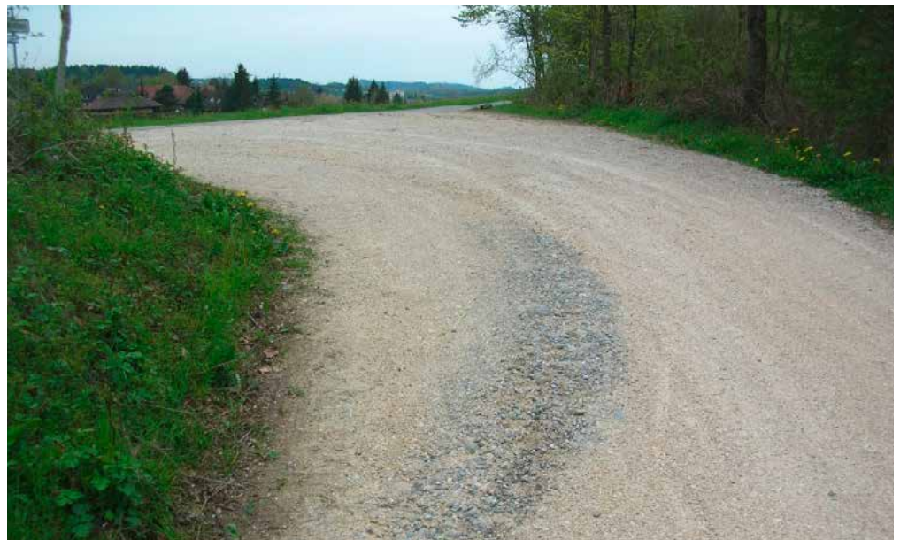
Abb. 1: Starke Verlagerung und Vermischung des Deck- und Tragschichtmaterials. Es haben sich Erosionsrinnen gebildet, welche in den Strassenkörper erodieren. Der Schaden ist so weit vorgeschritten, dass eine Instandsetzung der Strassen notwendig ist.
