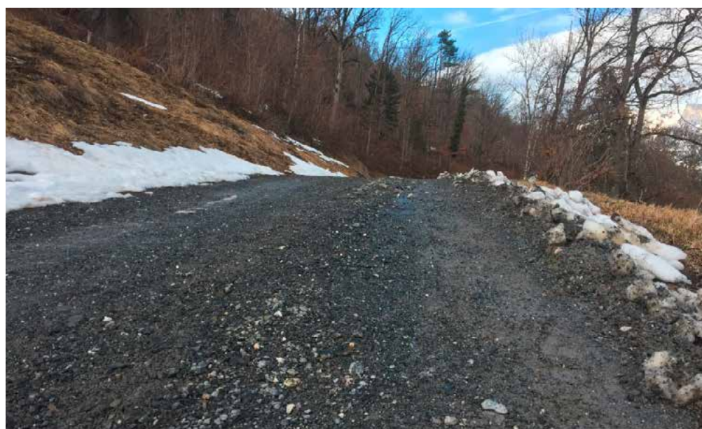
Abb. 4: Verlagerung des Deckschichtmaterials an die Fahrbahnänder aufgrund von falsch ausgeführter Schneeräumung. Beim Winterdienst auf Strassen mit ungebundenem Oberbau ist immer eine Weissräumung anzustreben. Als Massnahme ist ein betrieblicher Fahrbahnunterhalt inkl. Rückholung und Neuverteilung des Deckschichtmaterials durchzuführen.
