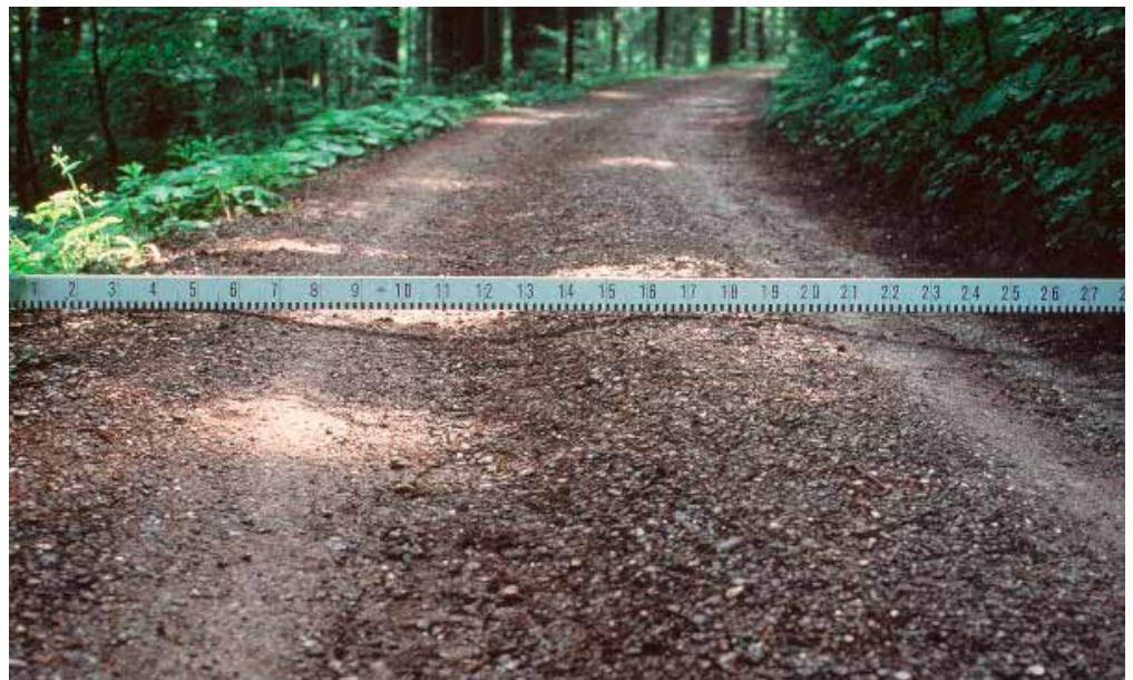
Abb. 10: Stark verdrückte Fahrbahn im Bereich der Fahrspuren aufgrund ungenügender Tragfähigkeit. Der Untergrund ist aufgeweicht und das Wasser sammelt sich in den Fahrspuren. Im vorliegenden Fall ist zumindest eine punktuelle Verstärkung notwendig.
