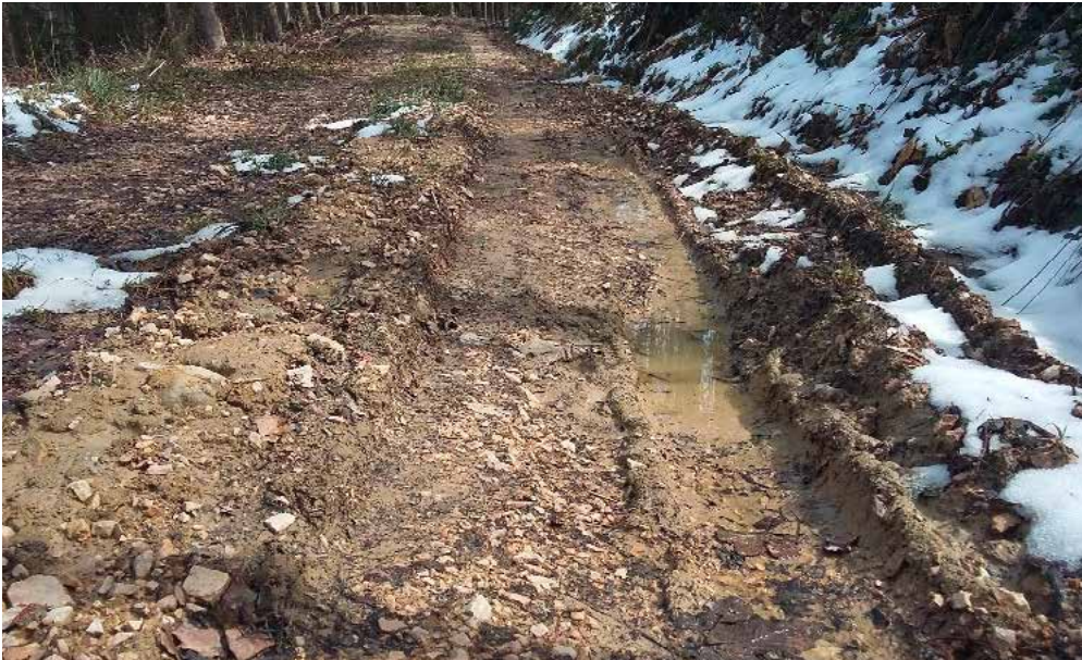
Abb. 10: Stark verdrückte Fahrbahn im Bereich der Fahrspuren aufgrund ungenügender Tragfähigkeit. Der Untergrund ist aufgeweicht und das Wasser sammelt sich in den Fahrspuren. Im vorliegenden Fall ist zumindest eine punktuelle Verstärkung notwendig.
