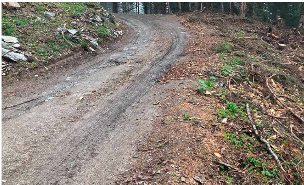
Abb. 22: Lokal verschmutzte Fahrbahn. Astmaterial und Rinde sind nach dem Holzschlag auf der Strasse liegen geblieben. Sie werden durch den Verkehr in die Strasse eingefahren. Das Ast- und Rindenmaterial sollte von der Fahrbahn und dem Bankett entfernt sowie die Entwässerung sichergestellt werden.
