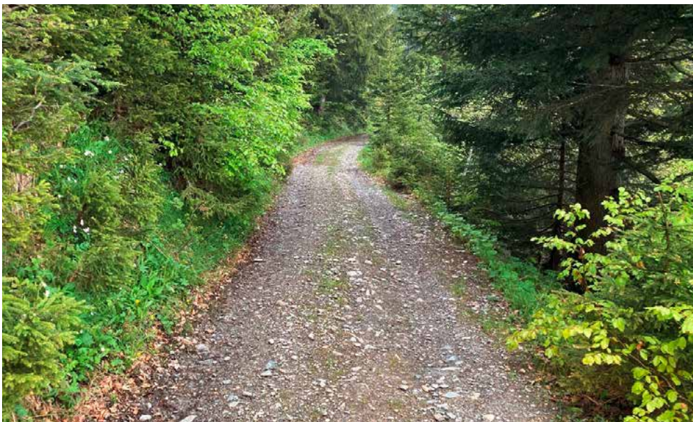
Abb. 20: Eingeschränktes Lichtraumprofil aufgrund von Böschungsbewuchs (bergseitig) und Ästen (talseitig). Die Böschung sollte von Bewuchs befreit und in das Lichtraumprofil einhängende Äste entfernt werden.
