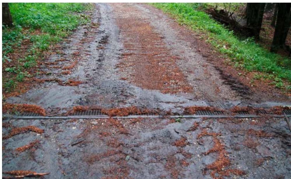
Abb. 22: Lokal verschmutzte Fahrbahn. Astmaterial und Rinde sind nach dem Holzschlag auf der Strasse liegen geblieben. Sie werden durch den Verkehr in die Strasse eingefahren. Das Ast- und Rindenmaterial sollte von der Fahrbahn und dem Bankett entfernt sowie die Entwässerung sichergestellt werden.
