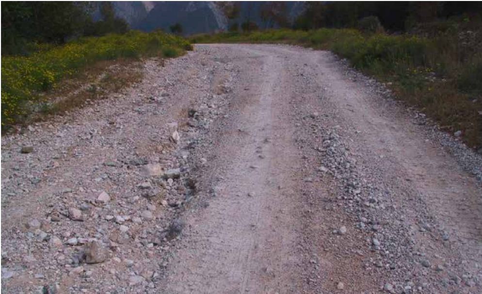
Abb. 1: Starke Verlagerung und Vermischung des Deck- und Tragschichtmaterials. Es haben sich Erosionsrinnen gebildet, welche in den Strassenkörper erodieren. Der Schaden ist so weit vorgeschritten, dass eine Instandsetzung der Strassen notwendig ist.
