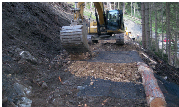
Nach Verdichtung des Auflagematerials wird das Geotextil rückgeschlagen, leicht überschüttet und mit der Baggerkette abermals verdichtet.
