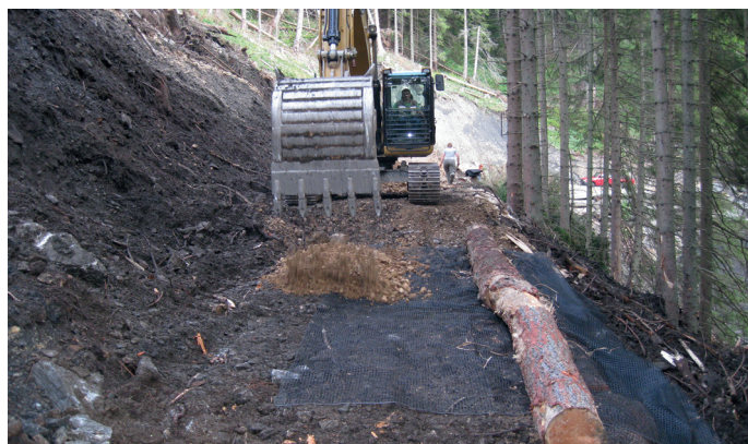
Das am Planum aufgelegte Geotextil wird mit dem Bagger bis auf Läuferhöhe überschüttet.
