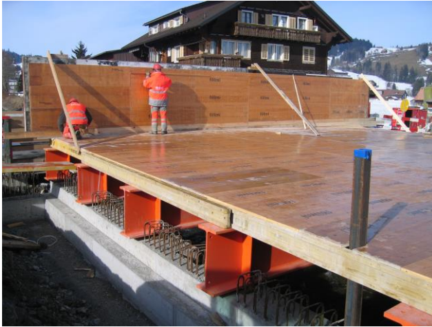
Die auf den Stahlträgern aufliegende Schalung.
