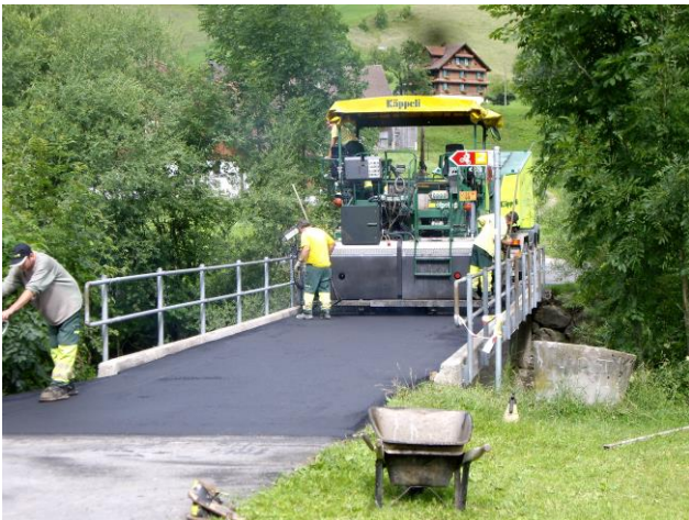
Einbringen des Belages
