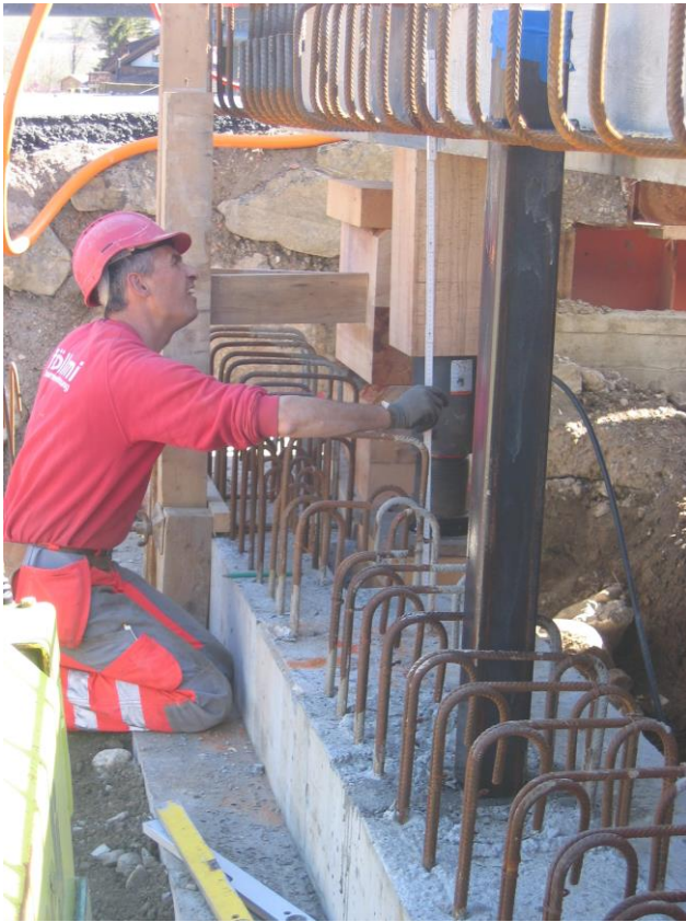
Der Polier überwacht den Absenkvorgang.
