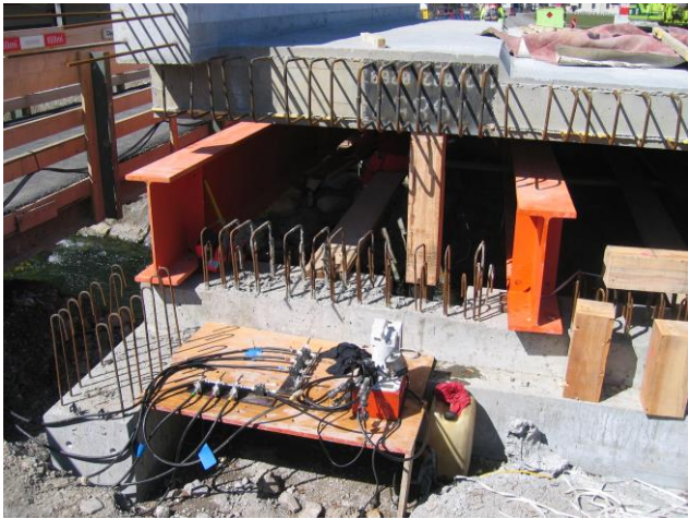
Um die fertig betonierte Brückenplatte abzusenken, wurden hydraulische Pressen montiert.
