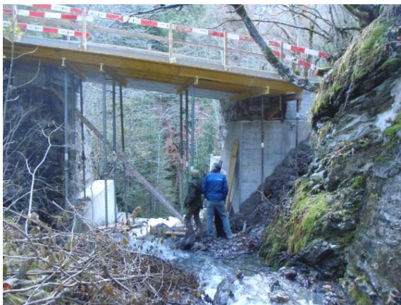
Abbildung 3 Sanierung der Brücke über die Sulzelruns an der Krauchtalstrasse (Einzugsgebiet: 1.7km 2 ; HQ max : ca. 24 m 3 /s).
