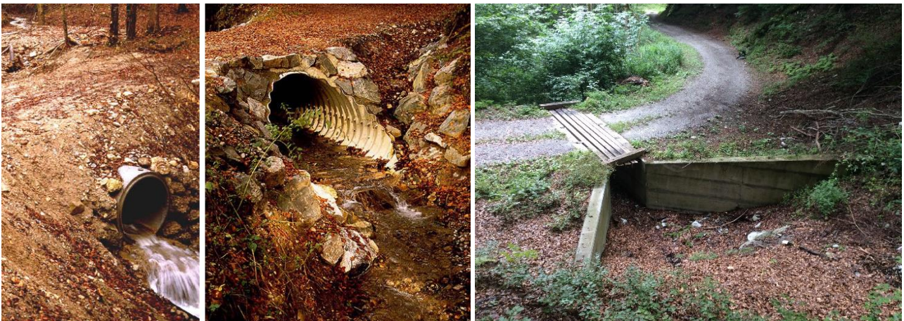
Abbildung 2: Beispielbilder der drei verglichenen Querungsbauwerke vlnr Rohr dn600, Maulprofil, Kastendurchlass (Bergeller)
