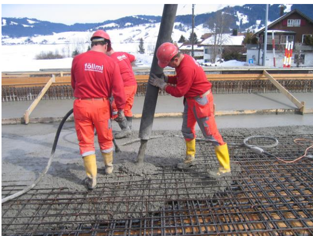
Das Betonieren der Brückenplatte.
