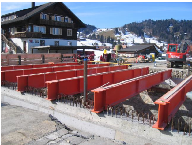
Zum Schutz vor Hochwasser durfte die Brücke nicht in den Bach abgespriesst werden. Die Schalung der Brückenplatte wurde deshalb erhöht auf Stahlträgern erstellt.
