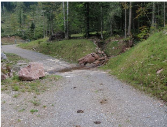
Abbildung 23 Furt mit dauernder Wasserführung über die Strasse
