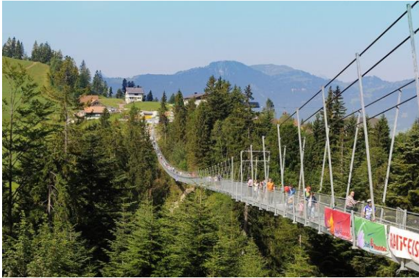
(Bild: Hängebrücke Hochstuckli, Sattel)
