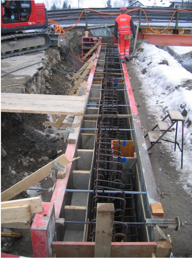
Über den Pfählen wird das Widerlagerbankett erstellt.
