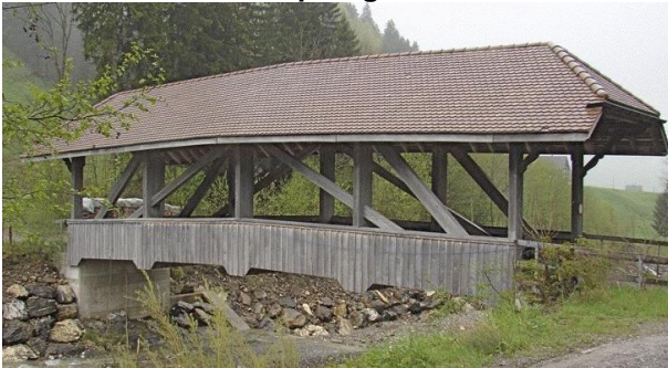
(Bild: Grossbachbrücke, Gross)
