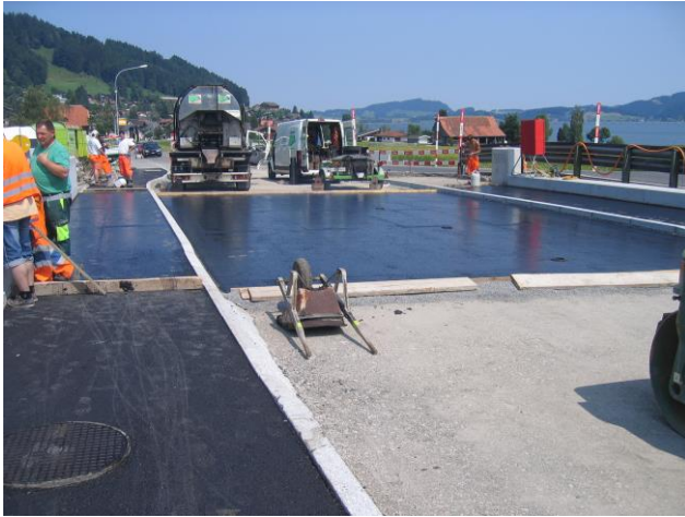
Die Brücke wird abgedichtet.
