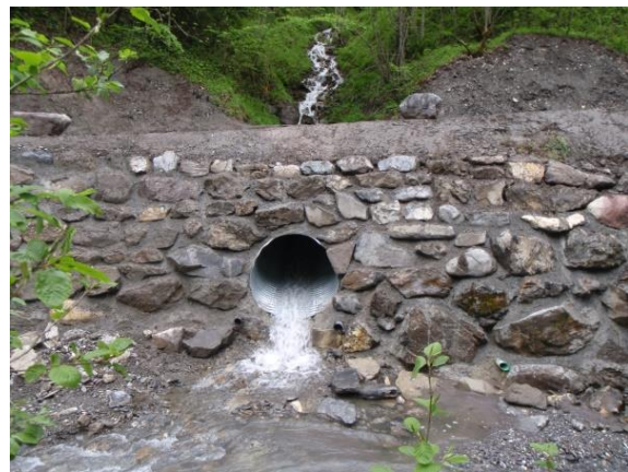
Abbildung 4 Neuer Bachübergang über die Teufruns an der Krauchtalstrasse (Einzugsgebiet 0.25 km 2 ; HQ max : ca. 4.5 m 3 /s)
