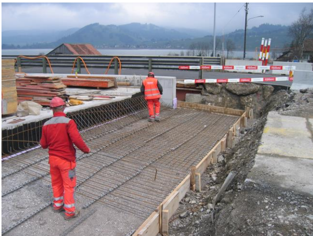
Die Brücke ist abgesenkt worden. Die Schlepp-Platte wird erstellt.
