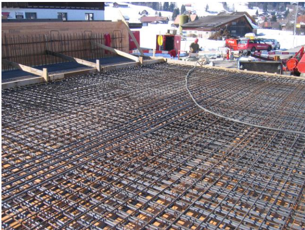
Die fertig bewehrte Brückenplatte.
