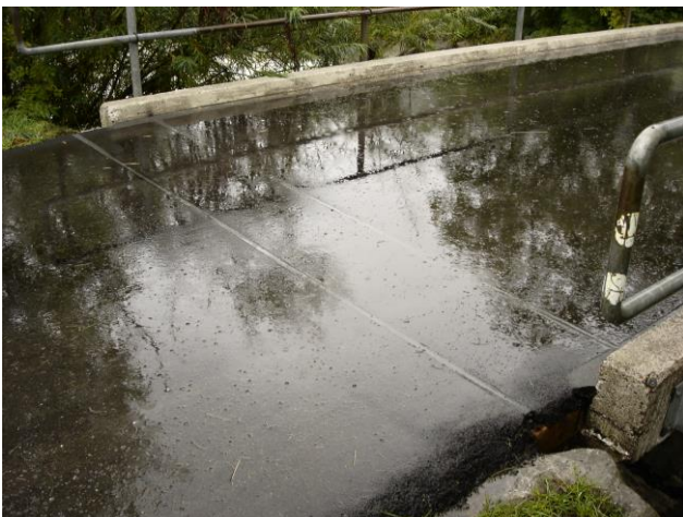
Heissvergussfugen bei den Widerlagern und als Abschluss zu den Randborden.
