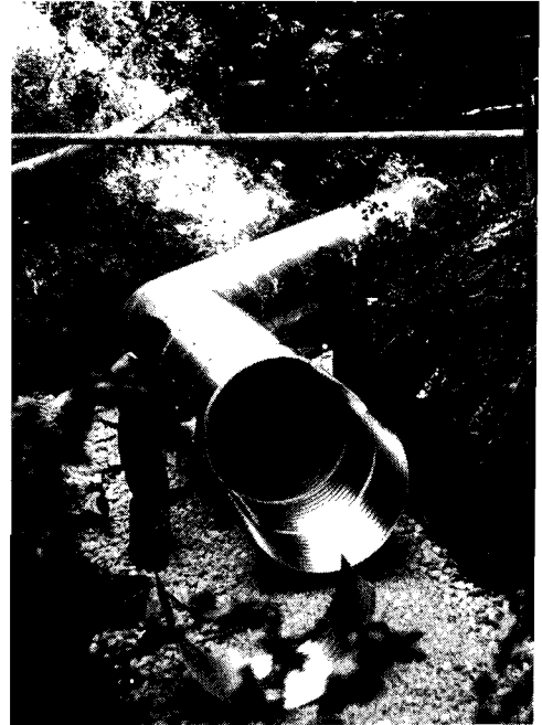
Waldarbeiter beim Montieren eines Multiplate-Bachdurchlasses
