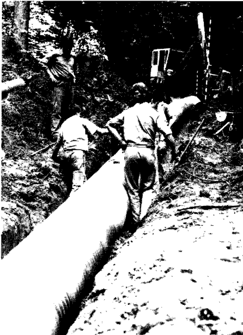
Forstschüler der Forstschule Lyss beim Verlegen von Spiwell-Rohren
