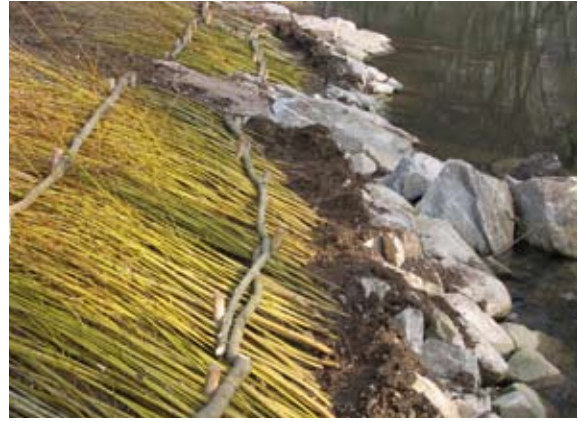
Detail der Spreitlage nach Fertigstellung
