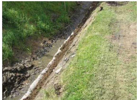
Übererdung und Modellierung des Ufers
