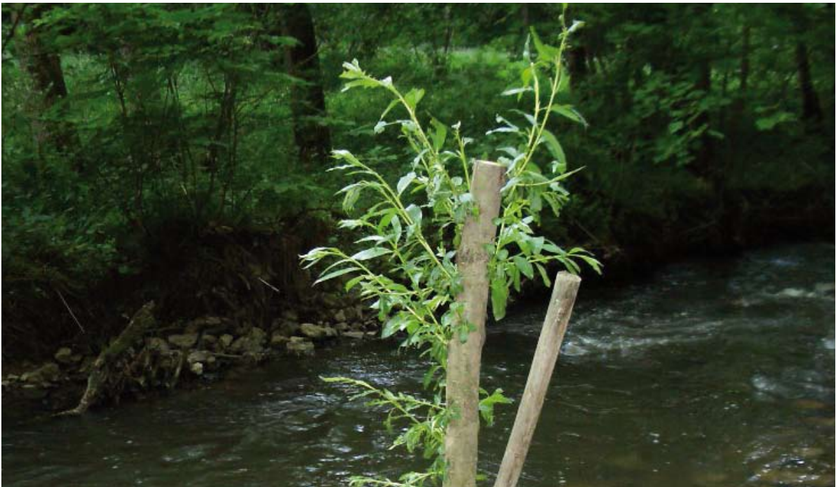
Austrieb von Setzstangen, die weiter herauschauen, nach 3 Monaten
