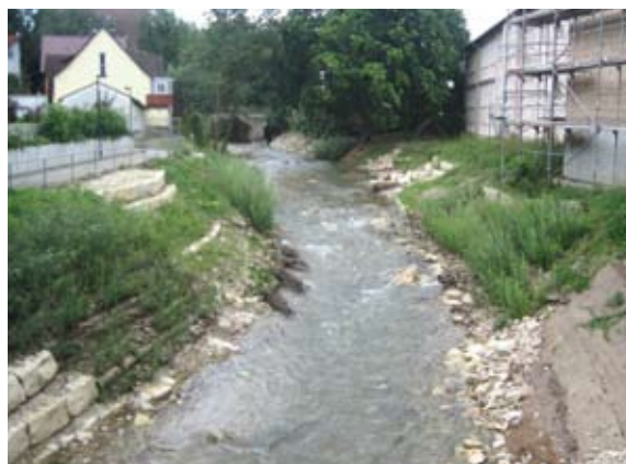
Baustelle nach Beendigung der Bauarbeiten
