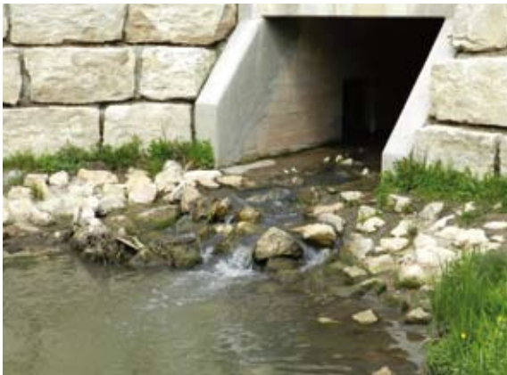
Umbau mit aufgeweiteter Mündung und verkürztem Durchlass (2010)
