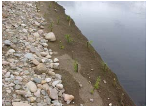
Eingebaute Geotextilfaschine mit Weidenstecklingen (2013)
