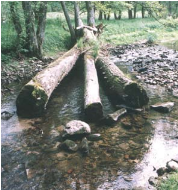
Die gleiche Buhne 2005 durch Verdriftung aufgefächert und unter-spült: Entstehung einer Schnelle oberhalb mit Substratdiversifizie-rung unterhalb (Gebler 2005)
