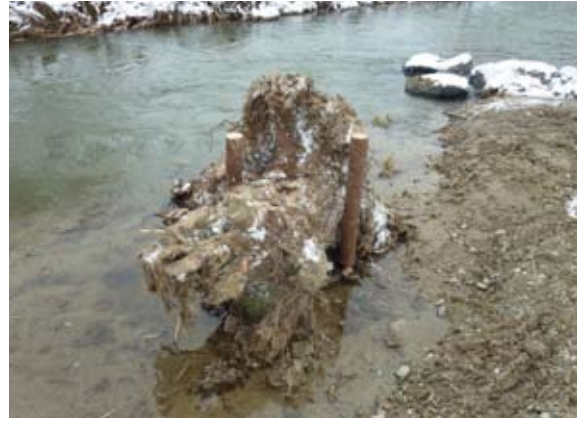
Mit Pfählen befestigter Wurzelstock (2010)
