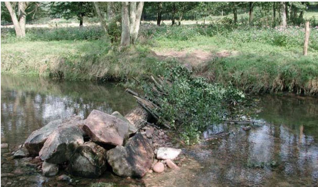
Einzelstamm-Auflieger nach dem Bau. Er wurde durch ein Hochwasserereignis zerstört und parallel zum Ufer abgedreht (Gebler 2005)
