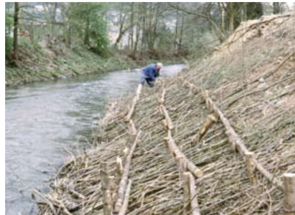
Befestigung der Fichtenstangen an den Pfählen
