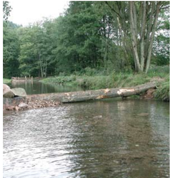
Einzelstamm-Auflieger nach dem Bau: ca. 1 m in das Ufer eingebunden, beidseitiges Widerlager und Beschwerung mit Steinblöcken (Gebler 2005)
