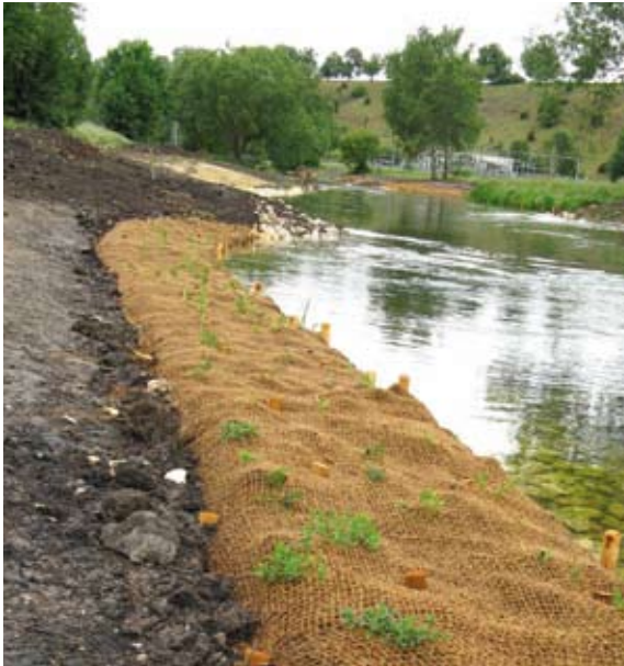
Punktuelle Austrieb der eingebauten Pflanzensoden nach 4 Wochen
