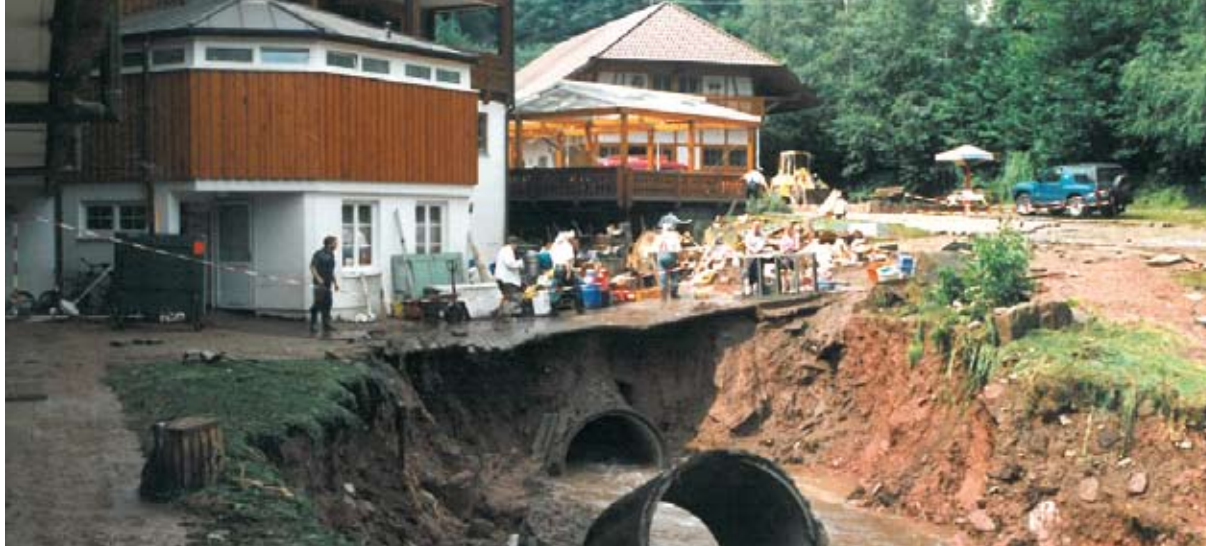
Hochwasserschäden am Tag nach dem Hochwasser (19.07.1999)
