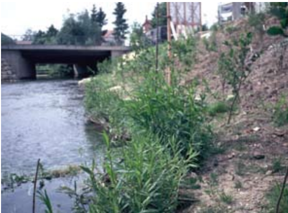
Uferprofilierung und Einbau der Faschinen mit hinterpflanzten Erlen (1999)
