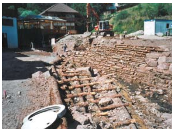
Herstellen von Krainerwänden
