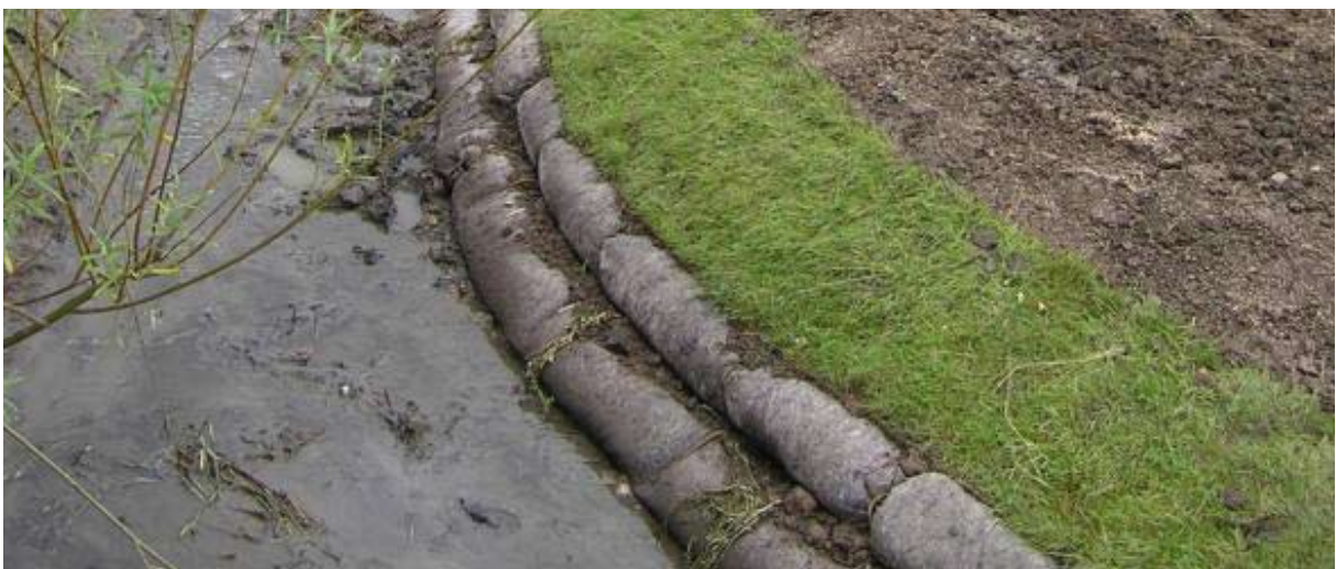
Fertig eingebaute Vegetationswalze (2012)
