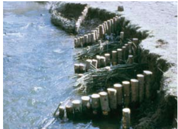
Jede zweite Buhne wurde als Flechtwerksbuhne mit ausschlagfähigen Weiden ausgeführt
