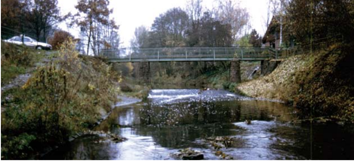
Gewässerabschnitt mit Sohl- und Böschungspflaster vor der Umgestaltung im Nov. 1993, (Rohreinmündung als Orientierung)
