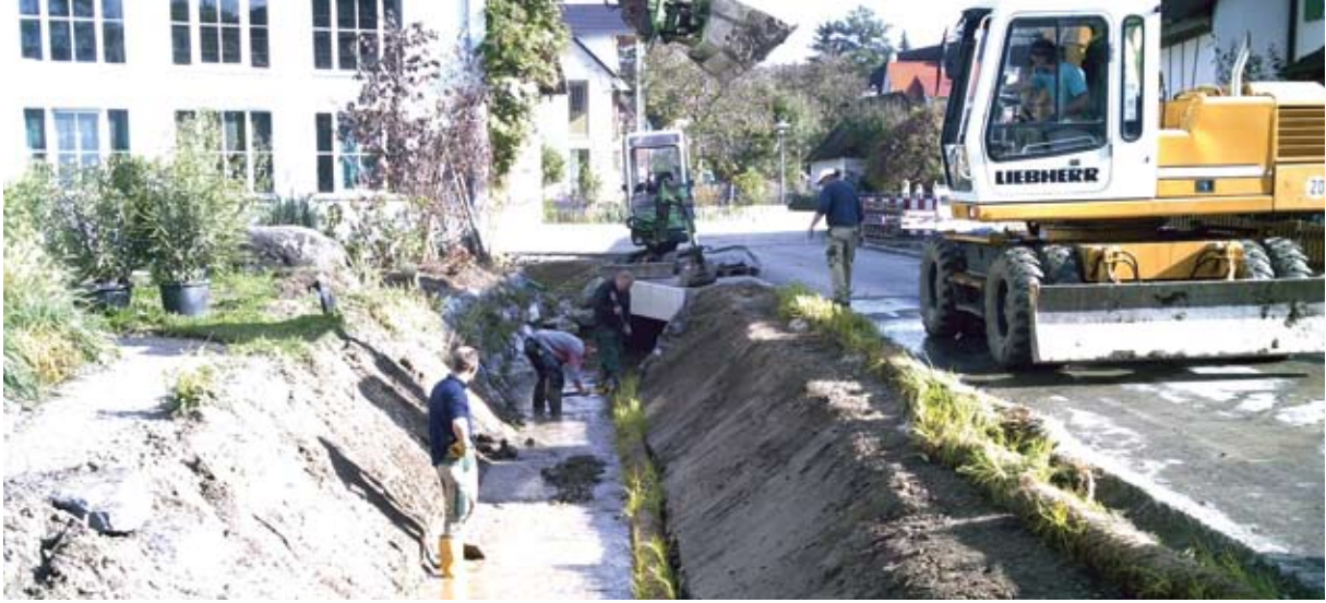
Einbau der Vegetationswalzen am Böschungsfuß
