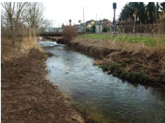
Nach Einbau der Ufersicherung (rechts) und Uferaufweitung (links)
