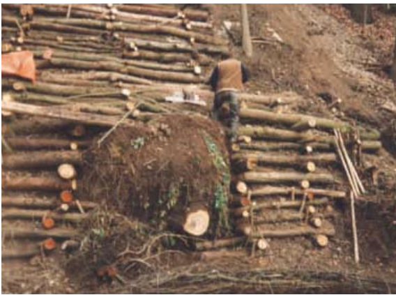
Einbindung eines gefällten Baumes
