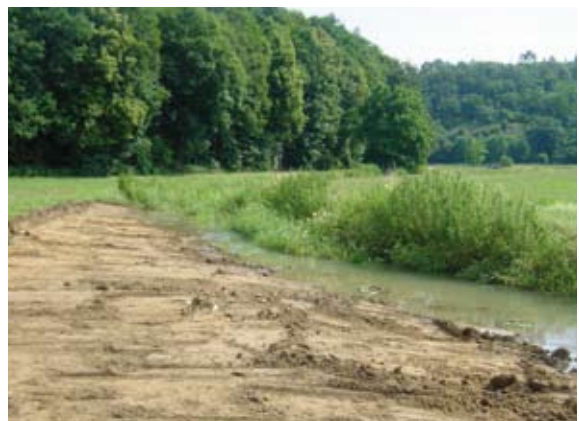
Erdarbeiten bei der Lonerenaturierung (2010)
