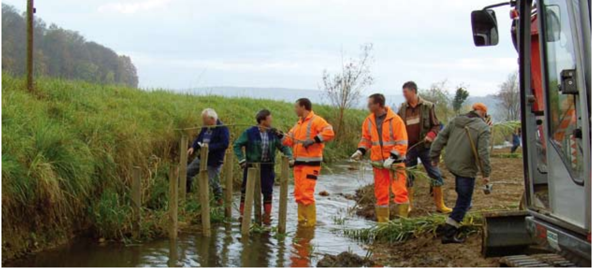
Umflechten der Pfähle mit Weidenruten
