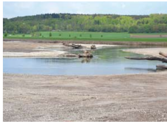
Mittelwasserstand, durch Einengung des Gewässerquerschnittes entsteht eine vielfältige Fließdynamik des Gewässers
