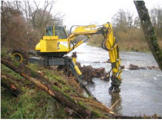
Einbau der Wurzelstöcke mittels Schreitbagger mit Bohraufsatz (2006)
