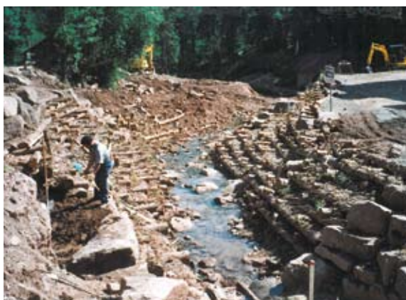
Bauausführung ingenieurbiologischer Bauweisen
