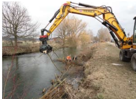
Bauphase 1, Einbau der Buhnen
