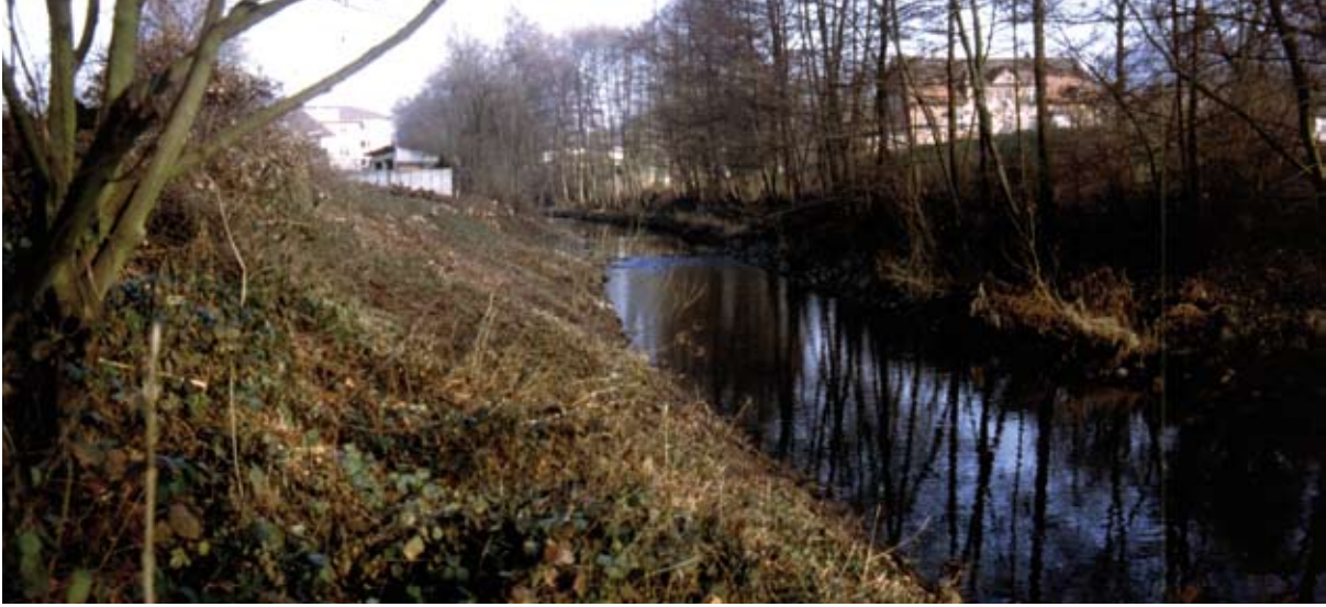
Gehölze wurden zur Gewässeraufweitung entfernt
