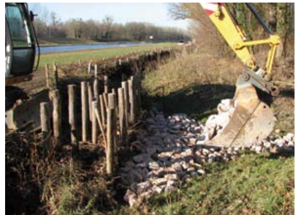
Einbau Wasserbausteine 10-20 kg als Kolksschutz
