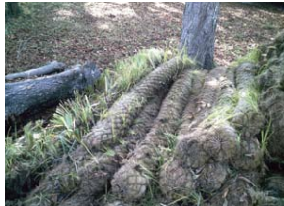
Vegetationswalzen vor dem Einbau
