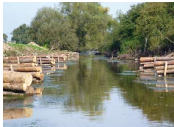
Eingebaute Ausfachungsbuhnen während des Bachabschlags
