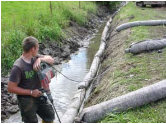
Uferabflachung und Einbau der Walzen als Fußsicherung (I)
