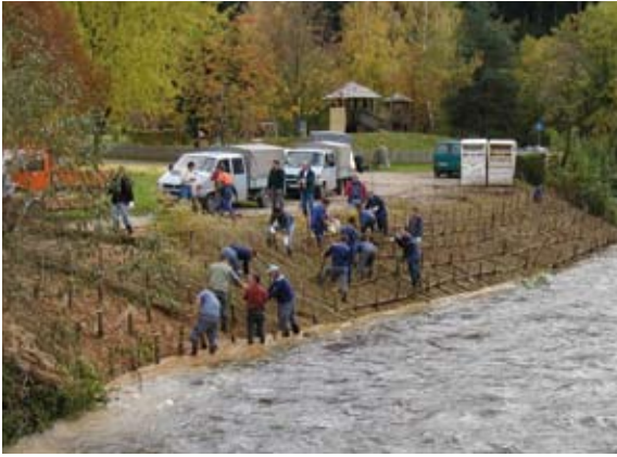
Der Einbau einer Weidenspreitlage erfolgte als praktische Übung im Rahmen eines Gewässernachbarschaftstages in 2004
