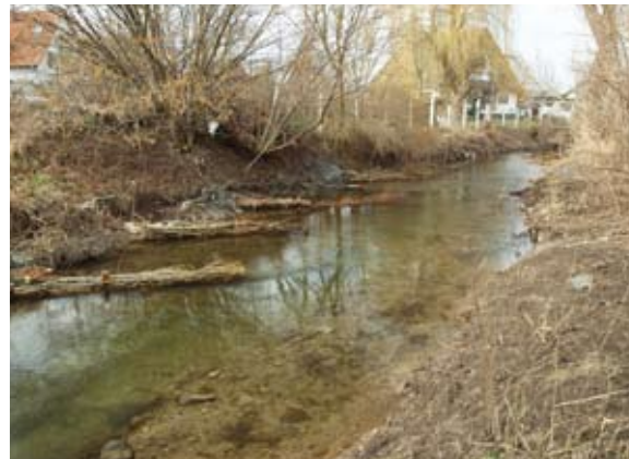
Nach Einbau der Strömungslenker und Vorlandabtrag
