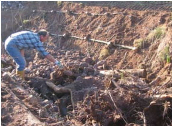
Sohlstabilisierung mit Wurzelstöcken
