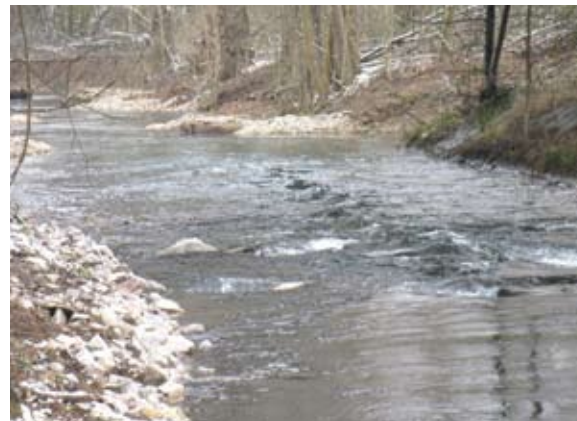
Kiesschnelle vor einem Bereich mit notwendiger Uferbefestigung (Brücke), Aufwertung der Sohlstruktur (2013)
