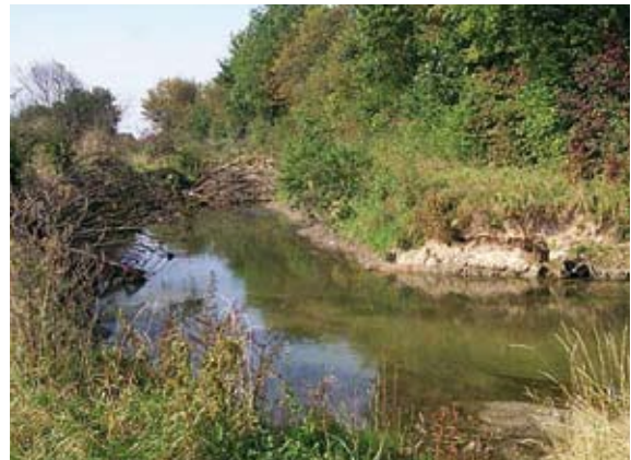
Einbau von Raubäumen als zusätzliches Strukturelement
