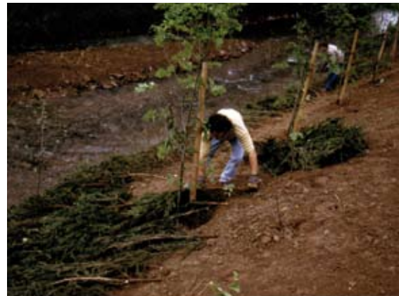
Aufbringen der Fichtenspreitlage nach Bepflanzung und Einsaat der Böschung
