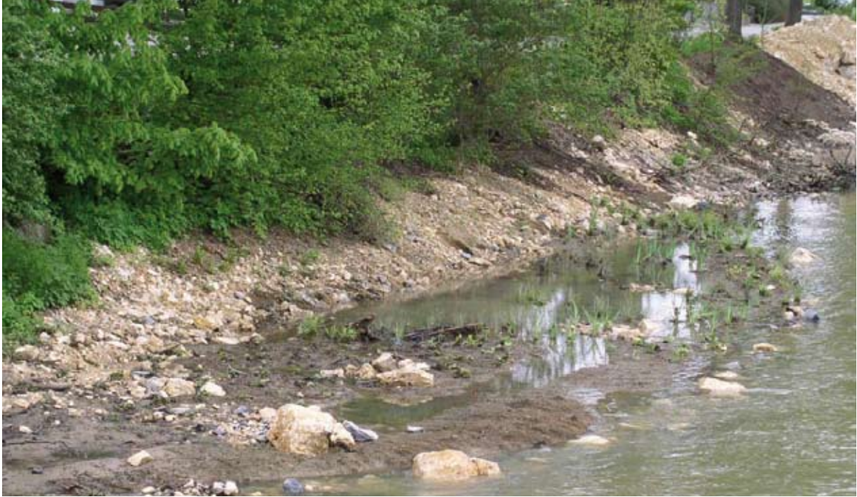
Eingebaute Vegetationswalzen unmittelbar nach Fertigstellung (2004)
