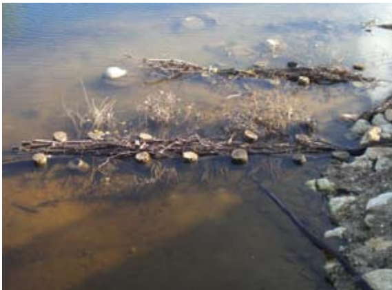
Gut sichtbar sind die untergelegten Querfaschinen der Lahnungen, die große Habitatvielfalt erzeugen
