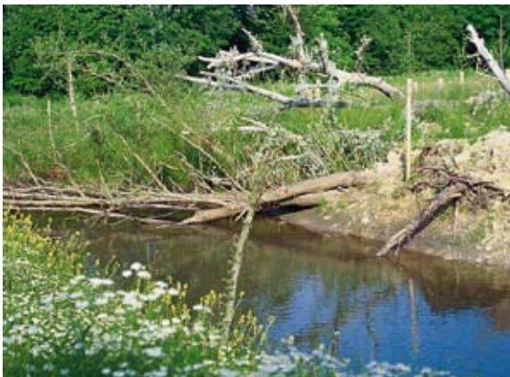
Die Raubäume wurden mit der Wurzel im Ufer eingebaut und verankert (II)
