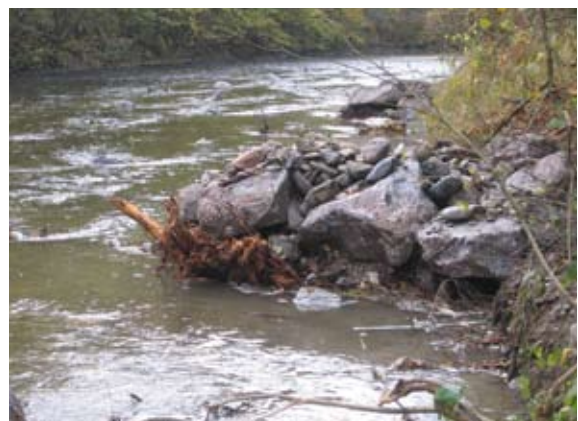
Wurzelstock durch Steinauflage gesichert
