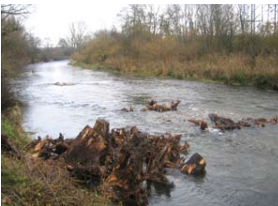
Eingebaute Wurzelstockbuhnen (2006)
