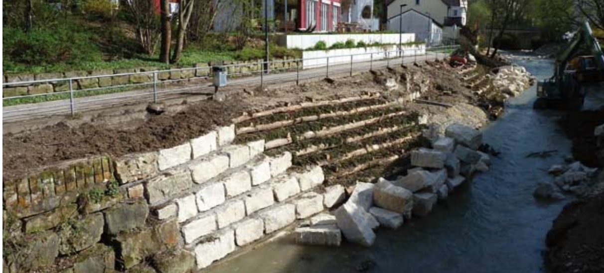
Fertiggestellte Krainerwand und Blocksteinmauer
