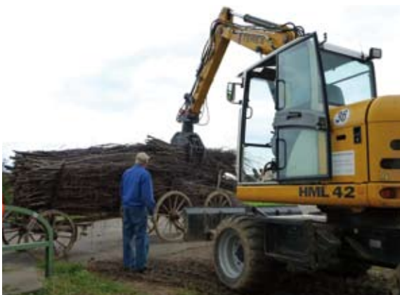
Wasserbau Gestern und Heute. zur Verfügung gestellte Faschinen vom Historischen Brauchtumsumzug Rheinhausen werden mit dem Bagger verlegt
