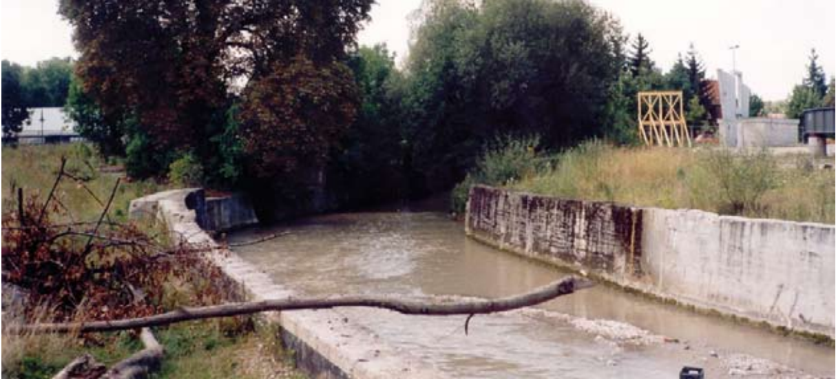
Echaz nach Abbruch der Gebäude (1998)
