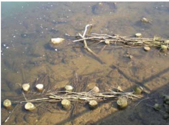
Lahnungen mit Sedimentationswirkung nach 2 Jahren
