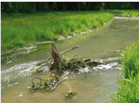
Baumstamm mit Wurzel-Bühnen nach ca. 5 Jahren, Eigenentwicklung gut sichtbar
