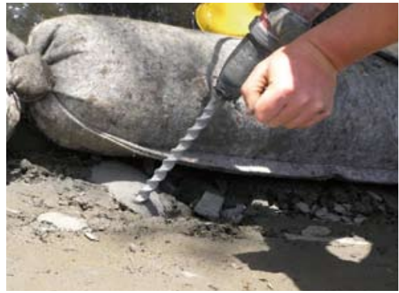
Vorbohren zum Setzen der Stahlnägel
