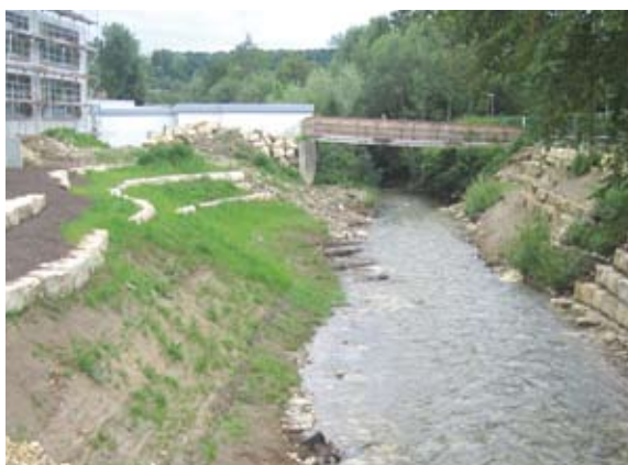
Baustelle nach Beendigung der Bauarbeiten
