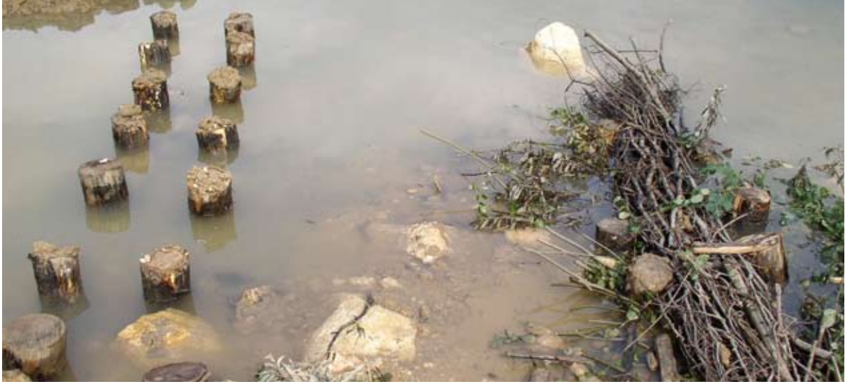
Bau der Lahnung (2007)
