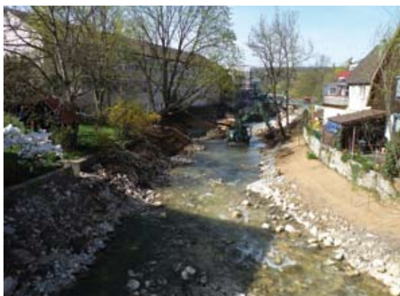
Böschungssicherung durch Kokosmatten
