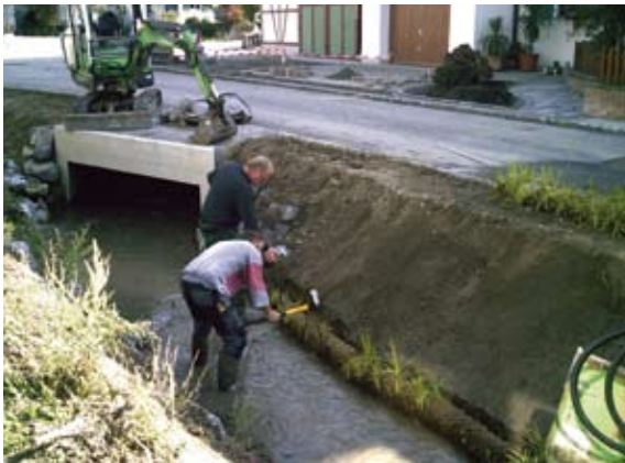
Sicherung der Vegetationswalzen
