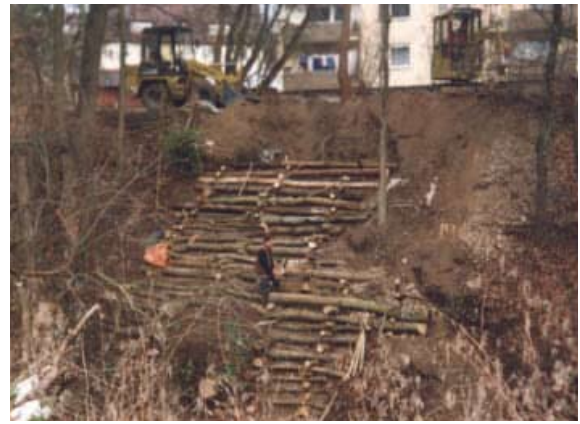
Wiederherstellung des Ufers mittels Krainerwand
