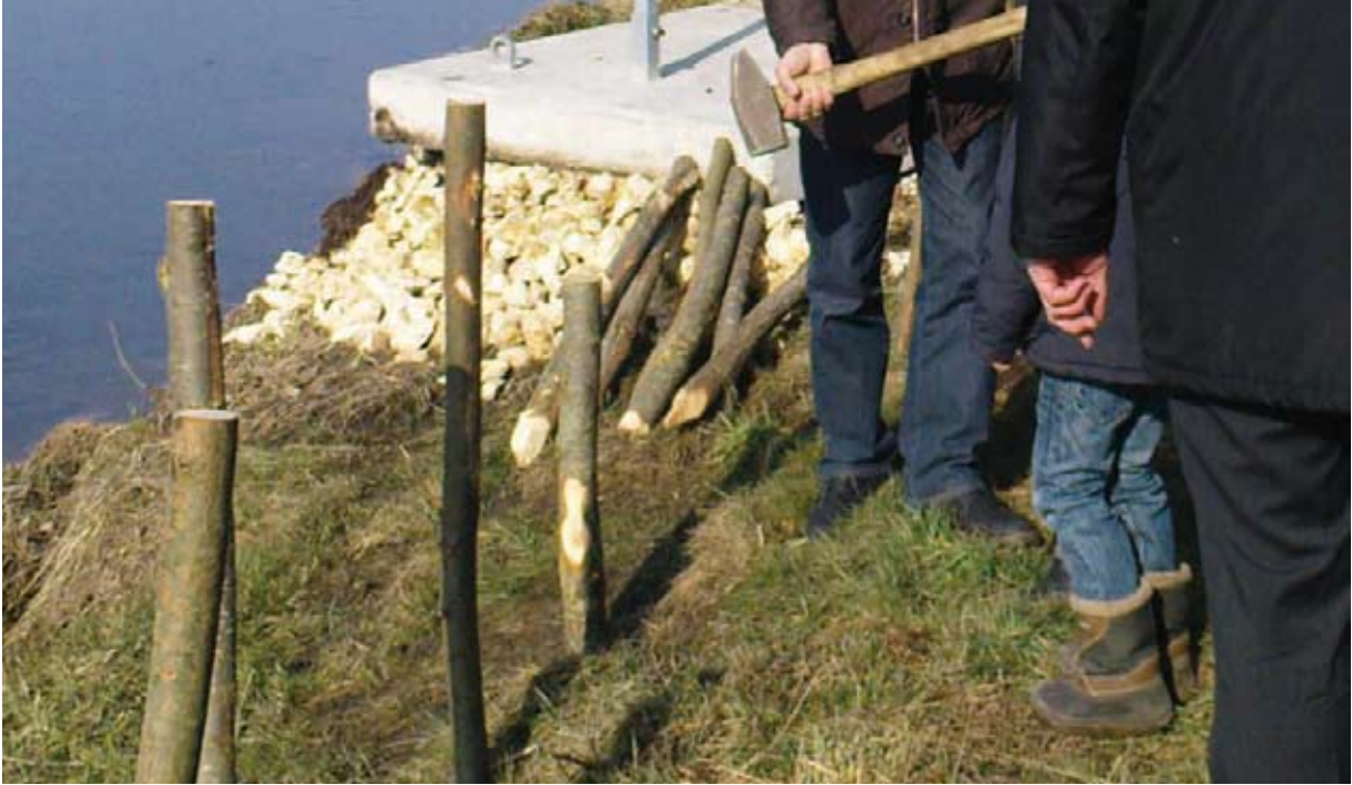
Einschlagen der Setzstangen mit dem Vorschlaghammer (2011)
