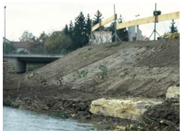
Austrieb im ersten Jahr nach Einbau
