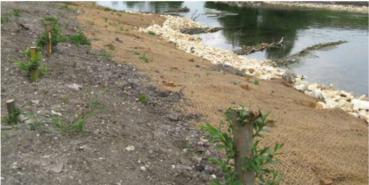
Austrieb der Setzstangen nach 8 Wochen
