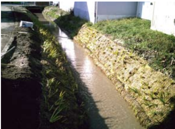
Böschungssicherung durch Naturtextil mit Röhricht
