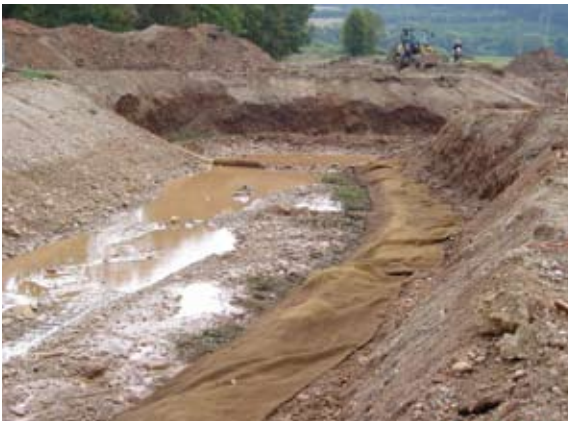
Die unterste Geotextilfaschine wird gefüllt und umgeschlagen
