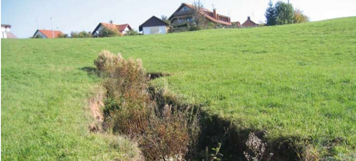
Tiefenerodierter Bach vor der Umgestaltung (2005)
