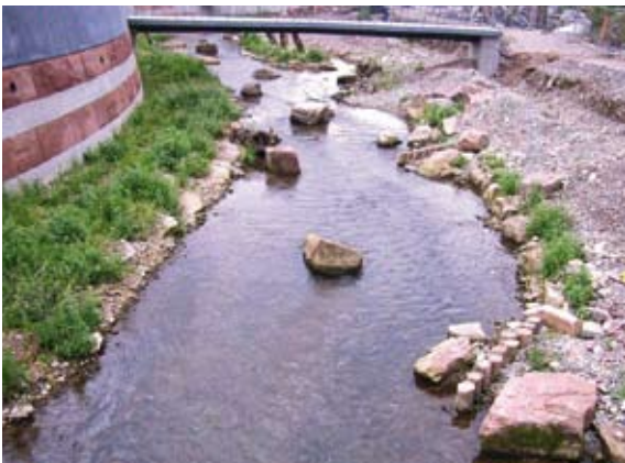
Naturnah gestaltetes Niedrigwasserbett mit Senkfaschinen und Pfahlbuhnen (2005)
