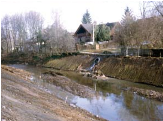
Weidenfaschine und Weidenspreitlage noch lose auf der Böschung
