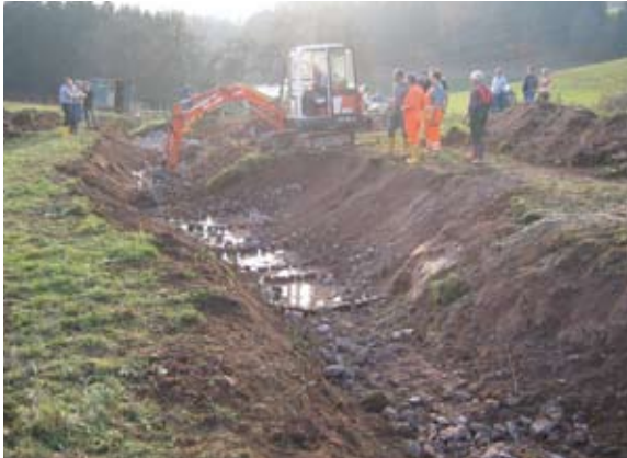
Sohlaufhöhung und Aufweitung mit unterschiedlichen Bauweisen
