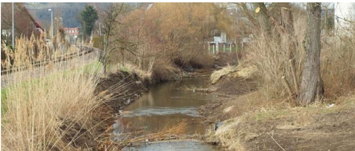
Nach Fertigstellung, Blick bachabwärts (II)
