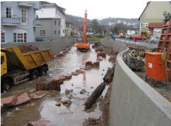
Einbau von Pfahlbuhnen (2004) (I)
