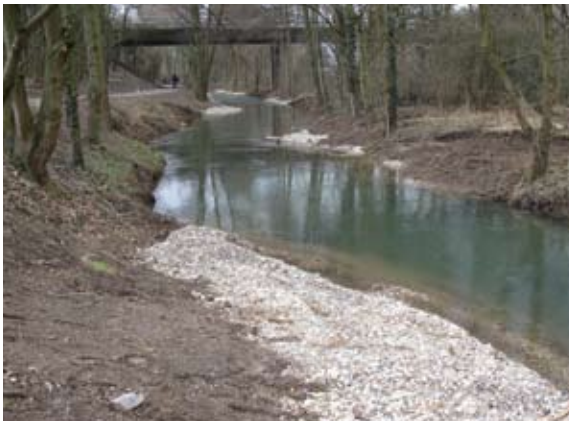
Gewässerumgestaltung mit Erhalt des vorhandenen Uferbewuchses Randbedingung: Umgebung mit umfangreicher Infrastruktur (2013)
