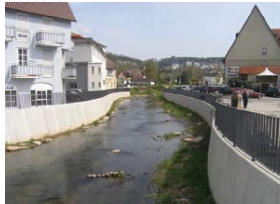
Pfahlbuhnen mit dahinterliegenden Tothholzfaschinen und Vegetationswalzen (2006) (III)
