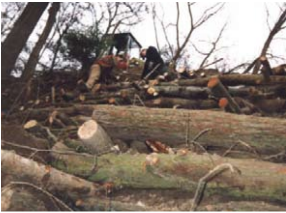
Bau der Krainerwand
