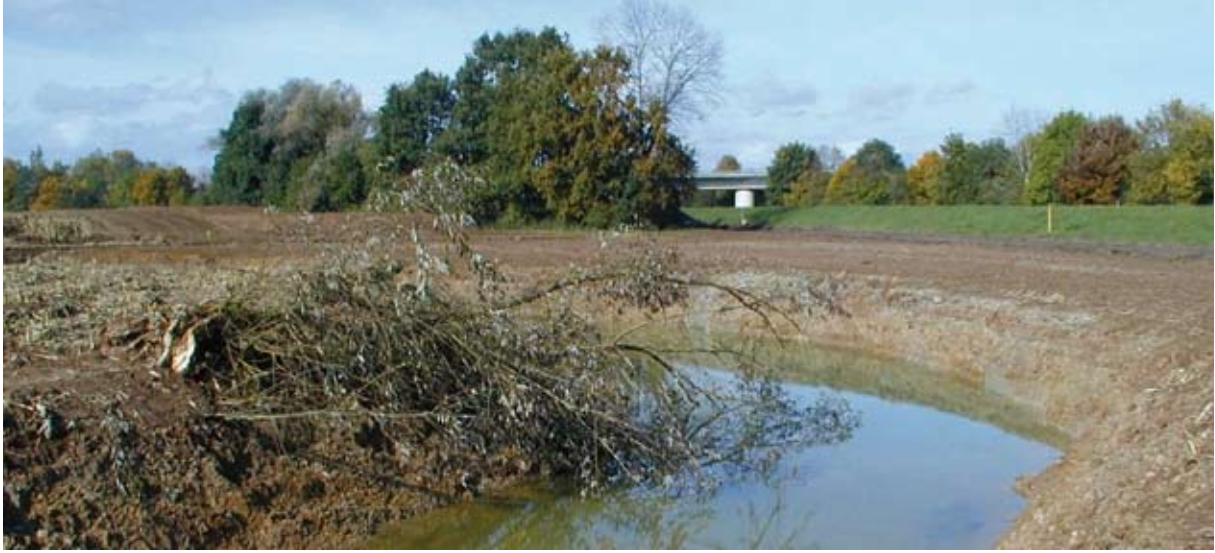
Neuer Schutterverlauf unmittelbar nach der Umbaumaßnahme
