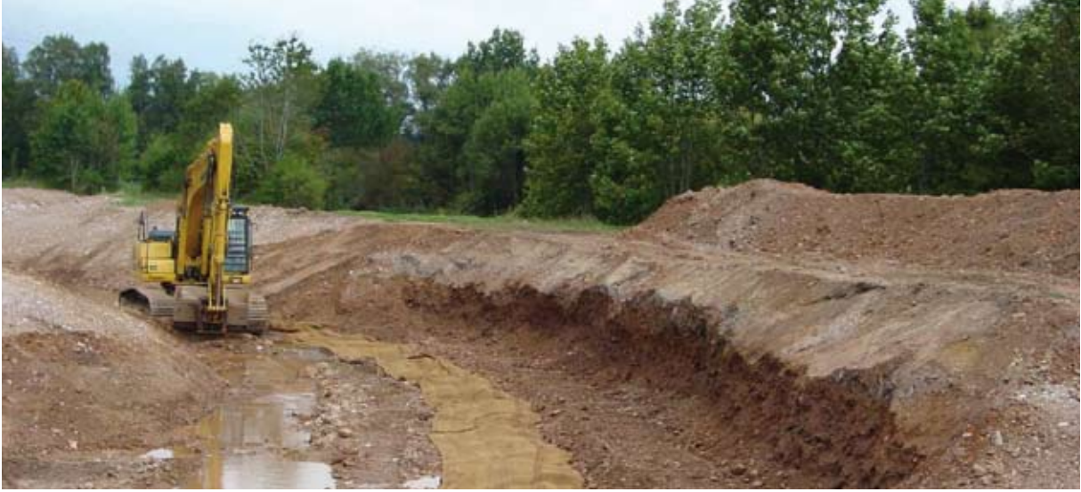
Vorbereitung für die unterste Lage der Geotextilfaschine (2012)
