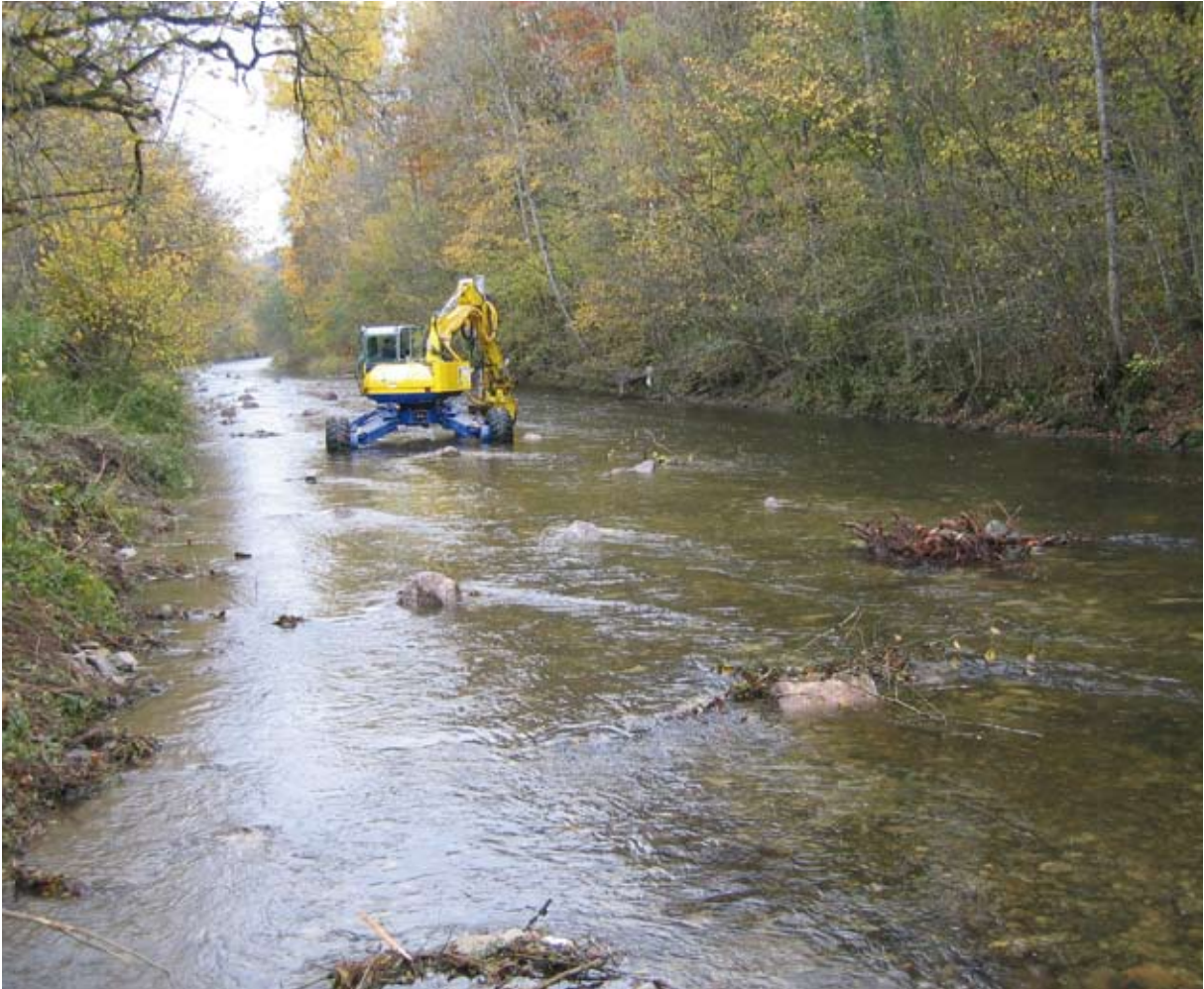
Einbau der Strukturelemente
