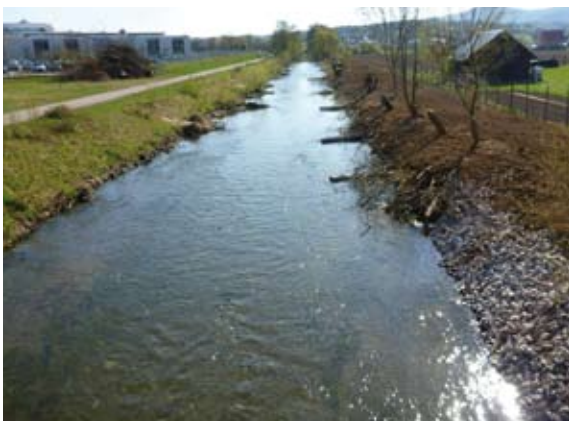
Gesamtansicht während Bauphase 2 im Frühjahr 2012: Fertig gestelltes linkes Ufer (1. Bauabschnitt), rechtes Ufer in der Bauphase
