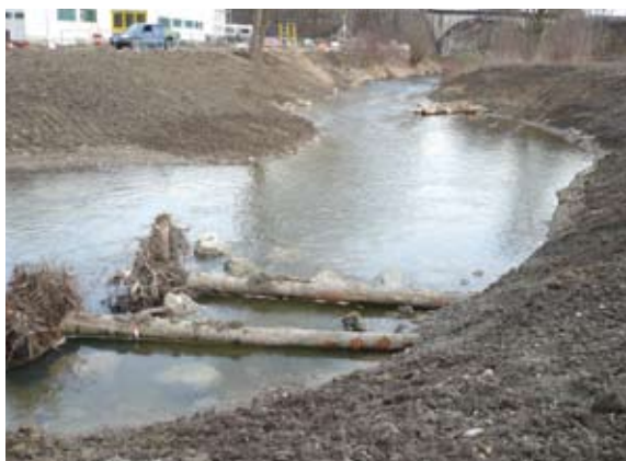
Fertig gestellte Wurzelbaumbuhnen (2010)
