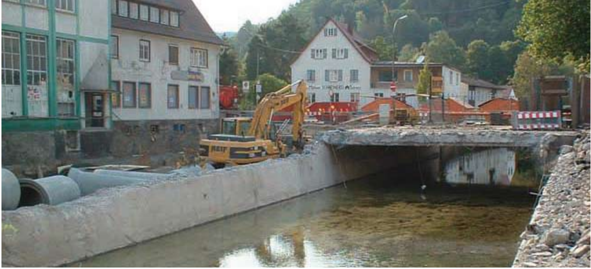
Abbruch der Betonplatte über der verdolten Waldach (2004)
