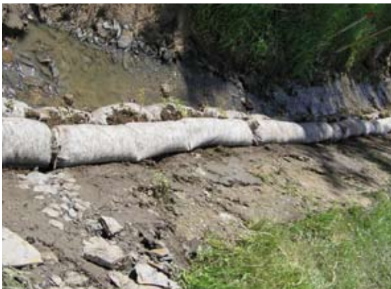
Bepflanzung der Zwischenräume
