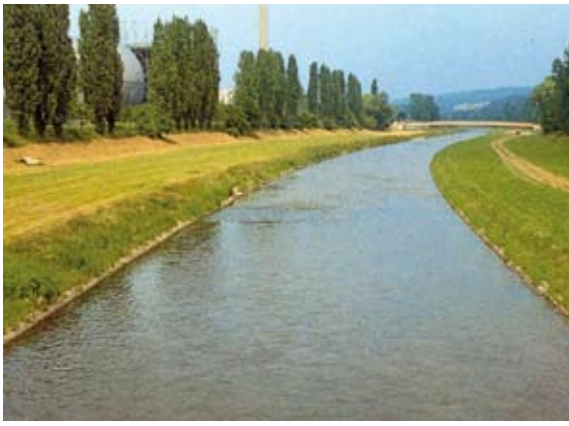
Die Enz als gehölz- und strukturloses, gleichbreites Doppeltrapezprofil (1990)
