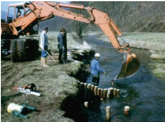
Einbringen der ca. 1,50 m langen Holzpfähle
