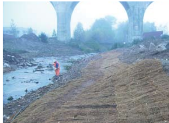
Einbau Erosionsschutzmatten (Oktober 2010)
