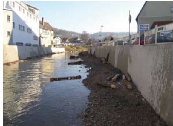
Fertiggestellte Pfahlbuhnen zur Strömunglenkung (2005) (II)
