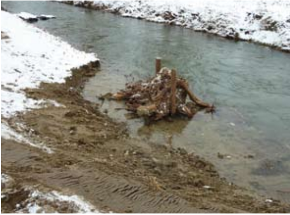
Ufermodellierung und Einbau der Wurzelstöcke (2010)
