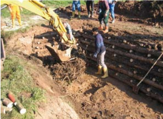
Einbau der Wurzelstöcke
