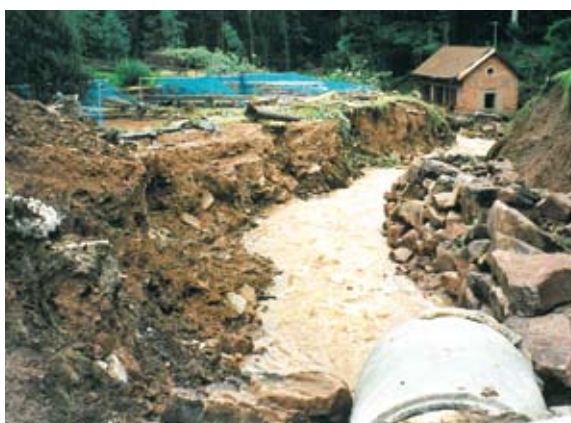
Hochwasserschäden bachabwärts der Unteren Kapfenhardter Mühle
