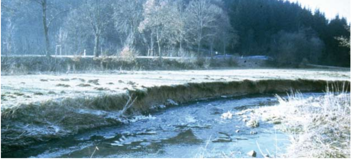
Ausgangszustand: Starker Seitenschurf im Prallhangbereich der Morre
