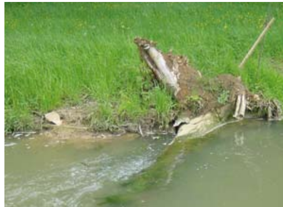
Baumstamm mit Wurzelstock als Leitbühne (2003)
