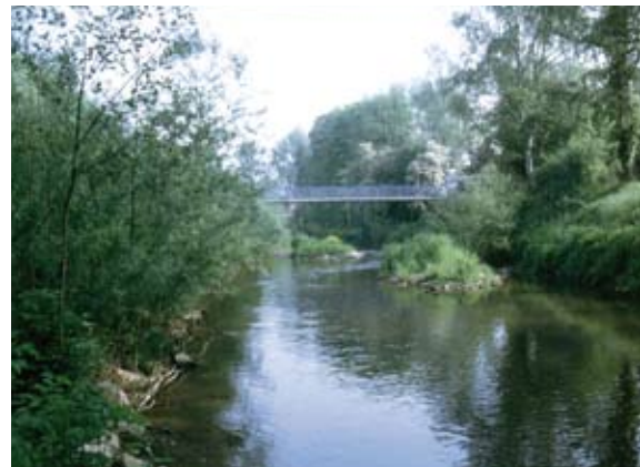
Ca. 3 Jahre nach Fertigstellung mit neuer Brücke am alten Standort
