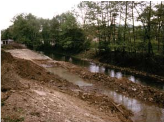
Erdarbeiten zur Gewässeraufweitung
