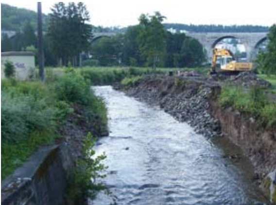
Abbruch Ufermauern (August 2010)
