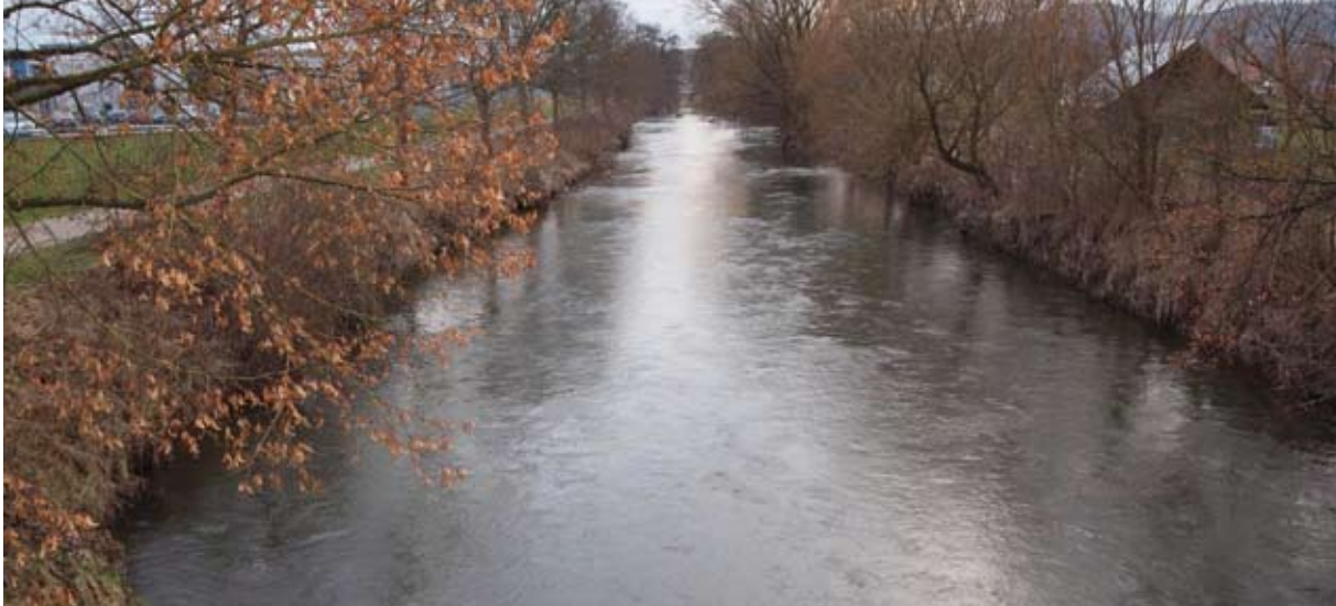
Strukturarmer Zustand mit problematischer Baumreihe und Ufererosion (links im Bild) vor der Maßnahme
