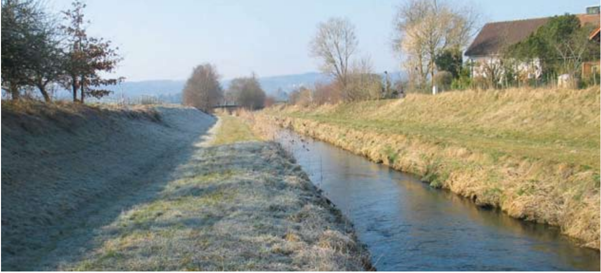
Seefelder Aach vor der Baumaßnahme (2009)
