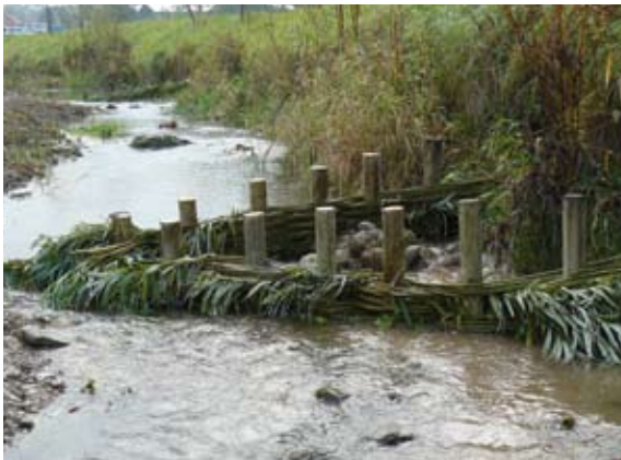
Einkürzen der Pfähle
