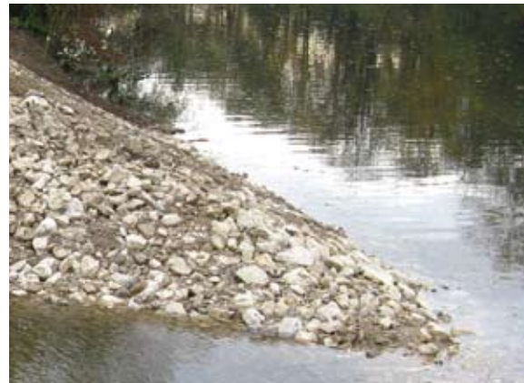
Böschungssporn zum Neckar mit Steinwurf LMB 5/40, Weidensteckhölzern (8 St/m²) und Überkiesung mit 0-80 Gemisch
