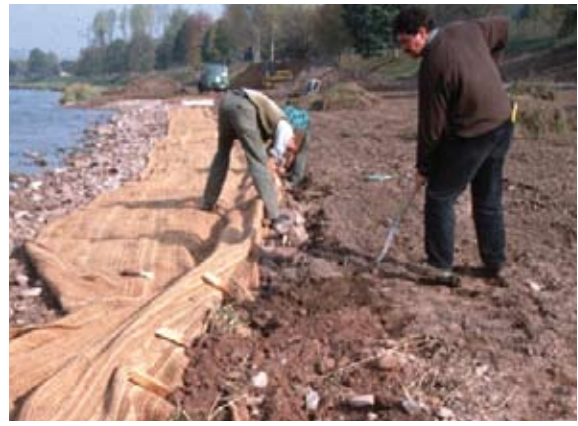
Bau 1990: eingelegte Soden, Verschließen des Gewebes
