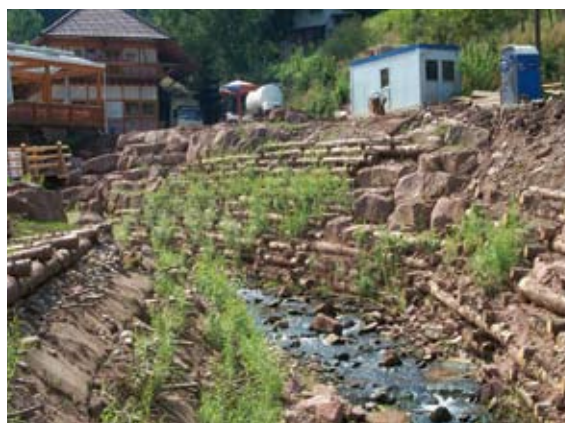
Geotextilsäcken, Krainerwand und grünbewehrter Mauersteinsatz. Erste Begrünung nach der Fertigstellung, Frühjahr 2000 (I)
