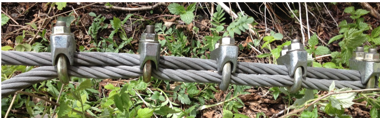
Abbildung 3: Linke zwei DSK mit richtigem Anziehdrehmoment auf geschmierten Teilen zur Kontrolle neu montiert im Vergleich zu den drei DSK rechts im vorgefundenen Ursprungszustand ohne sichtbare Seilklemmung.
