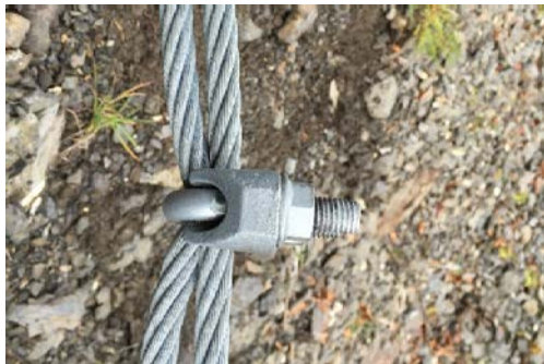
Abbildung 4: Seilklemmung bei einer DSK Grösse 16 welche nach EN 13411-5 geschmiert mit 49 Nm angezogen wurde.
