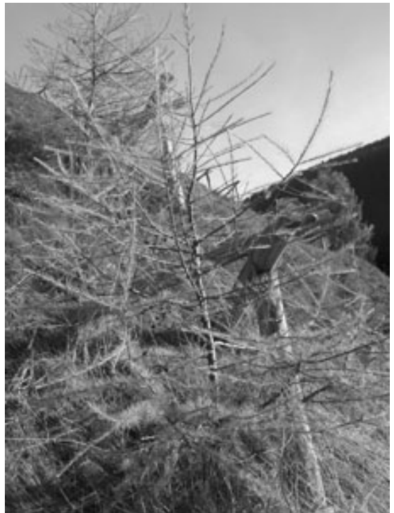
Abb. 90 Dreibeinbockanlage mit Lärchenaufforstung über einer Strasse, rechts eine Detailaufnahme (Bord/Ara, Davos, GR).
