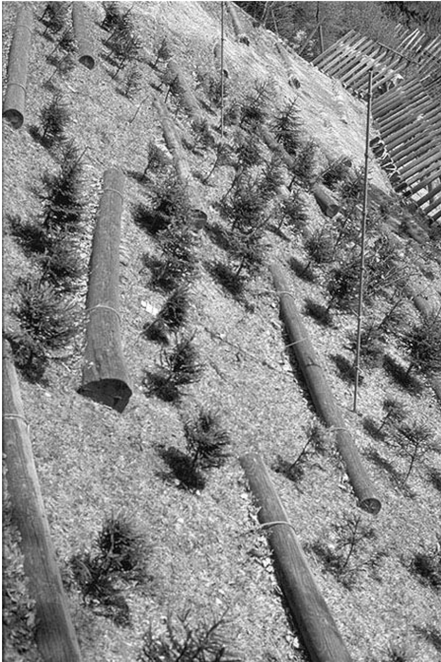
Abb. 9 Hang mit Schwellen und junger Aufforstung (SLF Versuchsanlage Bleisa/Pusserein, Schiers, GR)
