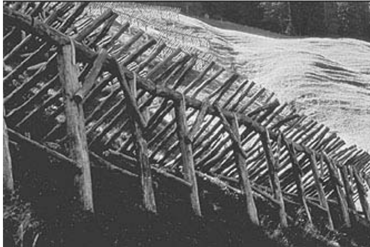
Abb. 51 Typ GL mit sogenannten Zangenverbindungen zwischen Stütze und Schwelle (Gerstboden, Elm, GL).
