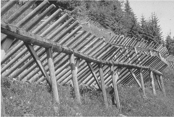
Abb. 48 Typ BE, ergänzt mit Dreibeinböcken (Hängeli-Lenk, BE).
