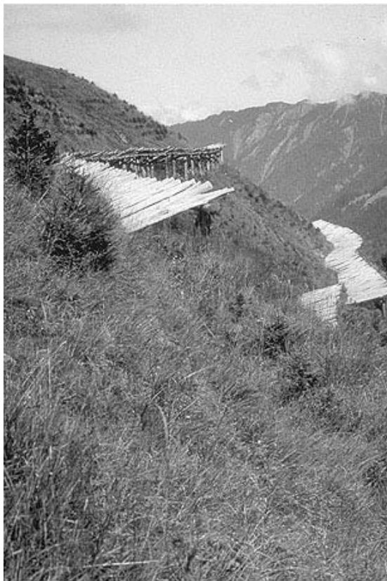
Abb. 52 Typ GR I mit extrem flachem Rost (Salpenna, Safien, GR) (links). Typ GR II mit sogenannten Schwenklatten auf der Rostoberfläche (Sponda, Stels, GR) (rechts).
