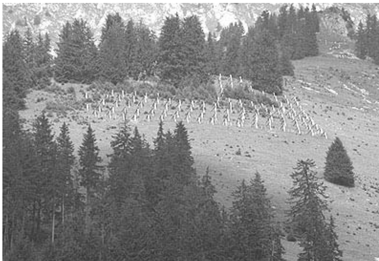
Abb. 87 Dreibeinbock-Anlage zum Schutz der Naturverjüngung (Jaun, FR).
