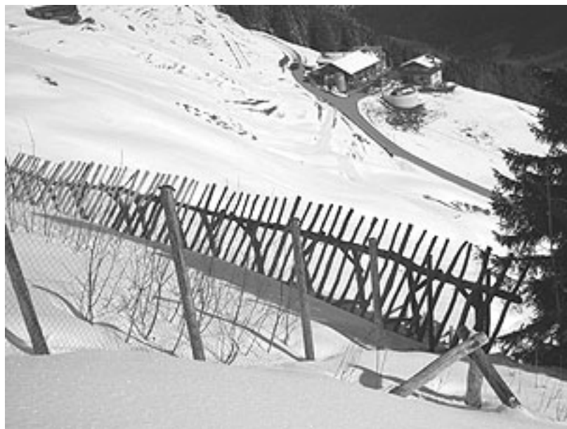
Abb. 33 In den Stützverbau integrierter Wildschutzzaun
