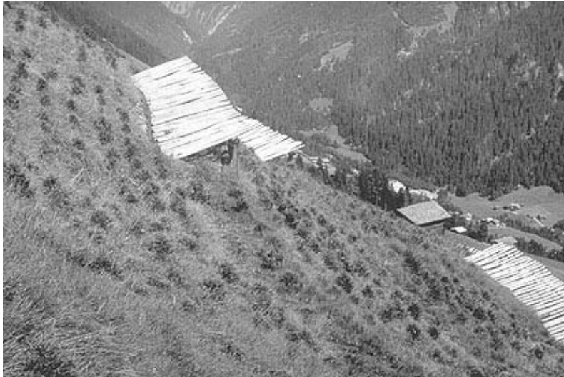
Abb. 60 Ein viel zu flach erstellter Rost; es kann zu Überführungen kommen (Obergün/Safien, GR). Rost 40° talwärts aus der Hangsenkrechten geneigt (tolerierbar: 15°±5°)!
