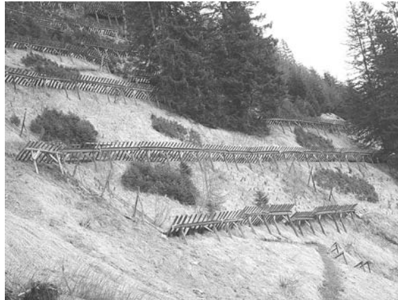
Abb. 17 Temporärer Stützverbau mit junger Aufforstung in Rottenstruktur
