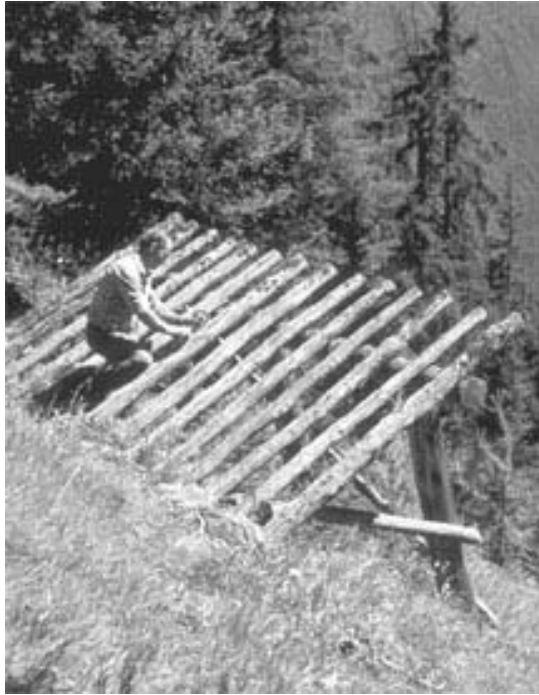
Abb. 57 Nach einer Standdauer von 25 Jahren ist der Verbau aus Lärchenholz noch relativ gut erhalten, das Holz ist gesund und weist lediglich geringen Flechtenbefall auf. Trotzdem kam kein Jungwald auf, da der Einfluss des Wildes vergessen wurde und kein Wildschutzzahn die Verjüngung vor Verbiss schützt (Jürada, Vna, GR).
