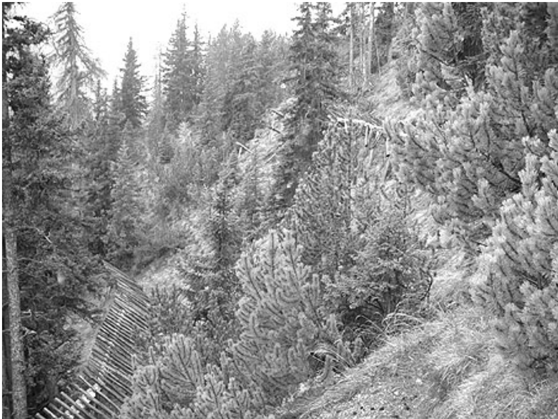
Abb. 71 Temporärer Stützverbau in Edelkastanie als Ersatz für die ursprüngliche, nach wenigen Jahren zusammengebrochene Verbauung aus Bergföhrenholz (Schattenwiesli, Davos, GR).
