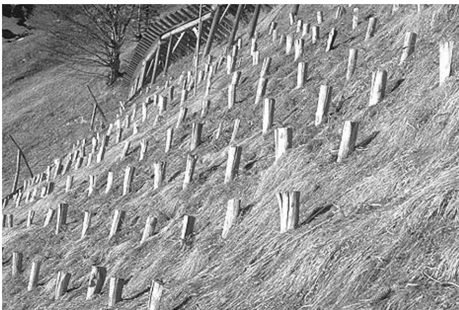
Abb. 12 Pfählung auf einem grasbewachsenen Hang (SLF Versuchsanlage Bleisa/Pusserein, Schiers, GR)
