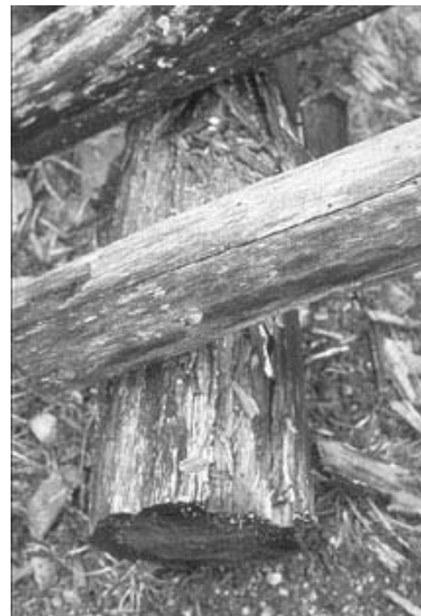
Abb. 56 Auch dies ein Werk aus Bergföhrenholz, das nach nur 12 Jahren bereits komplett zusammengebrochen ist. Die zu erwartende Standdauer gemäss technischem Bericht betrug 50 Jahre. Die Detailaufnahme rechts zeigt, dass die Schwelle bis in den Kernbereich hin angefault ist (Schattenwiesli, Davos, GR).
