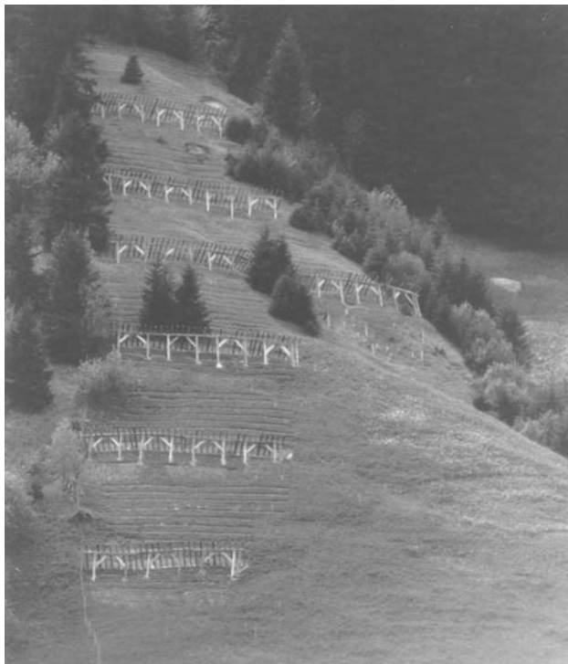
Abb. 75 Temporärer Stützverbau mit gut sichtbaren Breitbermen (Rösteli-Gilbach, BE).
