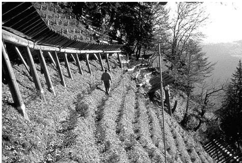
Abb. 6 Bermentrittanlage mit Jungpflanzung (SLF Versuchsanlage Bleisa/Pusserein, Schiers, GR)
