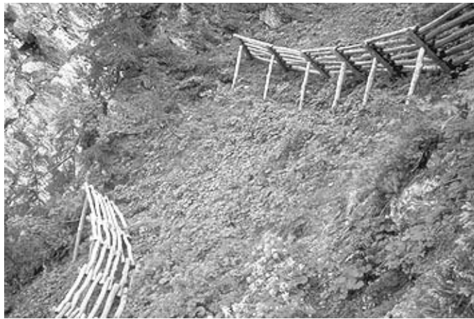
Abb. 54 Typ TI, Variante Brückenrost, Träger mit Zopf im Boden verankert (Garolge, Rodi, TI).
