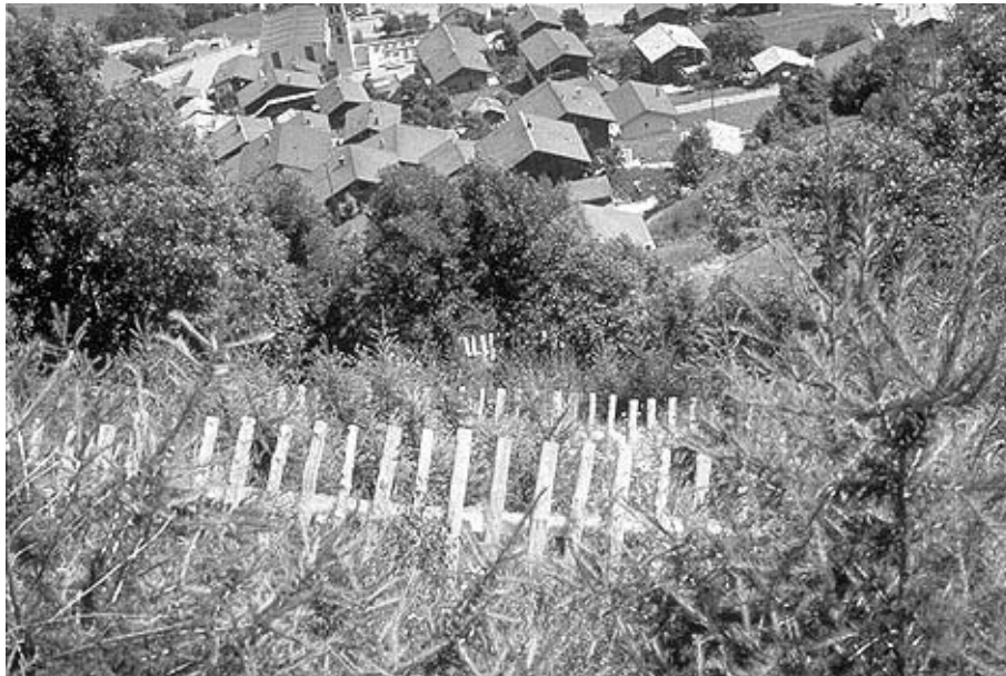
Abb. 16 Temporärer Stützverbau mit gut wachsender Aufforstung (Tähischru, Mund, VS)
