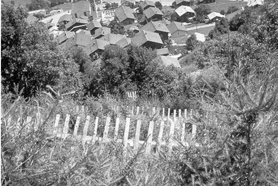
Abb. 68 Gut gebauter temporärer Stützverbau mit aufkommenden Jungbäumen oberhalb einer Siedlung (Tähischru, Mund, VS).
