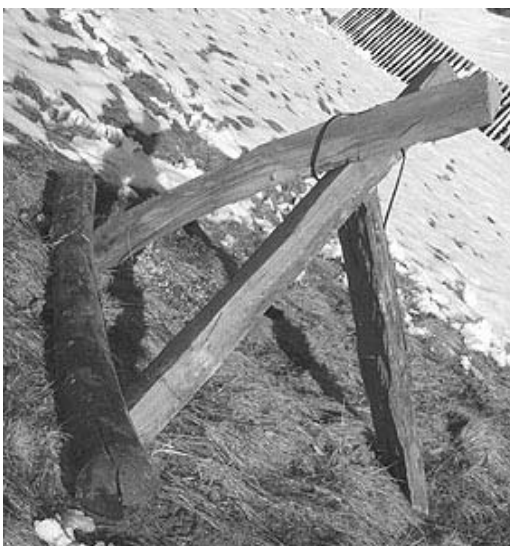
Abb 15a Herstellung von Dreibeinböcken
