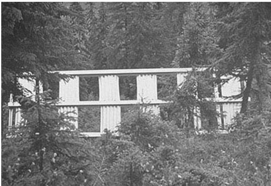
Abb. 67 Dieses deplazierte Werk, mitten in gutwüchsigem Waldgebiet, besteht aus Aluminium und entspricht keinerlei Vorgaben (Le Larzey, Finhaut, VS).
