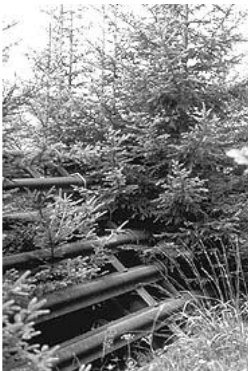
Abb. 65 Wird an gutwüchsigem Standorten (vgl. Abb. 64) ein Permanentverbau erstellt, wächst der Jungwald in die Stahlroste ein und die nötigen Pflegeeingriffe zur Entwicklung eines stabilen Bestandes können nicht getätigt werden. Ist ein Stahlverbau eingewachsen, lässt er sich zudem kaum mehr entfernen, ohne den umliegenden Wald wieder zu beschädigen (Jaun, FR).
