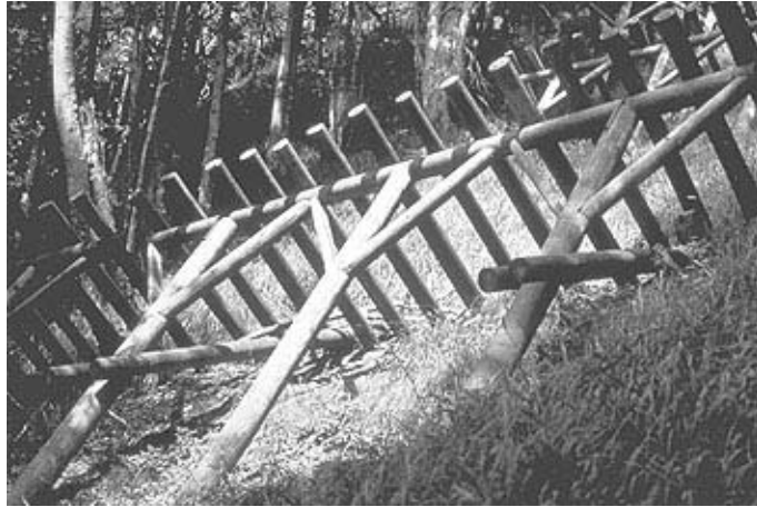
Abb. 53 Typ SZ mit Doppelzangen und enormem Holzverbrauch (Zingeln, Muotatal, SZ).
