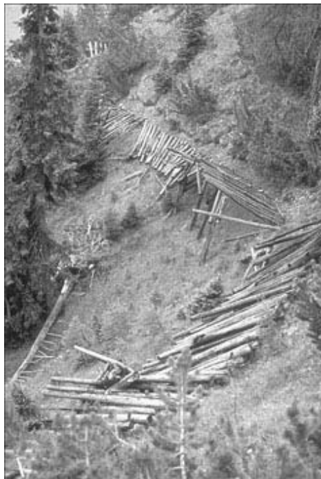
Abb. 56 Auch dies ein Werk aus Bergföhrenholz, das nach nur 12 Jahren bereits komplett zusammengebrochen ist. Die zu erwartende Standdauer gemäss technischem Bericht betrug 50 Jahre. Die Detailaufnahme rechts zeigt, dass die Schwelle bis in den Kernbereich hin angefault ist (Schattenwiesli, Davos, GR).
