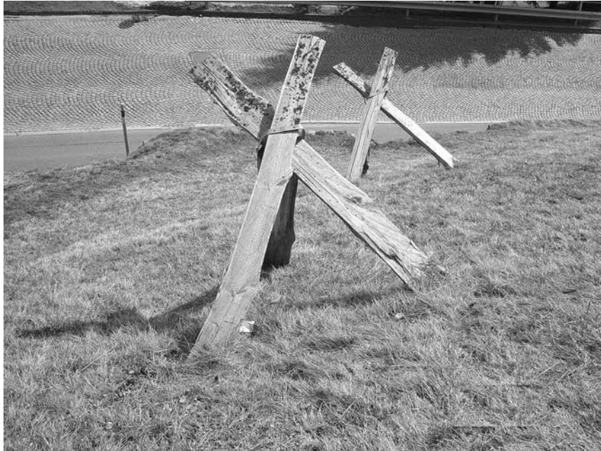
Abb. 4 Dreibeinböcke mit gut sichtbarer Schnittfläche gegen die Wetterseite
