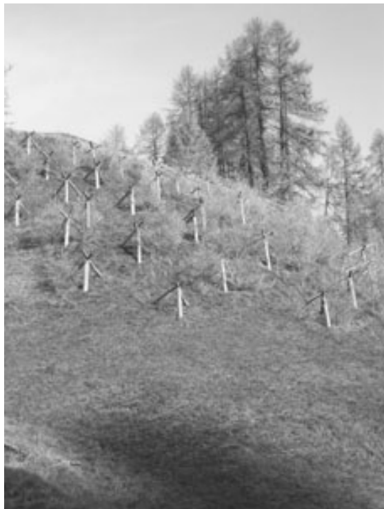
Abb. 90 Dreibeinbockanlage mit Lärchenaufforstung über einer Strasse, rechts eine Detailaufnahme (Bord/Ara, Davos, GR).
