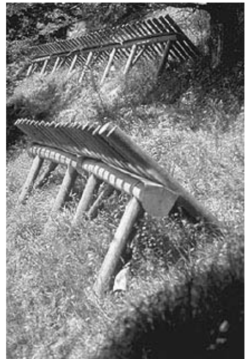
Abb. 49 Typ SLF, Variante Fichte/Tanne imprägniert mit Aluminium-Abdeckung der Pfette (Seewis-Pardisla, GR).
