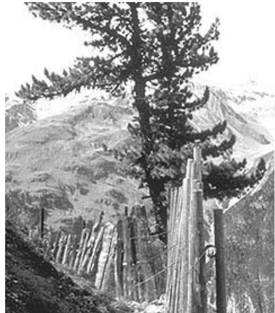
Abb. 61 Hier wurde gar kein Neigungswinkel des Rostes zum Hang berücksichtigt; der Rost steht senkrecht (Muot, Bergün, GR).
