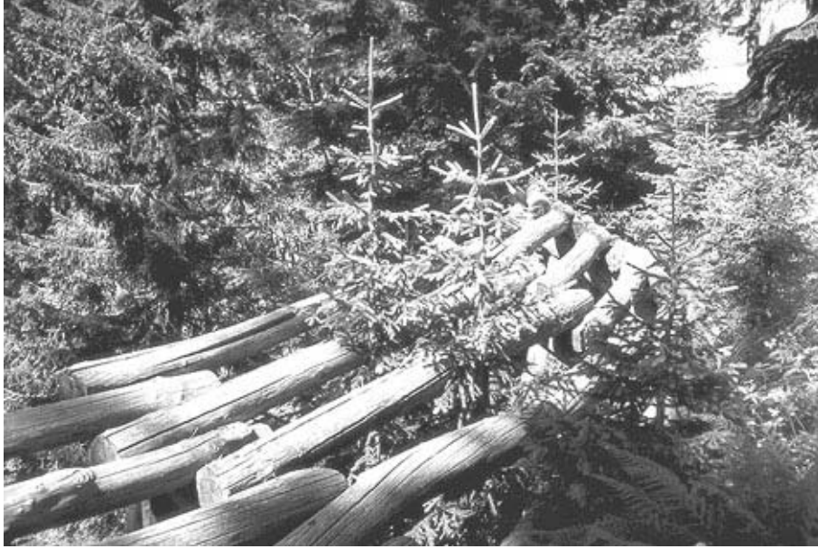
Abb. 70 Schneebrücken aus Edelkastanie im Jungwald aus Abb. 69; das Holz ist in einwandfreiem Zustand, die Jungbäume wachsen durch den Rost (Aquila, TI).
