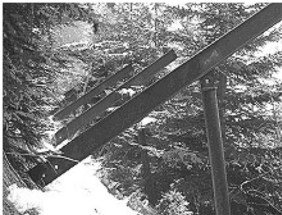
Abb. 91 Übriggebliebene Temporärverbauung mit Stahltragkonstruktion in Jungwald
