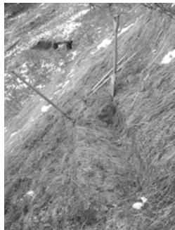
Abb. 8 Herstellung der Bermentritte
