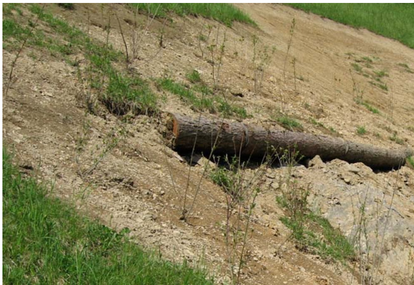
Heckensortiment-Pflanzung über teilweise eingedeckten, verankerten Lärchenschwellen, Engiberg, St. Niklausen (aus Quelle 5)
