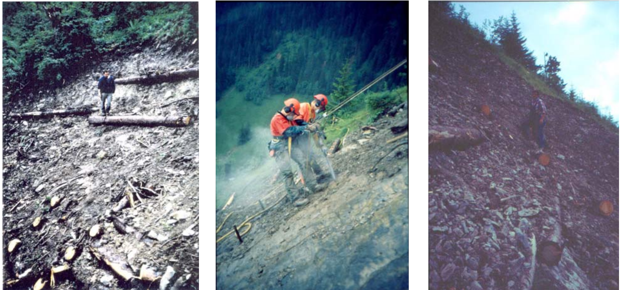
Verankerte Schwellen im Einzugsgebiet der Sachsler Wildbäche (aus Quelle 5)
