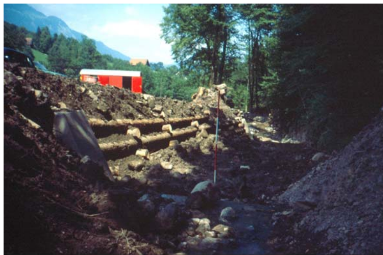
Einfacher Holzkasten entlang des Bitzighoferbaches (aus Quelle 5)
