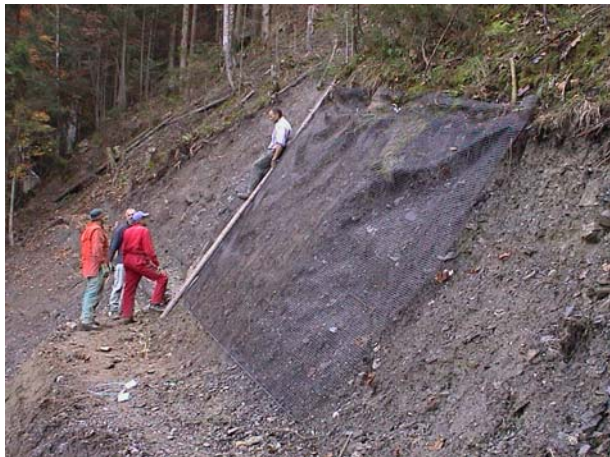
Einbau von verankerten Netzen im Muisschwändli, Sachseln (aus Quelle 5)
