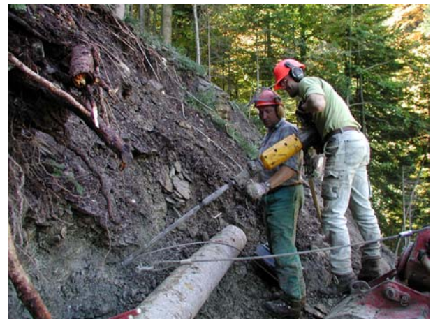
Ansetzen, Schlagen, Vorspannen und Verbriden eines Lockermaterialankers im Rufenprojekt Sachseln (Quelle 5)
