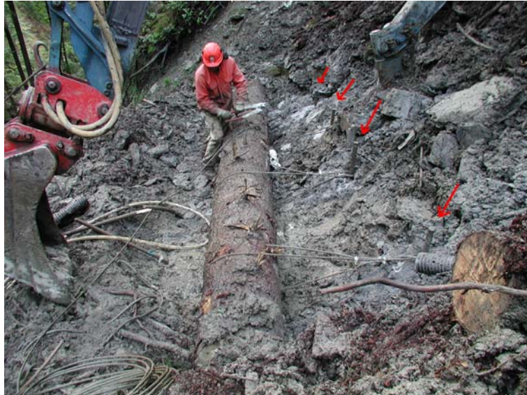
(Verankerung des Holzkastenfusses mittels gebohrten Ankereisen (Quelle 5))
