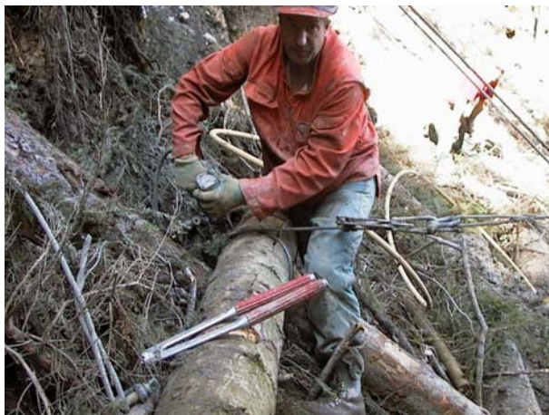
Ansetzen, Schlagen, Vorspannen und Verbriden eines Lockermaterialankers im Rufenprojekt Sachseln (Quelle 5)
