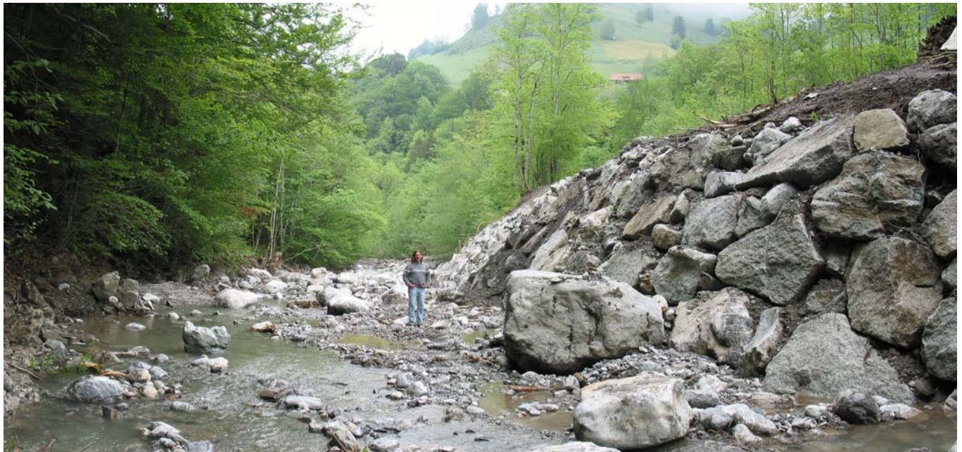
Blocksteinmauer entlang der Gr. Melchaa (aus Quelle 5)
