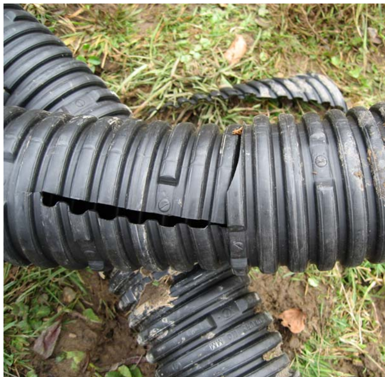
Eingeschnittenes, zusammengedrücktes Schlauchende in anderen Schlauch einschieben (Quelle 5)
