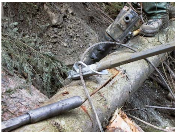
Ansetzen, Schlagen, Vorspannen und Verbriden eines Lockermaterialankers im Rufenprojekt Sachseln (Quelle 5)
