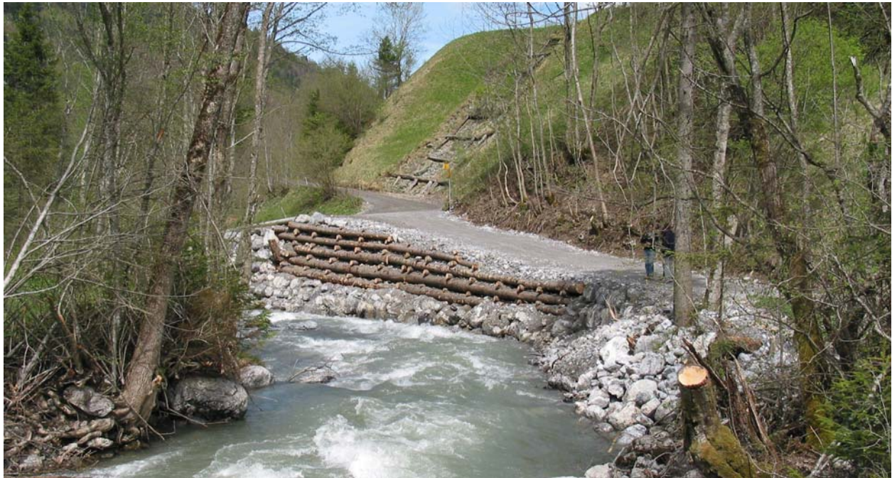
Doppelter Holzkasten entlang der Gr. Melchaa (aus Quelle 5)
