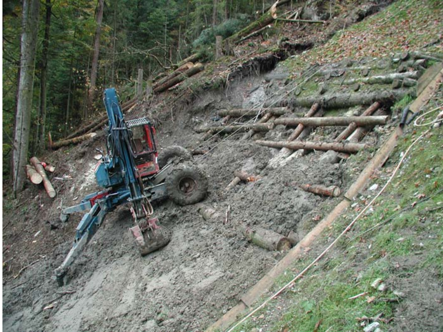
Beim Eindecken eines verankerten Hangrostes im Muisschwändli, Sachseln (aus Quelle 5)
