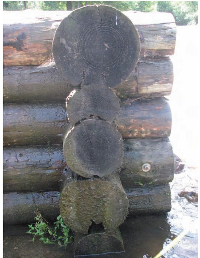
Assemblage des bois suivant la technique de la «fuste»
