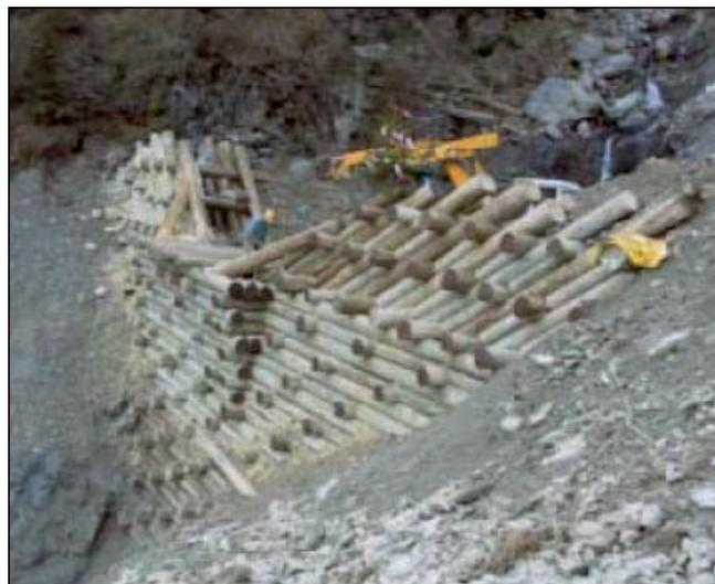
Barrage autrichien à ailes réalisées avec des longrines inclinées
