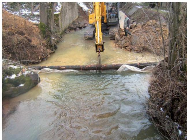
Installation d'un seuil à la pelle mécanique
