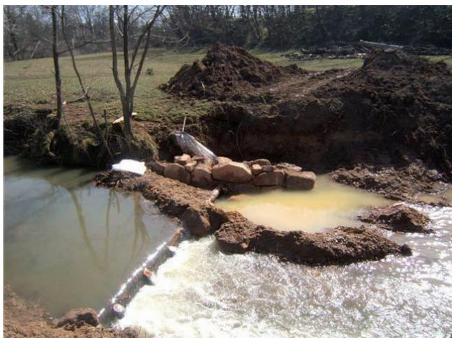
Enrochement de berge rive gauche pour ancrer l'ouvrage
