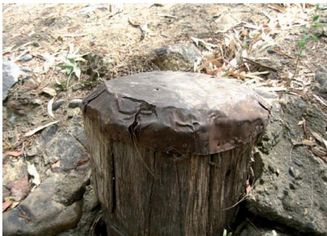
Protection sur tête de pieu d'ouvrage d'irrigation australien (Bonshaw weir)
