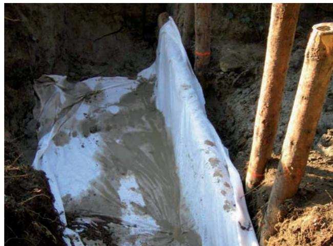
Installation d'un géotextile contre le parement amont de l'ouvrage
