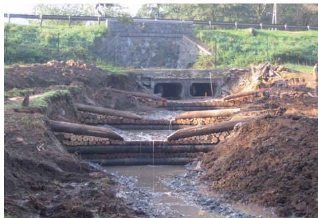
Barrage à doubles parois avec parement réalisé en rondins disposés parallèlement aux traverses
