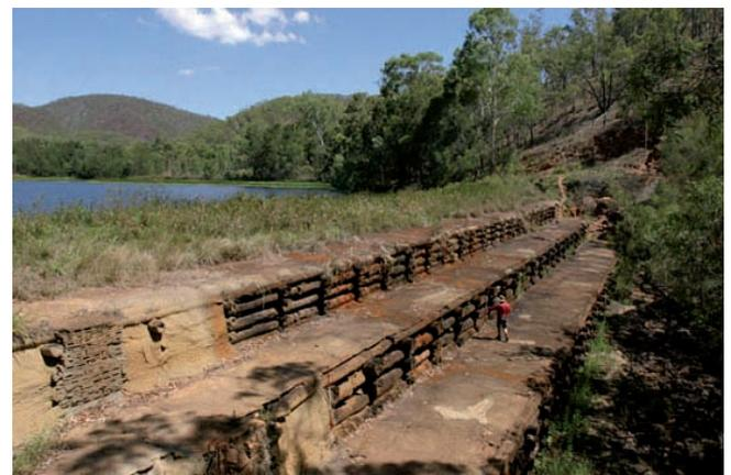
Barrage en remblai et déversoir en caissons en bois de Loudon Mill à Irvinebank, nord Queensland (Australie). Construit en 1943, il est toujours en utilisation
