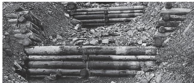
Barrage à doubles parois avec parements sur le même plan que les longrines
