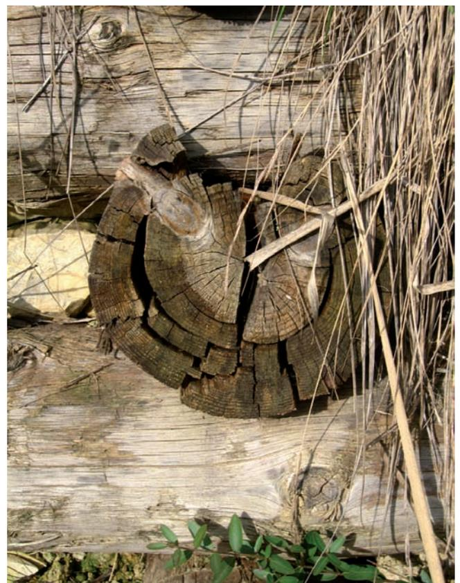
Dégradation rapide des traverses d'un ouvrage en mélèze d'Autriche de 2003 par des pourritures cubiques
