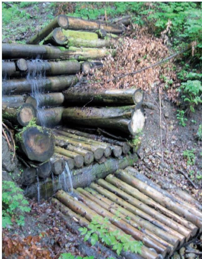
Barrages à simple paroi avec dispositif anti-affouillement
