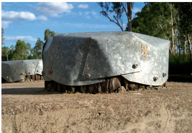
Protection sur tête de pieu d'ouvrage d'irrigation australien (Silveleaf weir)
