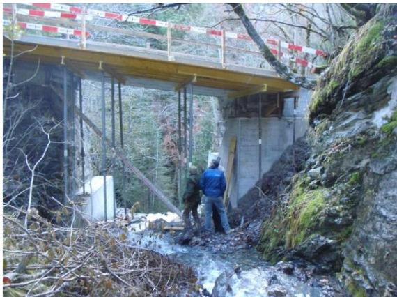
Illustration 3 Assainissement du pont sur la Sulzelruns (bassin:  $1.7 \text{ km}^2$ ;  $HQ_{\text{max}}$ : env.  $24 \text{ m}^3/\text{s}$ ).
