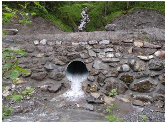
Illustration 4 Remise à neuf de l'aqueduc de la Teufruns sur la Krauchtalstrasse (bassin  $0.25 \text{ km}^2$ ;  $HQ_{\text{max}}$ : env.  $4.5 \text{ m}^3/\text{s}$ )
