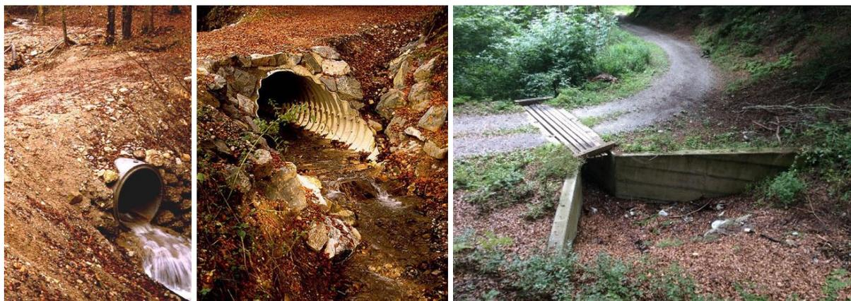
Effets positifs: Le passage pour la faune est facilité, le lit est continu et proche de l'état naturel, la capacité d'écoulement est améliorée, l'écoulement est continu, l'entretien plus facile. Seul bémol : le recouvrement de l'aqueduc est probablement insuffisant.
