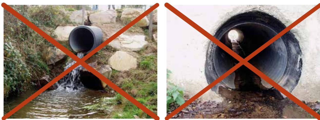
*L'ouvrage devra être positionné au plus près de la pente naturelle du cours d'eau. Lorsque ce type d'ouvrage est envisagé, les aqueducs carrés sont à privilégier car ils limitent la mise en charge et fournissent une meilleure luminosité que les aqueducs ronds.*
