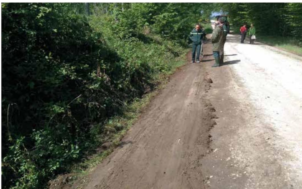
Travaux d'arasement des accotements en cours : l'eau de ruissellement pourra s'écouler vers les côtés
