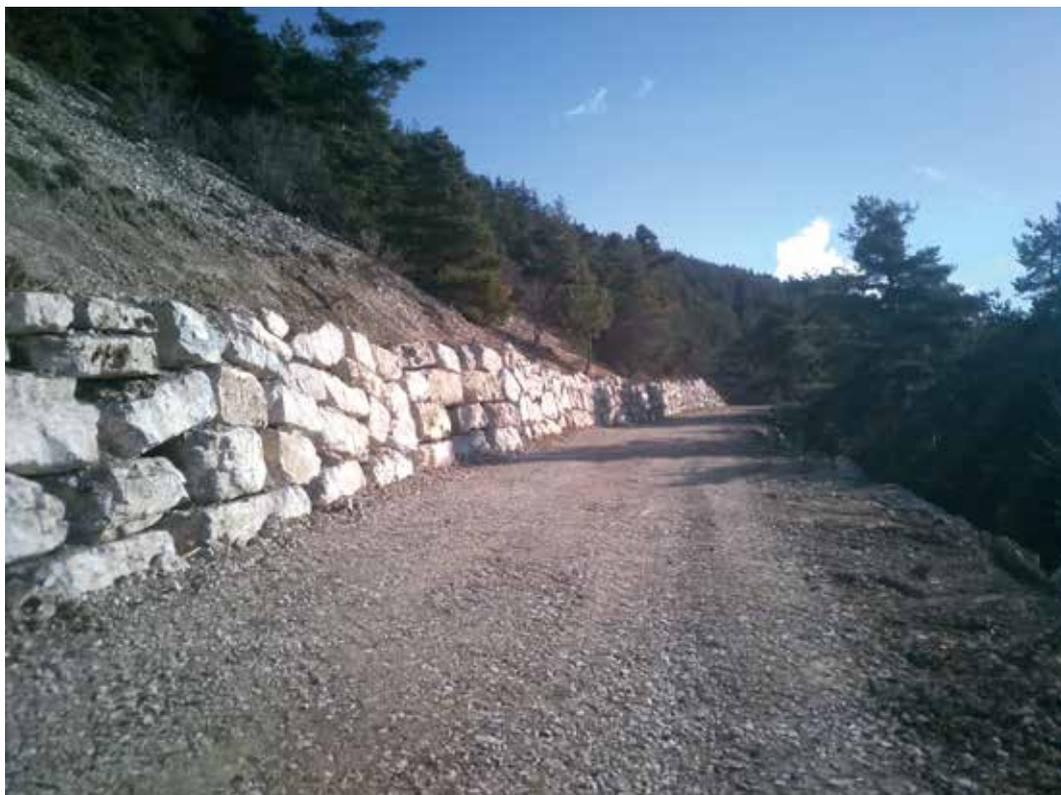
Mur de soutènement d'un talus amont en enrochement sec en forêt communale de La Mure-Argens (04)
