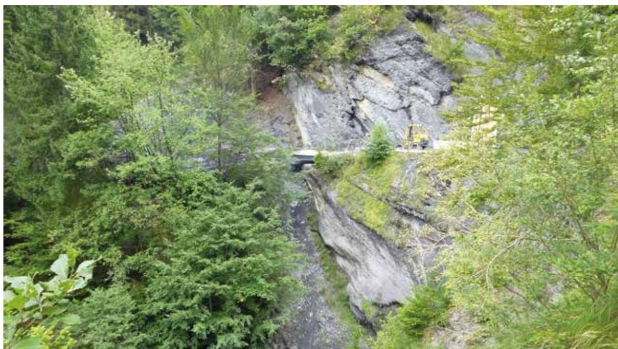
*Pont avec culée en béton armé, poutres principales en acier et platelage transversal en bois sur la route forestière de La Trappe à Passy (74)*
