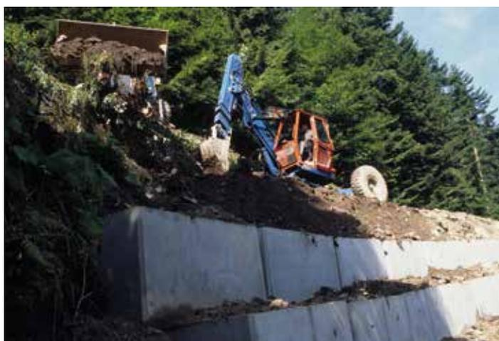
Travaux de retenue d'un talus par caissons en béton en forêt domaniale de St-Hugon (38)
