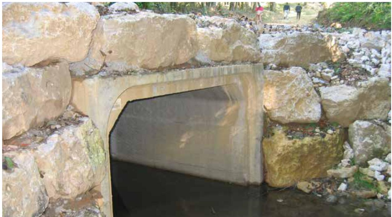
**MISE EN ŒUVRE D'UN AQUEDUC-TUYAU EN FRANCHISSEMENT DE TALWEG OU DE COURS D'EAU**
