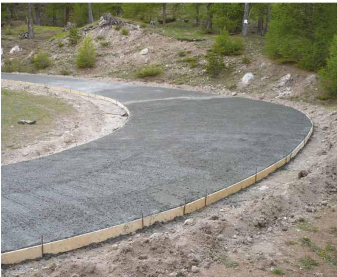
*Chaussée béton striée en renforcement et stabilisation de virage*
