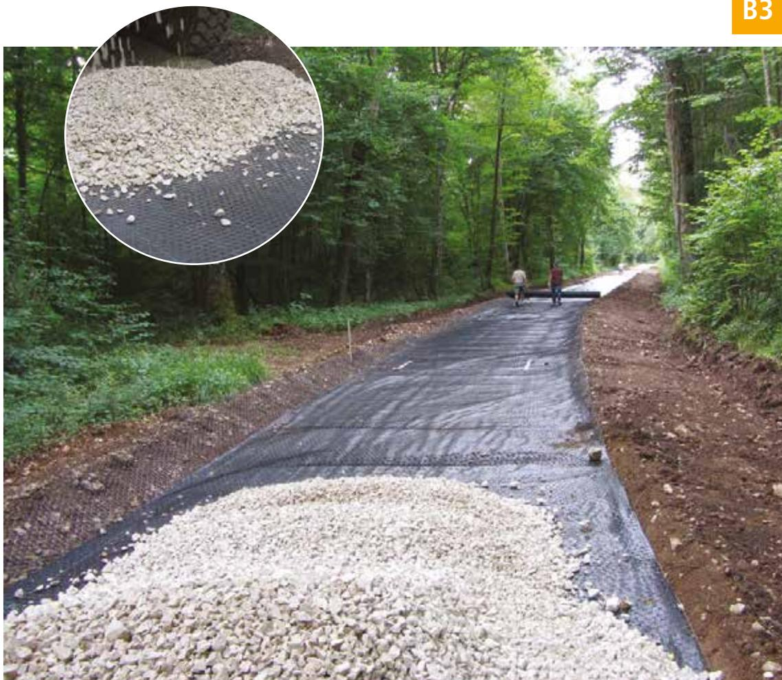
Mise en œuvre de la géogrigle et des matériaux sur la route forestière du Val de l'Ane en forêt communale de Lay Saint Rémy (54)
