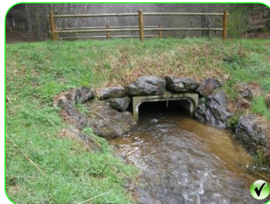
Buse cadre enterrée au 1/3
