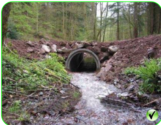
Buse circulaire enterrée au 1/3
