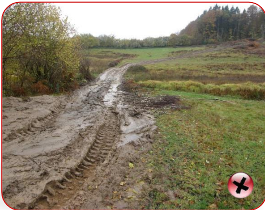
Erosion de piste
