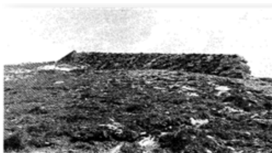
Cliché 31. Vue générale du mur de pierre de 4 m de haut situé au vent de la zone de départ d'avalanche (altitude 2600m) _ Faldum (F. Sivardière, T. Castelle).
