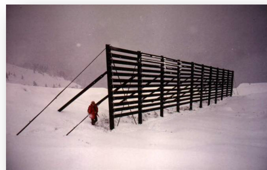
Cliché 52. Barrière à neige métallique à contrefiches sous le vent, haubanage de tête et raidissement des modules d'extrémité par câbles d'acier Col du Brenner, Italie (JM Taillandier/Irstea).
