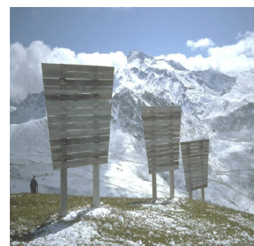
Cliché 84. Macot-La Plagne_ St Jacques : vire-vent à tablier bois trapézoïdal, portés par 2 poteaux métalliques et installés en rebord du couloir CLPA n°11 (ONF_DT RTM ; août 2012).
