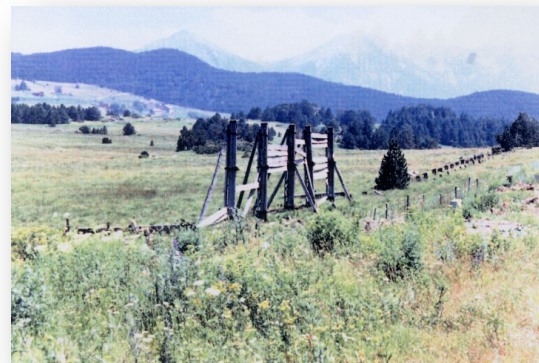
Cliché 29. Barrières à neige protégeant l'aérodrome du Col de La Quillane (2 nd guerre mondiale - installation allemande)
