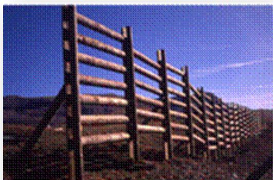
Cliché 45. Barrière à neige bois "Rondino" avec tablier à lattes parallèles au sol et contrefiches sous le vent.
