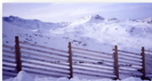
Cliché 46. Barrière à neige bois avec tablier à lattes horizontales en escalier et haubanage par câbles d'acier.
