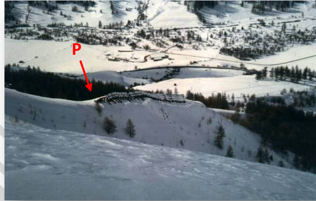
Cliché 76. Alignement d'ouvrage à vent (pupitres P à droite et toits-buses à gauche) en crête orientale du couloir du Combal _ FD RTM Larche (cliché RTM 04).
