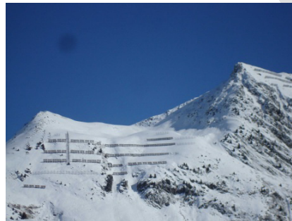
Cliché 81. Macot-La-Plagne_Grand Lognan, ensemble du dispositif paravalanche composé d'ouvrages à vent et de rétention (ONF-RTM 73).
