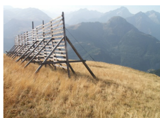
Cliché 87. Auris-en-Oisans _ Signal de l'Homme : Barrières à neige à contreforts et haubans métalliques (ONF_DT RTM, août 2012).
