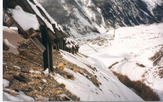
Cliché 70. Toits buses alignés en marge du couloir du Combal, Larche (04) (JM Taillandier/Irstea).
