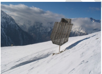
Cliché 91. Vire vent auto-orientable avec son sillage (ONF-RTM 38)
