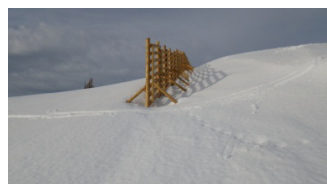
Cliché 92. Auris-en-Oisans Barrière à neige avec son dépôt de neige par vent de Nord-Ouest (ONF-RTM 38, déc 2012)
