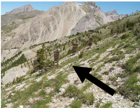
Cliché 98. Larche 04 _ couloir n°19 du Combal : Vire-vent, 1,7m x 2,6m, implantés en marge d'un panneau déclencheur d'avalanche (ONF_RTM 04).
