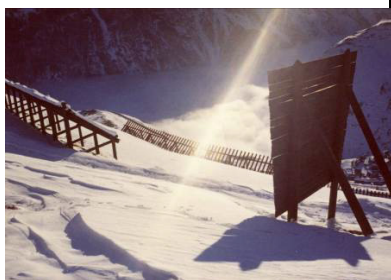
Cliché 95. La Grave _ Le Chazelet _ 05 – toits-buses et vire vent à tablier et contreventement (ONF_ RTM 05-mars 1974).
