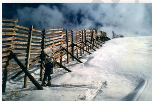
Cliché 47. Barrière à neige du Combal- Pichalp à Larche 04 (JM Taillandier/Irstea).
