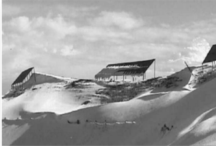
Cliché 73. En premier plan, toit-buse placé à cheval sur l'arrête, en arrière plan toit buse placé légèrement en contrebas (Chaudhary et Mathur, 2004)
