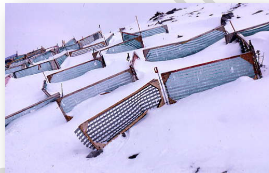
Cliché 44. Barrières à neige « de fortune » implantée pour créer un stock de neige à retravailler (G. Brugnot/Irstea).
