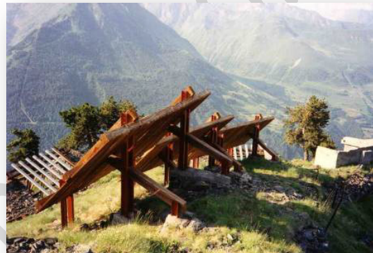
Cliché 72. Toits buses en crête du couloir du Theil _ FD RTM de Barèges (ONF RTM 64-65).
