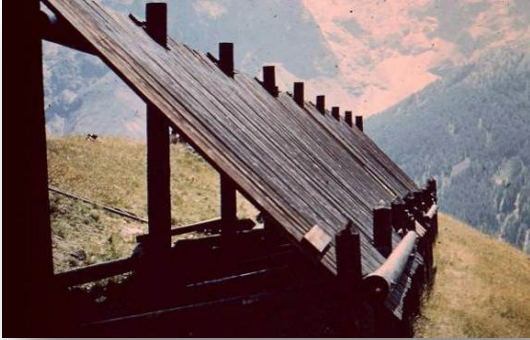
Cliché 69. Toits buses à 7 modules alignés en crête de versant, Le Chazelet - La Grave 05 (JM Taillandier/Irstea).
