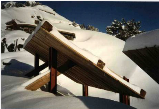
Cliché 71. Toits buses en crête du couloir du Theil _ FD RTM de Barèges (ONF RTM 64-65).
