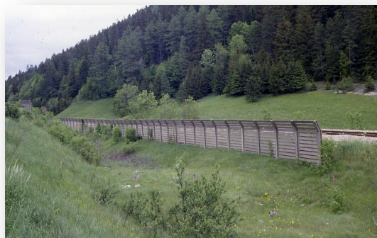
Cliché 53. Barrières à neige béton armée à lattes horizontales (F. Naaim/Irstea)
