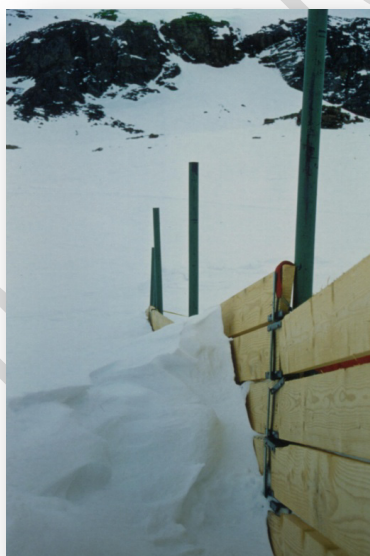
Cliché 32. Congère générée par une barrière pleine sans garde au sol (F.Naaim-Bouvet/Irstea)
