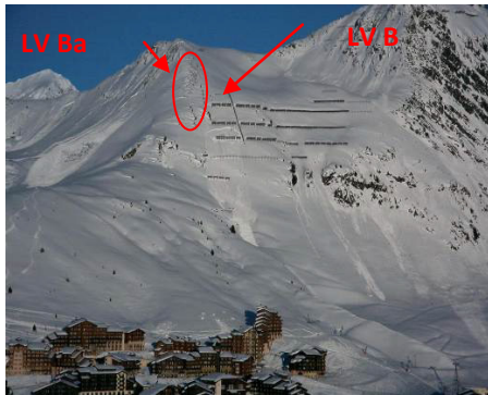
Cliché 78. Macot-La-Plagne (73)_Grand -Lognan : site équipé de barrières à neige (LVB) en pleine pente et de barrières auto-orientables (LV Ba) en marge Nord du couloir. (ONF- RTM 73).
