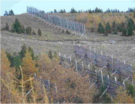
Clichés 97a et b. Larche 04 _ couloir n°19 et 20 de Combal : Barrières à vent avec sa zone de dépôt (à droite) et en hiver l'accumulation de neige sous le vent (ONF_RTM 04).
