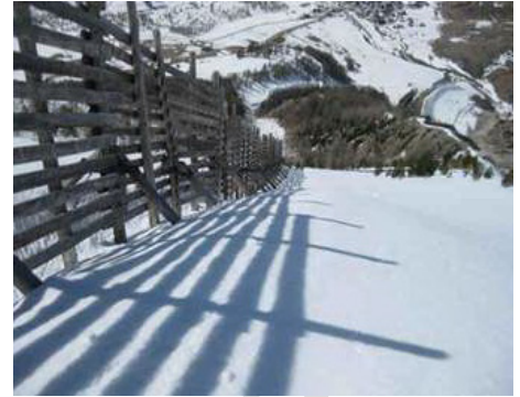
Clichés 97a et b. Larche 04 _ couloir n°19 et 20 de Combal : Barrières à vent avec sa zone de dépôt (à droite) et en hiver l'accumulation de neige sous le vent (ONF_RTM 04).
