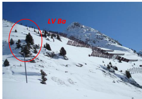
Cliché 79. Macot-La-Plagne_Grand –Lognan : le dispositif d'ouvrages à vent paravalanches (vire-vent auto –orientables (LV BA) et barrières à neige) associé au dispositif de rétention par lignes de râteliers et de filets paravalanches.(ONF-RTM 73).
