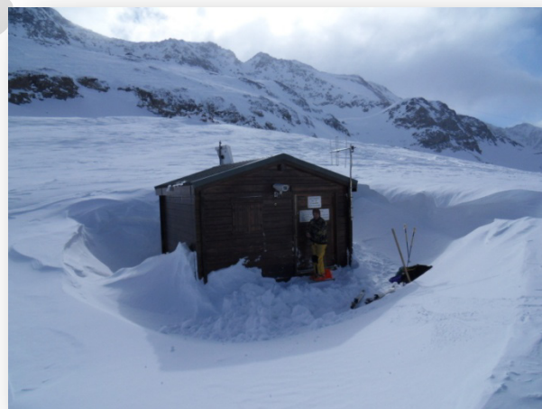
Cliché 12. Formation d'un cratère autour d'un bâtiment (H. Bellot/Irstea)
