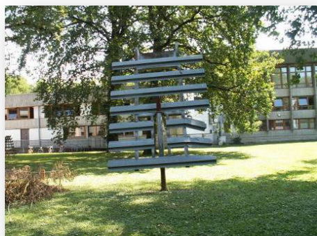
Cliché 54. Barrière auto orientable entièrement métallique (Cémagref).
