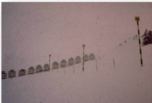
Cliché 56. Rangée de barrières auto-orientables et perches de suivi du transport de neige par le vent, Celliers, 73 (JM Taillandier)
