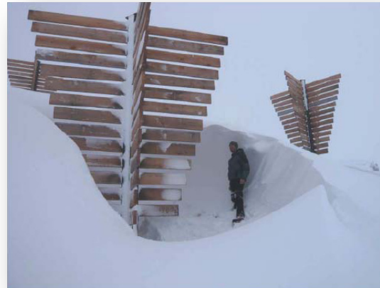
Cliché 62. Panneaux vire-vent en croix laissant apparaître la forme très visible du cratère (Gian Cla Feuerstein, AfW Zuoz, Switzerland)
