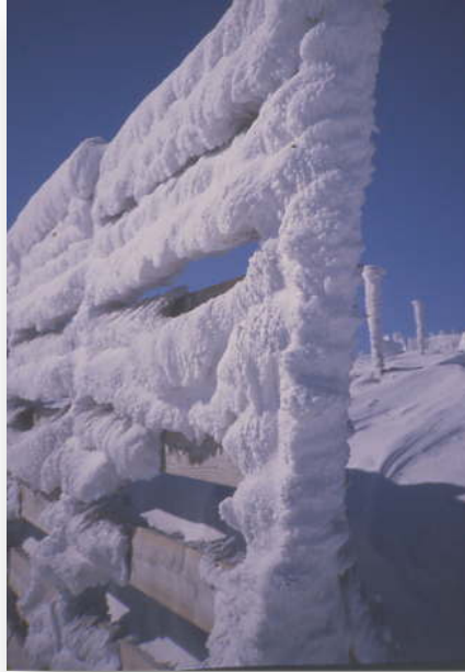
Cliché 37. Formation de givre obstruant les interstices d'une barrière à neige à Pierre/Haute (Bruno Janet/Irstea)
