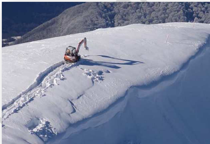
Cliché 75. Pelle mécanique sur la crête Aibga (Russie) (Margreth, 2010)
