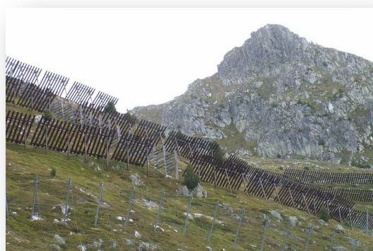
Cliché 48. Barrière à neige en escalier type Labouly du Grand Lognan, Mâcot La Plagne 73 (ONF DT RTM).
