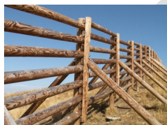
Cliché 88. Auris-en-Oisans _ Signal de l'Homme : Barrières à neige avec contreforts boulonnés (ONF_DT RTM, août 2012).
