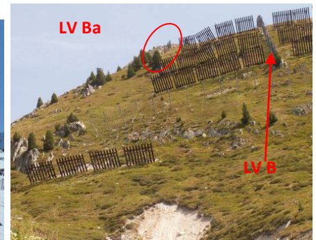
Cliché 80. Macot-La-Plagne _Grand-Lognan : barrière à neige (LVB) intercalée entre des rangées de râteliers et barrières auto-orientables (LV Ba) sur l'épaulement du couloir (ONF-DT RTM).
