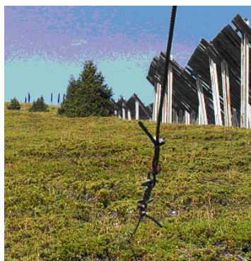
Cliché 83. Macot- La Plagne_ St Jacques : toits buses (lumières d'entrée 1,90mx2m et de sortie 0,20mx2m) du couloir n°12 ; au 1er plan. haubannage d'extrémité de ligne d'une barrière à neige avec tendeurs à vis et ancrage par piquets métalliques (ONF_DT RTM ; août 2012)
