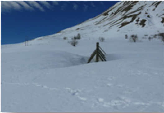
Cliché 49. Barrière à neige bois avec contreventements (F. Naaim/Irstea)
