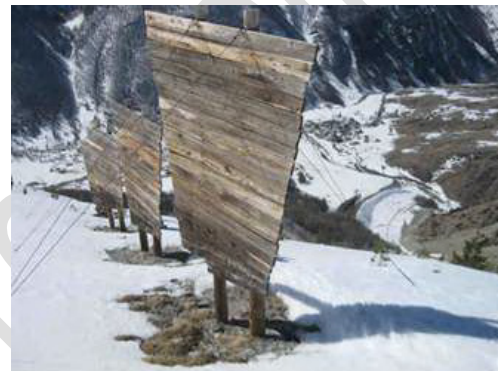
Cliché 99. Larche 04 _ couloir n°19 du Combal : Vire-vent haubannés par câbles, alignés en marge Est du couloir (ONF_RTM 04).
