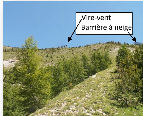
Cliché 109. Marge Est de la zone de départ du couloir du Combal à Larche et zone de dépôt de neige sur banquette en zone sous le vent d'une barrière à neige et d'un brise vent boisé. (ONF_DT RTM).
