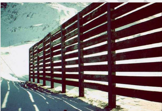
Cliché 51. Barrières à neige mixte, métal pour les supports et bois pour les lattes du tablier et les cales Col du Brenner, Italie (JM Taillandier/Irstea).
