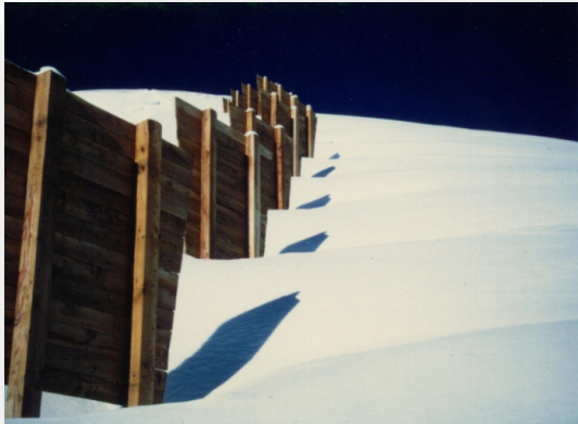
Cliché 61. Panneaux vire-vent à 1 panneau et deux poteaux avec sur la droite les dépôts de neige en forme de cigare (J-M Taillandier/Irstea)
