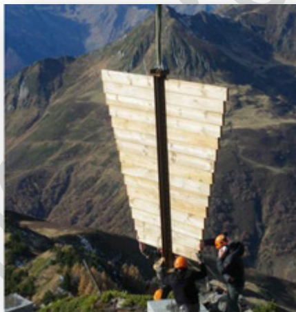
Cliché 63. FD RTM du Capet, pose d'un panneau vire-vent à tablier tenu et porté par un poteau unique (ONF RTM 64-65).
