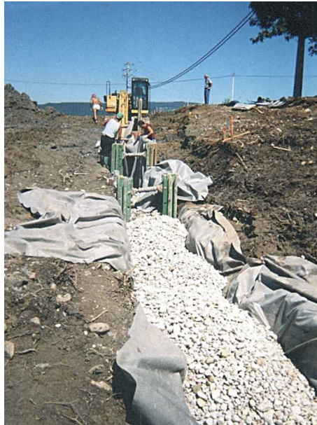
Figure 35. Exécution des tranchées par fouilles blindées à l'avancement
