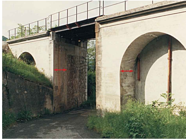
Figure 78. Élargissement en béton (flèches rouges, côté amont) d'un viaduc en maçonnerie (Isère).
