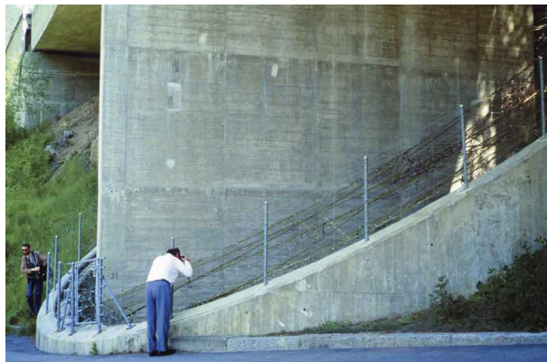
Figure 76. Fondation d'une pile du viaduc sur la Ganter (Suisse), sur puits évidé.
