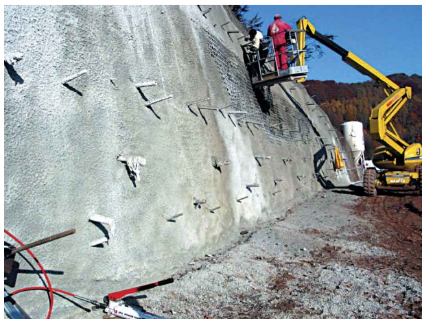
Figure 58. Mur de soutènement cloué dans les grès altérés triasiques en Lorraine. Clous HA 28 disposés sur quatre rangées, inclinés de 10 degrés. Barbacanes.
