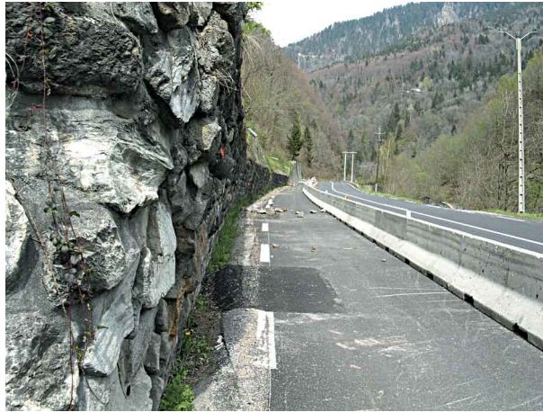
Figure 71. Déversement des murs anciens sur la RN 212
