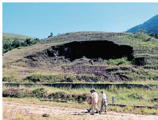
Figure 2. Glissement de talus (Brésil)
