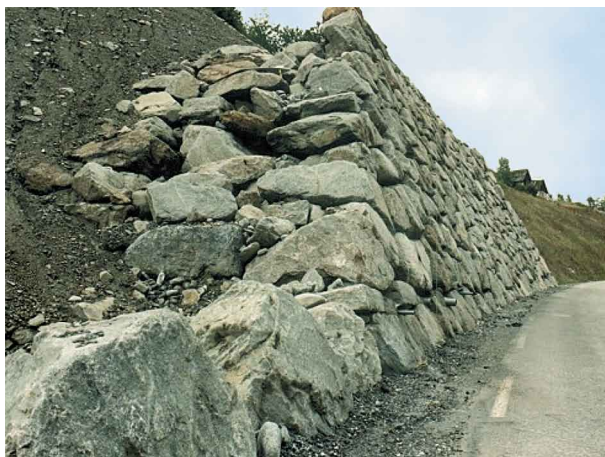
Figure 6. Butée de pied en enrochement (Alpes-Maritimes). On remarque l'agencement des blocs et la présence de barbicanes intégrées à l'ouvrage
