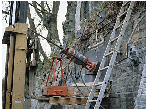
Figure 60. Essai de réception d'un clou à Varengeville-sur-Mer
