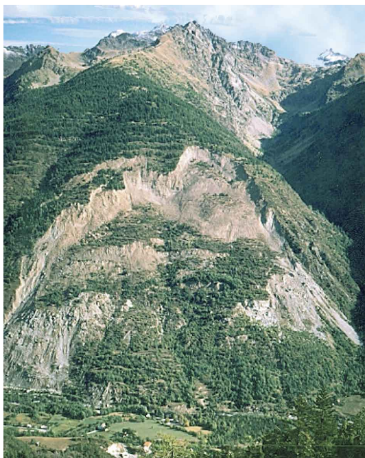
Figure 1. Glissement de La Clapière (Alpes-Maritimes) ; largeur : 800 mètres
