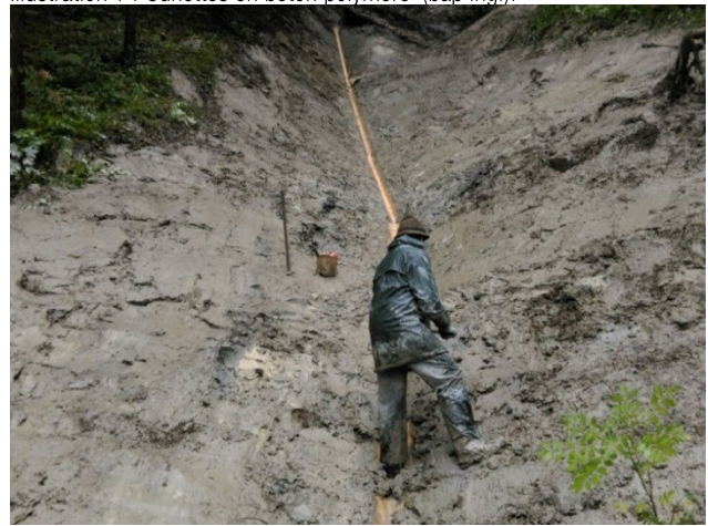
Illustration 16 fossé avec cunette en V 20/4 selon Zeller/Trümpler 1984 (Lieberherr M.)
