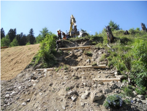
Illustration 32 Armature superficielle au moyen de longrines ancrées (AWN GR).
