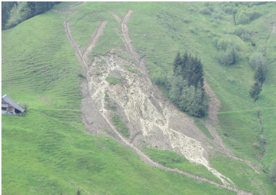
Illustration 11 Résurgences d'eau captées sur le glissement Untere Schafera, Plaffeien, après les premières mesures (image WALDA FR)
