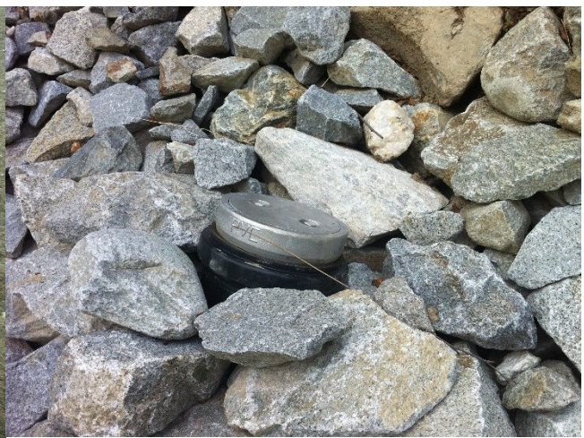
Illustration 40 Dérivation de rinçage correctement obturée et protégée (AWN GR).
