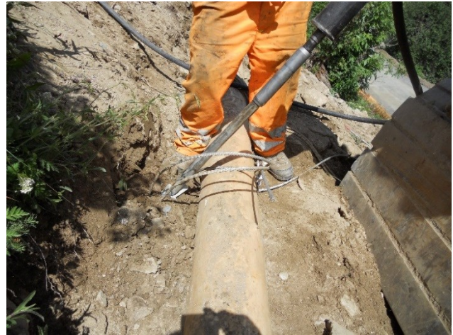
Illustration 33 forçage de l'ancrage au compresseur et mise sous tension jusqu'à la prise de l'ancrage (AWN GR).
