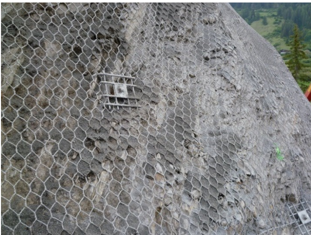
Illustration 42 Réseau d'ancrage (clous) et treillis métallique avant l'ensemencement (fobatec).
