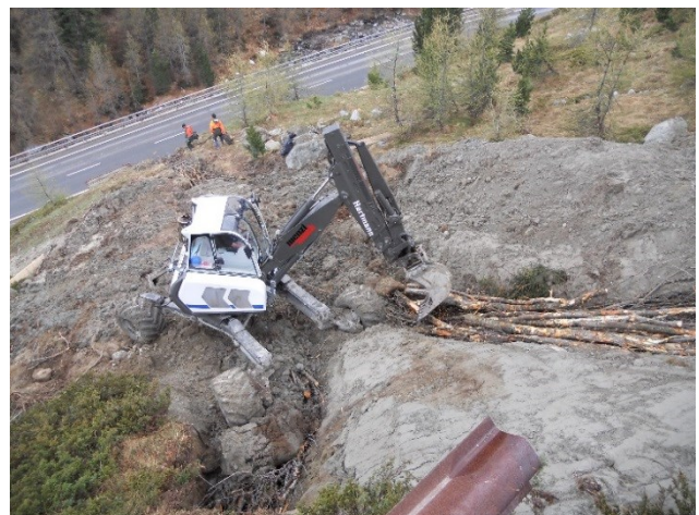
Illustration 21 Fascines avant la remise en place du sol (Caprez Ing.).
