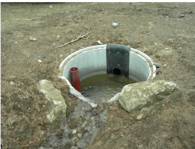
Illustration 27 Lors de l'envoi d'eau de surface dans un tuyau, un petit dépotoir d'entretien facile est à aménager (bap Ing.)
