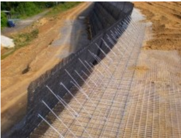
Illustration 50 La terre armée est un concept qui utilise le poids des terres pour les retenir. (nacken-steisslingen.de)
