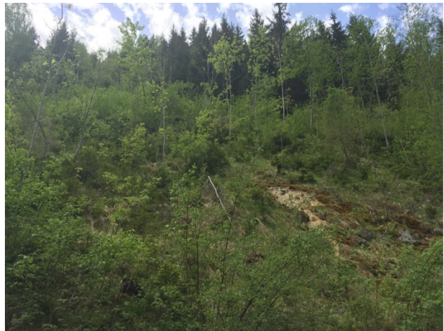
Illustration 55 Exemple d'une pente traitée par génie biologique après 35 ans (Patenjarüfe, Arieschbach, 2015). On distingue très bien la dégradation des ouvrages en bois à gauche et le développement d'une jeune forêt à droite.
