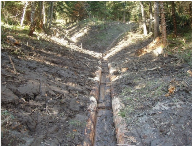
Illustration 15 cunettes rectangulaires 40/25 en bois ronds selon Zeller/Trümpler 1984 (Lieberherr M.)
