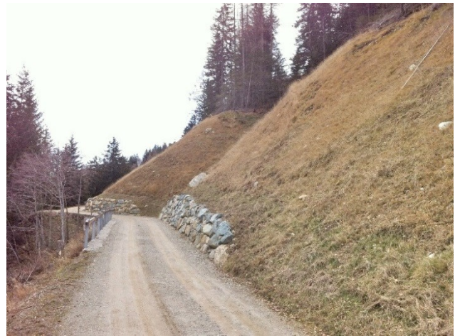
Illustration 44 Grâce à l'évacuation des matériaux, le talus s'est aplani et sa stabilité améliorée. Sans évacuation, le mur de soutènement devrait être bien plus haut. (AWN GR).
