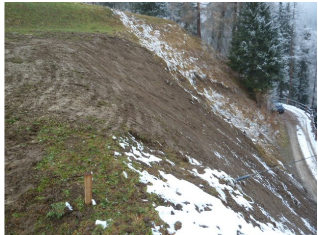
Illustration 41 L'armature de sol en bois terminée et complètement recouverte (allonge la durée de vie de l'ouvrage) (AWN GR).
