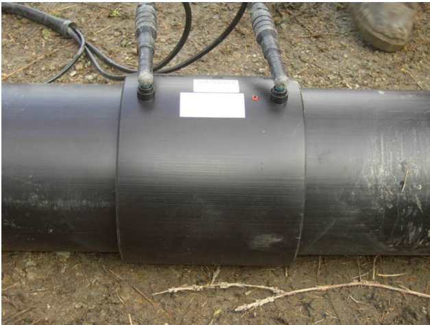
Illustration 29 Tuyau PE avec manchon de thermosoudage (bap Ing.).
