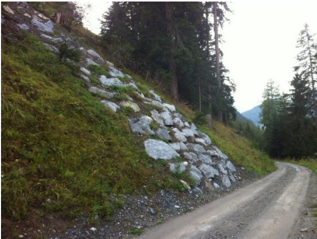
Illustration 38 empierrement d'un talus de route. Les blocs sont posés en contact entre eux. (AWN GR)
