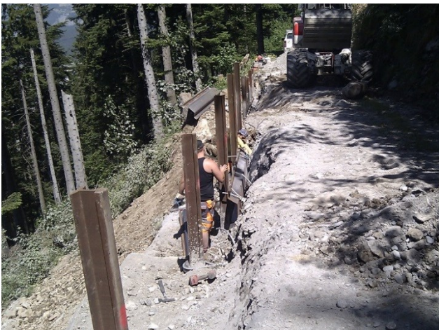
Illustration 34 Mise en place de rails CFF et ancrages spiraux pour une palissade (Ribbert AG).
