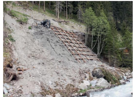
La construction est réalisée sur la base de matériel vivant (pour les petites dimensions [49]) ou en rondins d'un diamètre d'environ 10–30 cm (voir figure 20). Il est possible d'insérer des troncs co-
