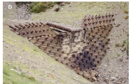
Les barrages à caissons en bois à triples parois, comme le montre la figure 39 D, sont des ouvrages extrêmes destinés à des utilisations particulières. Dans ce cas, une construction en bois a été choisie, car les pentes glissaient encore dans la zone de l'ouvrage au moment de la construction. Ce n'est qu'après la stabilisation des pentes, dans un délai d'environ 20 à 30 ans (ce qui correspond à peu près à la durée d'utilisation du barrage en bois), qu'un
