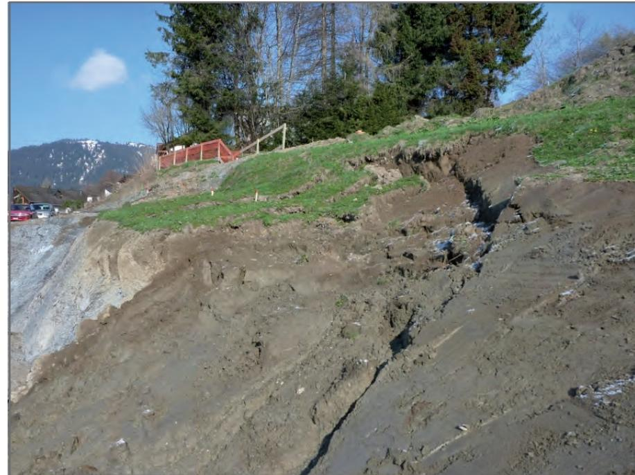
Böschungsbruch in Baugrube (2010)
