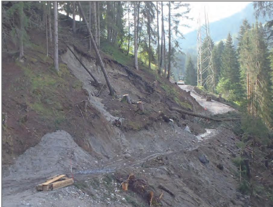
Böschungsbruch bei Meliorationswegbau (2014)
