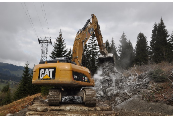
Abbildung 37 Kalkbehandlung des Strassenkörpers (Böschungen und Trasse) mit einem auf einer Baggermatratze stehenden Baggers (AWN SZ).
