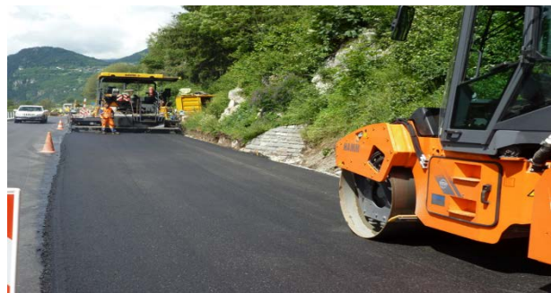
Abbildung 32 Einbau einer Fundationssschicht aus AC F 22, das bis maximal zu 85% Ausbausphalt enthalten kann (Catram).
