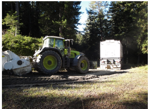
Abbildung 36 Einarbeiten des Zementes (AWN GR).
