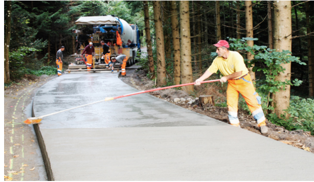
Abbildung 34 Einbau mit Gleitschalungsfertiger und abschliessender Besenstrich zur Strukturierung der Oberfläche (Amrein Gebr. AG).
