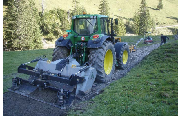
Abbildung 40 Ein Brecher konnte das vorgelegte Schottermaterial und den Waschschlamm mischen und planieren (AU FL).
