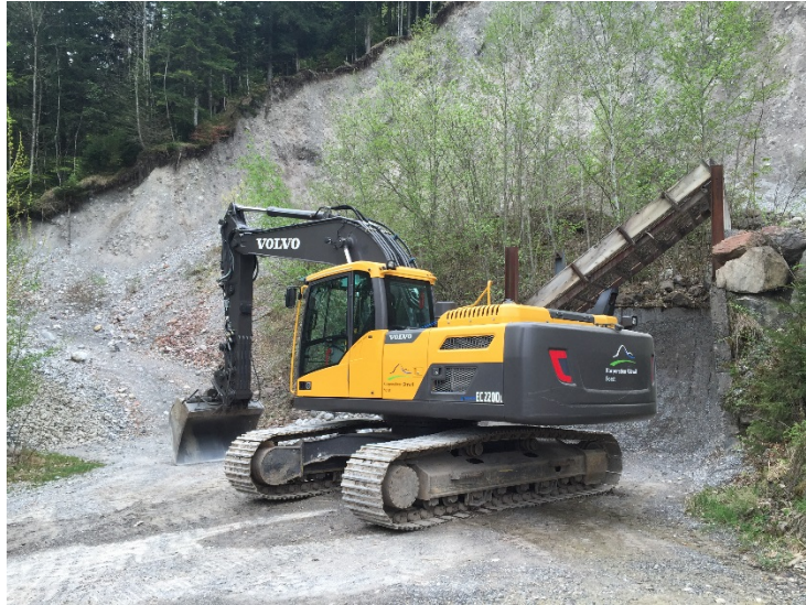
Abbildung 23 Einfache, mit dem Bagger beschickbare Siebeinrichtung zum Sieben vor Ort.
