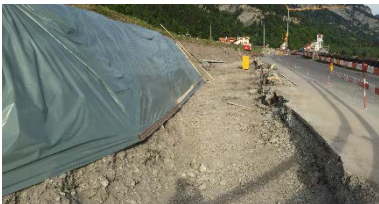
Abbildung 56 Entfernter Strassenaufbruch
