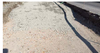
Abbildung 64 RC-Mischgranulatgemisch im unteren Teil der Fundamentalschicht.
