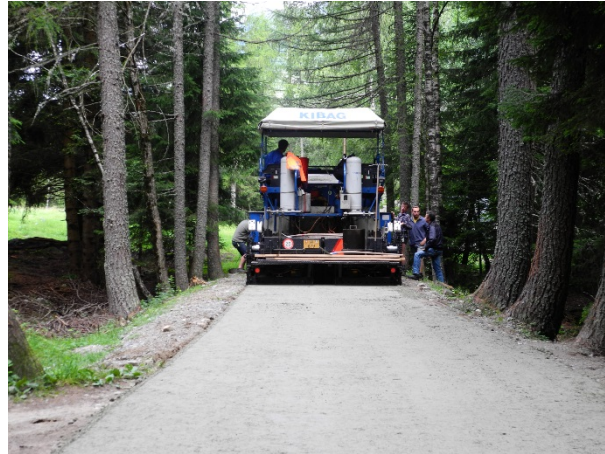
Abbildung 41 Fertigereinbau (AWN GR)
