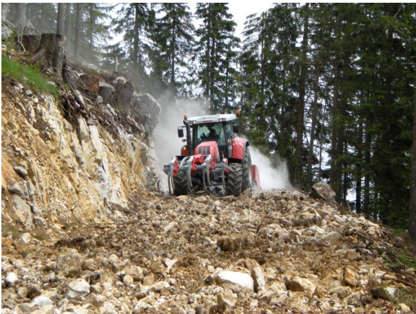
Abbildung 28 Vorgelegtes Kalkgestein wird traktormobil gebrochen. Am Frontkraftheber ist der Ripper angehängt (PTH gmbH).
