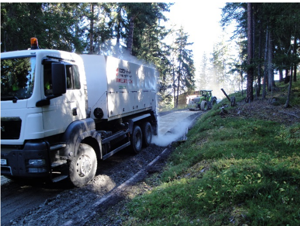
Abbildung 35 Aufbringen des Bindemittels Zement (AWN GR).
