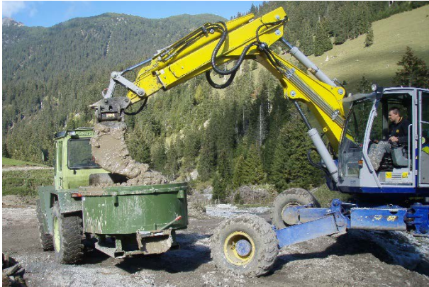
Abbildung 39 Zur Herstellung einer Verschleisssschicht sind bindende Eigenschaften gefragt. Fehlendes Feinmaterial wurde durch Waschschlamm aus einem Kieswerk ersetzt (AU FL).
