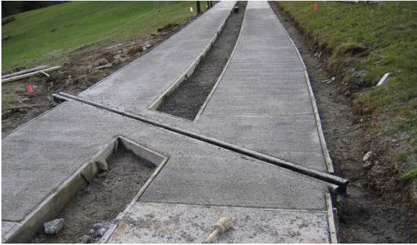
Abbildung 33 Betonspurweg (bap Ing.)
