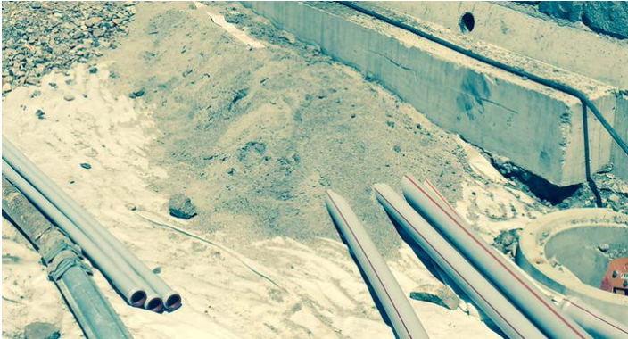
Abbildung 18 Bettung von Kabelschutzrohren in Sand 0/4
