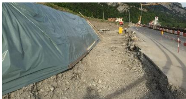
Illustration 54 matériaux non bitumineux de route (fondation)
