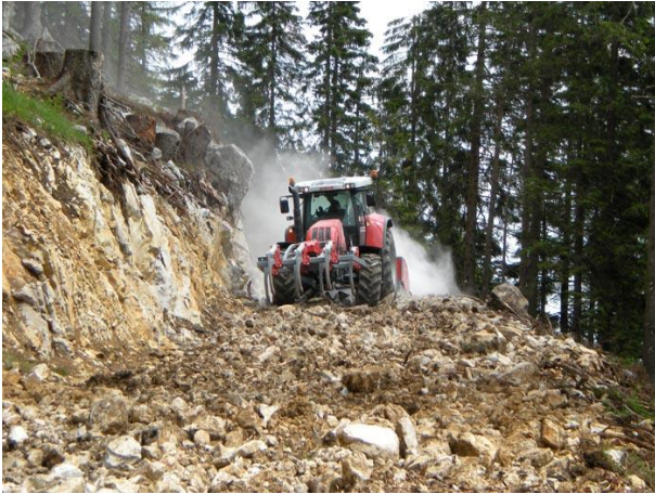
Illustration 26 Les matériaux calcaires provenant de l'élargissement sont broyés par la concasseuse tractée. Un ripper est installé à l'avant du tracteur (PTH gmbH).
