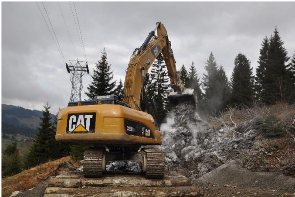
Illustration 35 Traitement à la chaux de l'infrastructure d'un chemin (soubassement et talus) à partir d'une pelle rétro sur caillebotis (AWN SZ).
