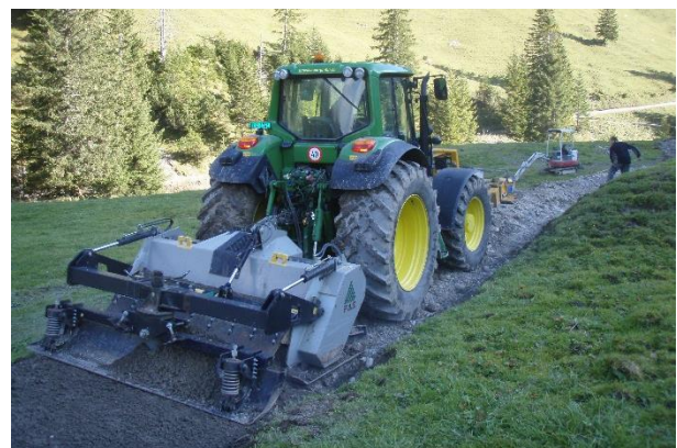
Illustration 38 La concasseuse permet de mélanger les graviers déposés avec la boue de lavage et réaliser une planie. (AU FL).
