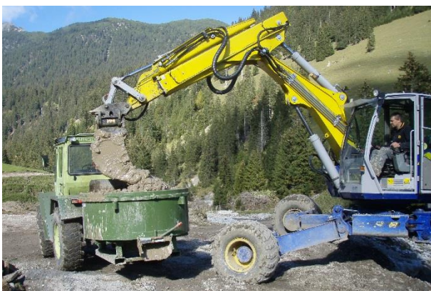
Illustration 37 Une couche d'usure nécessite des propriétés liantes. De la boue de lavage de gravière est ajoutée aux matériaux. (AU FL).
