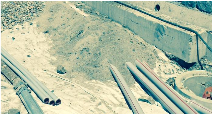
Illustration 17 Enrobage de gaines électriques dans un sable 0/4
