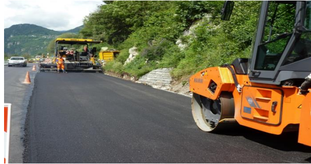
Illustration 30 Pose d'une couche de fondation d'AC F 22, qui peut contenir jusqu'à 85% de recyclé (Catram).
