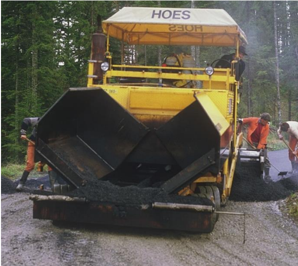
Illustration 29 Pose d'un enrobé bitumineux AC T 16N sur une fondation 0/45, respectivement sur un réglage (AWN SZ).
