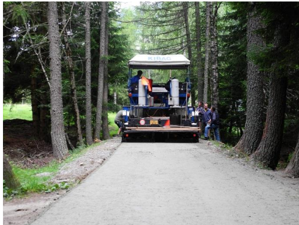
Illustration 39 Pose à la finisseuse (AWN GR)
