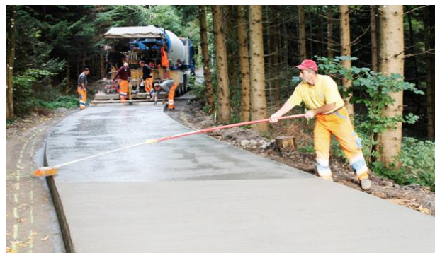
Illustration 32 Pose de la dalle béton à la finisseuse à coffrage glissant et passe à la brosse pour structurer la surface (Amrein Gebr. AG).
