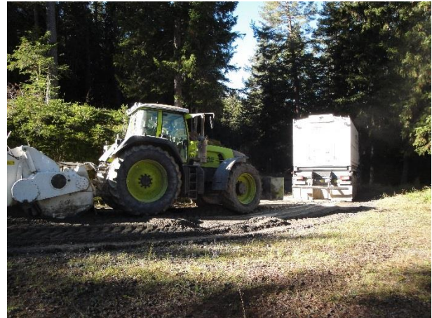
Illustration 34 Incorporation du ciment dans la masse (AWN GR).
