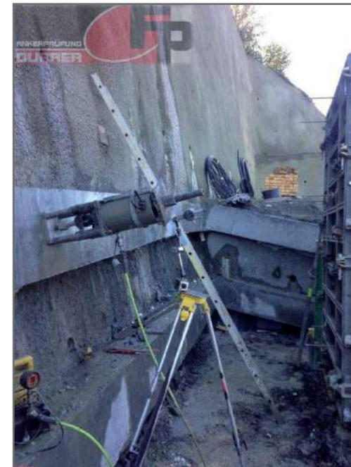
essai d'ancrage (source: www.fp-ankerpruefungen.ch )
