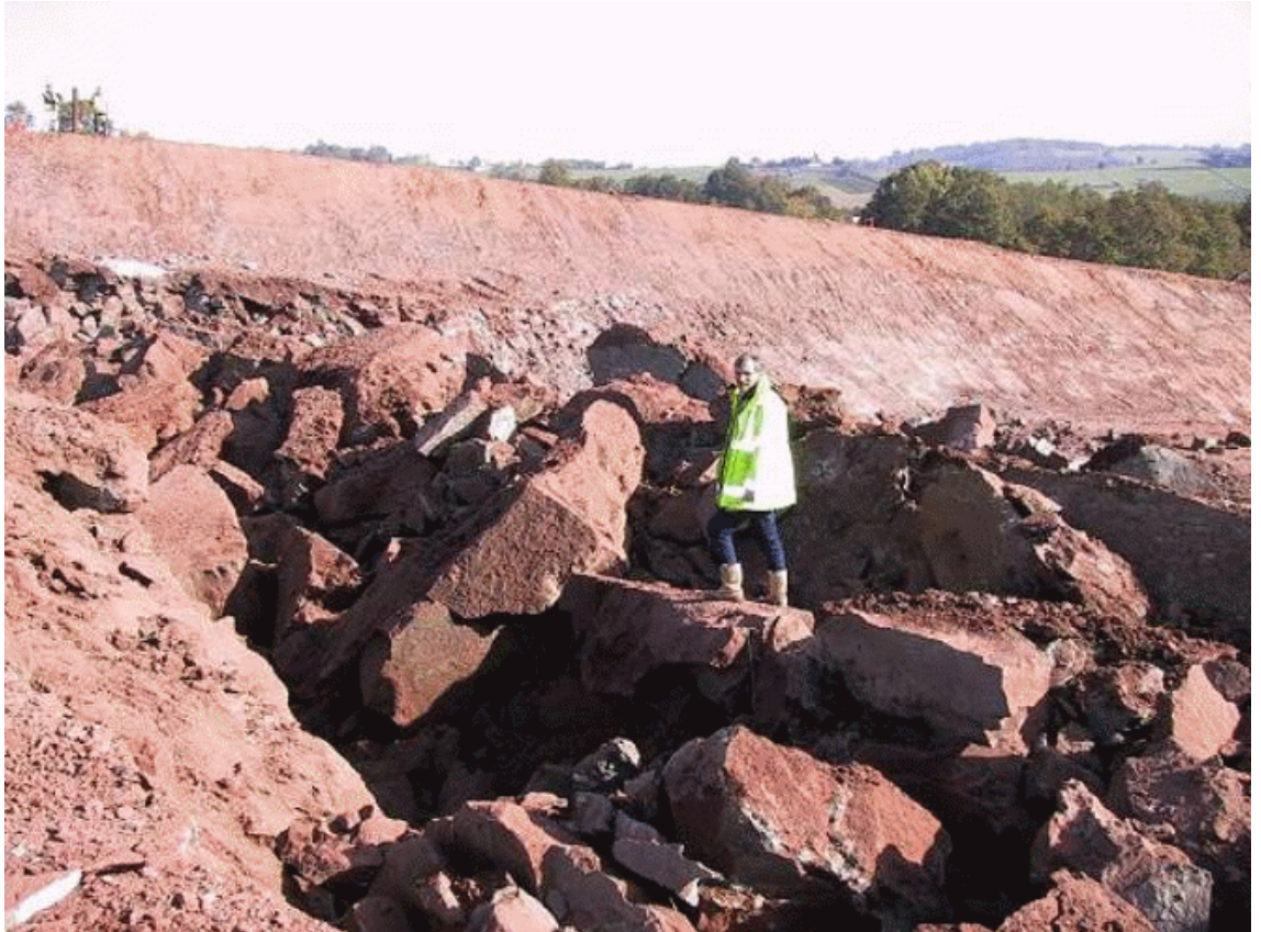
Taille des blocs après extraction à l'explosif (source : V. Ferber)
