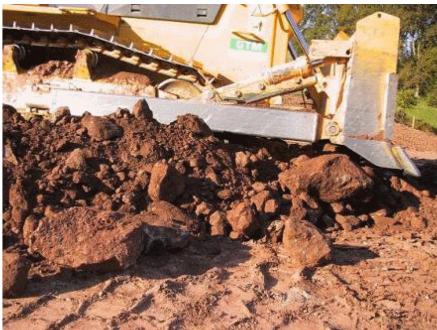
Fragmentation complémentaire après extraction au bulldozer (source : V. Ferber)
