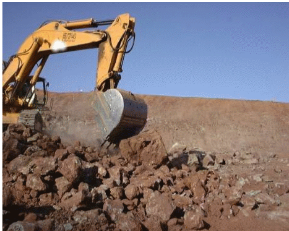
Fragmentation complémentaire après extraction à la pelle mécanique (source : V. Ferber)
