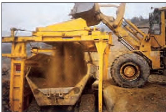
Chargement du crible.
