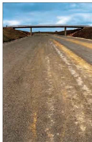
Etat de la protection après avoir supporté le trafic de chantier.
