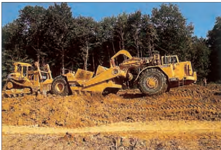
Extraction des sols de classes A 2m et A 3m par conditions météorologiques "évaporantes" : des conditions de chantier idéales! ...
