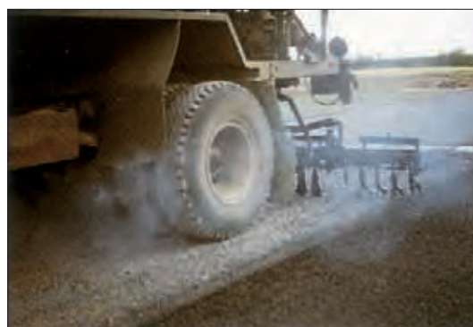
Répandage de l'émulsion.
