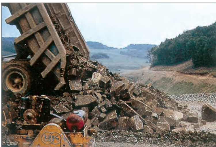
Roche magmatique dure (basalte) de classe R_{61}
