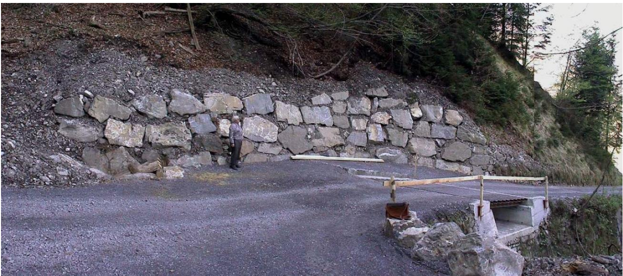
Abbildung 4: Entlastungsrost nach der Fertigstellung 2002 (Bild: belop GmbH).
