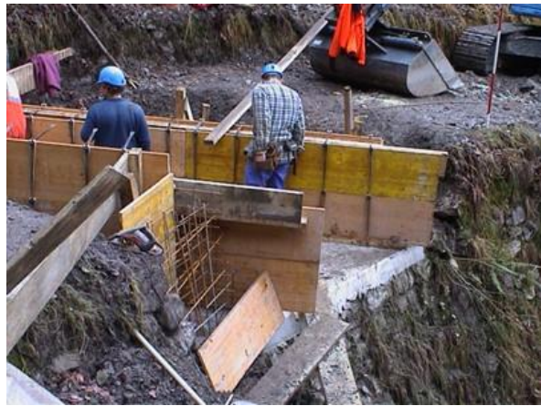
Illustration 7 : Côté aval, le passage en caisson est intégré dans le mur de moellons existant.
