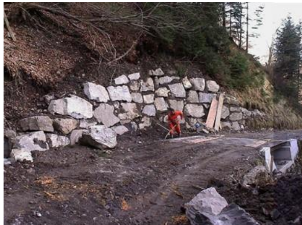
Illustration 9 : Passage à bétail complété et sécurisé par un mur de soutènement en parpaings
