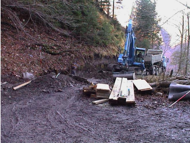
Abbildung 6: Beginn der Aushubarbeiten
