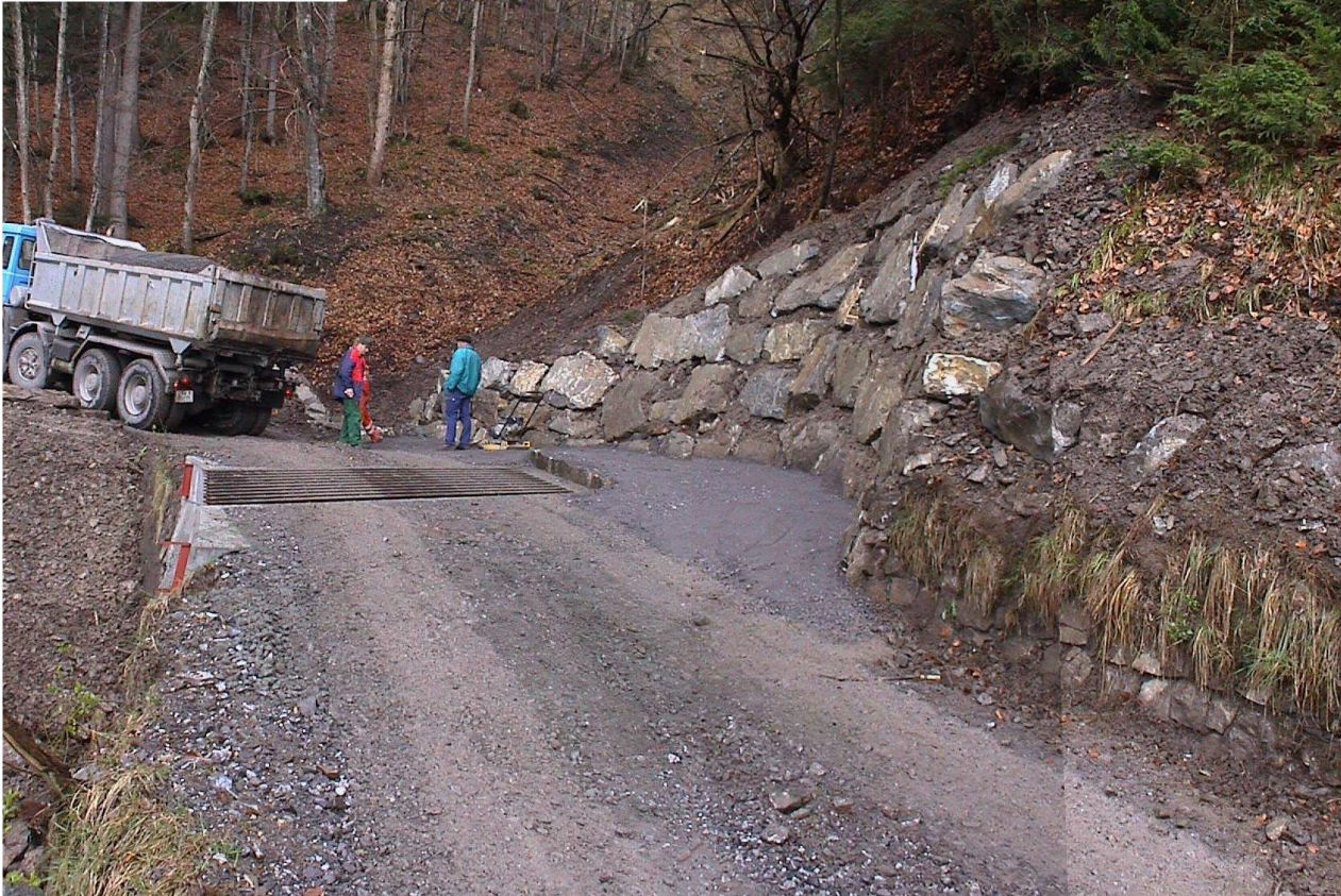
Illustration 5 : Grille de décharge après l'achèvement des travaux en 2002. Un passage permettant le transit du bétail a été aménagé à droite de manière surélevée. (Photo Belop GmbH)
