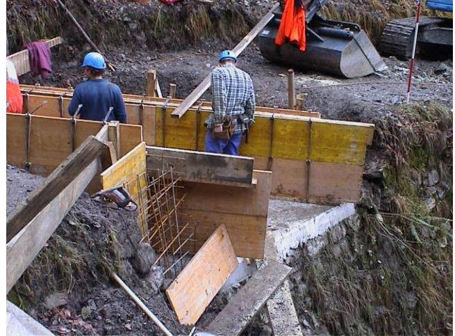
Abbildung 7: Talseitig wird der Kastendurchlass in die bestehende Bruchsteinmauer integriert.
