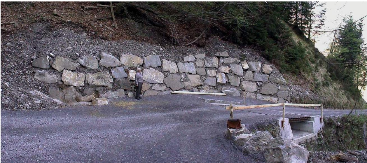
Illustration 4 : Grille de délestage après l'achèvement des travaux en 2002 (photo : Belop GmbH).
