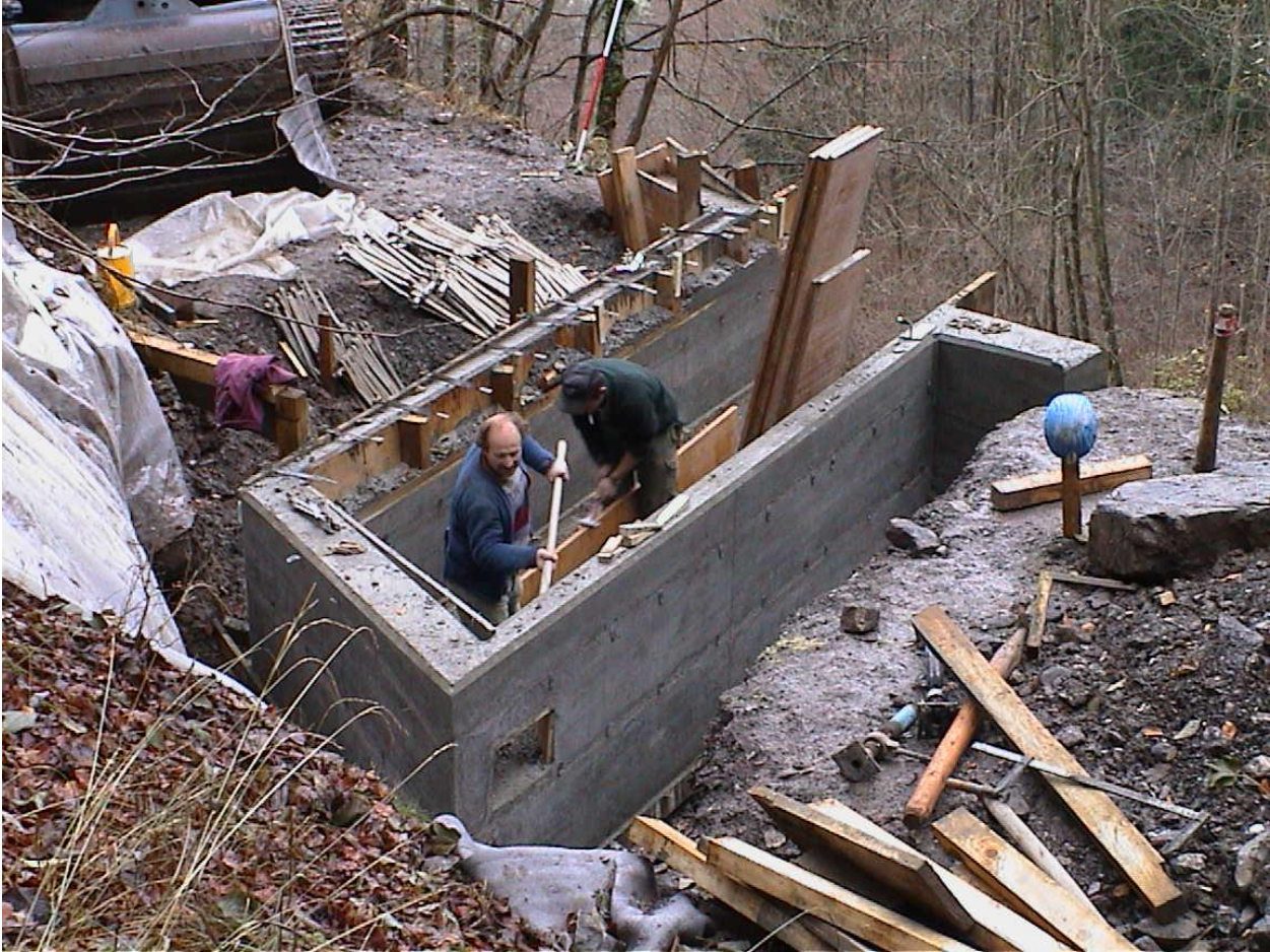
Illustration 3 : Le caisson en béton lors du décoffrage (photo : Belop GmbH).
