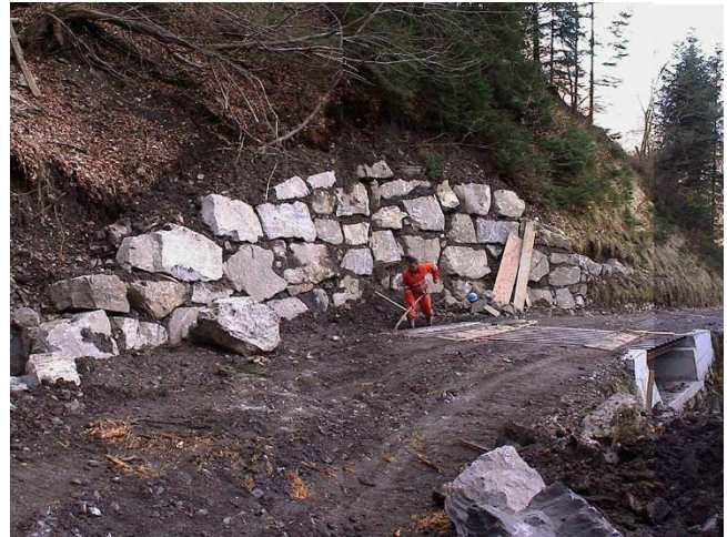
Abbildung 9: Ergänzte Viehpassage mit einer Stützmauer aus Blocksteinen gesichert.
