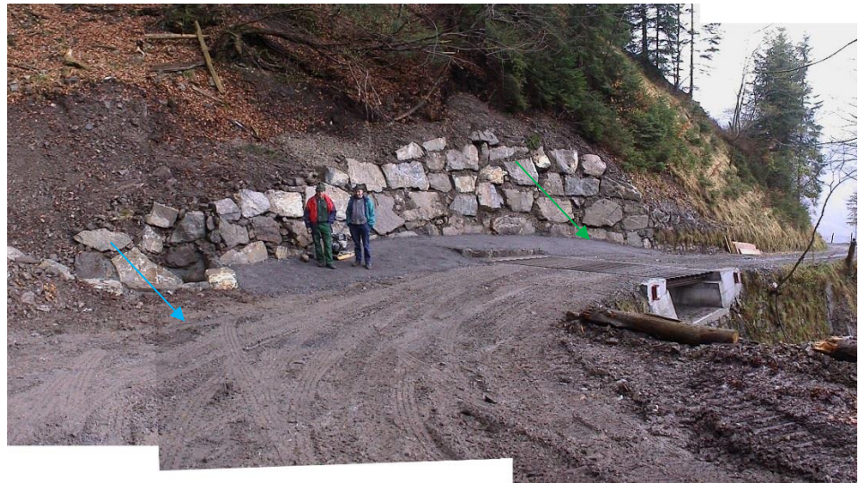
Durchlasseinlauf und Geschieberost für Überlast
