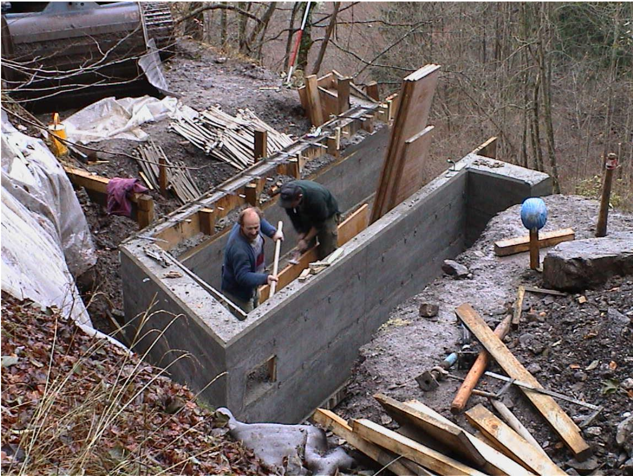
Abbildung 3: Der Betonkasten beim Ausschalen (Bild: belop GmbH).
