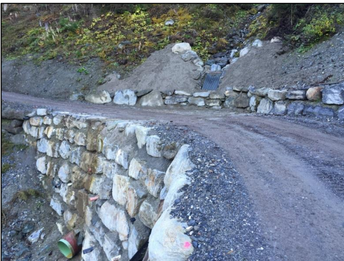
Photo 5 : Vue générale de l'ouvrage terminé depuis le nord
