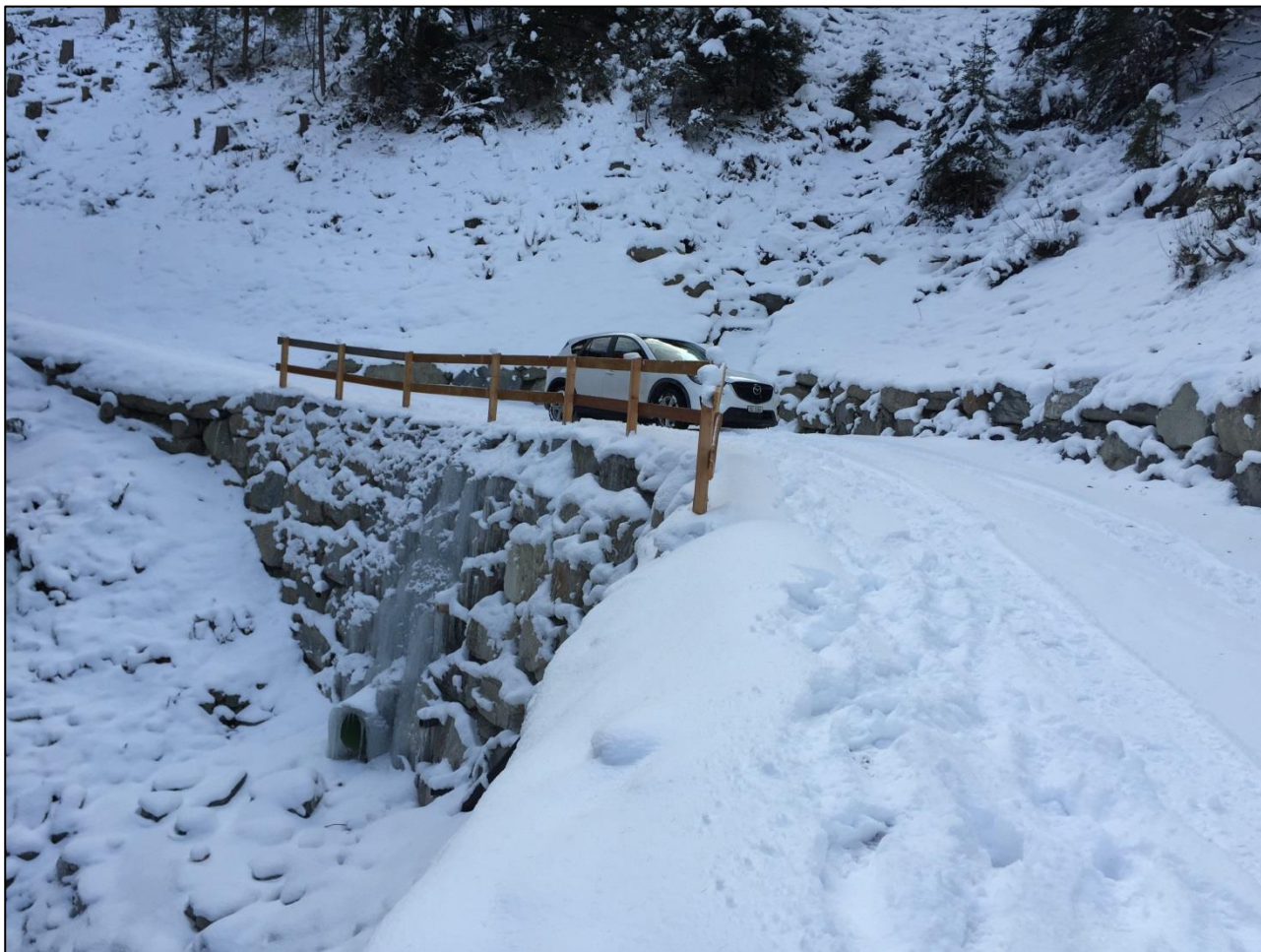
Photo 6 : Vue générale de l'ouvrage terminé; l'eau drainée de l'enrochement latéral en rive gauche coule sur le gué et forme une cascade.
