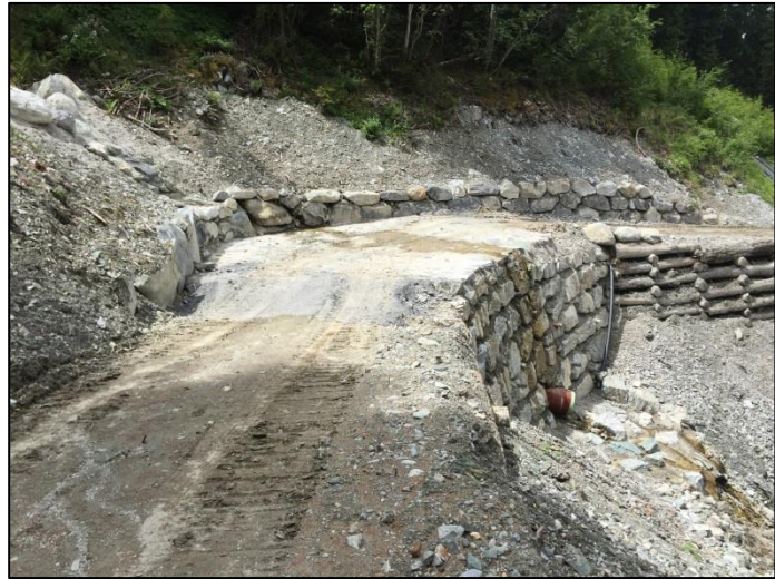
Photo 1 : Vue générale de l'ouvrage depuis le sud-est
