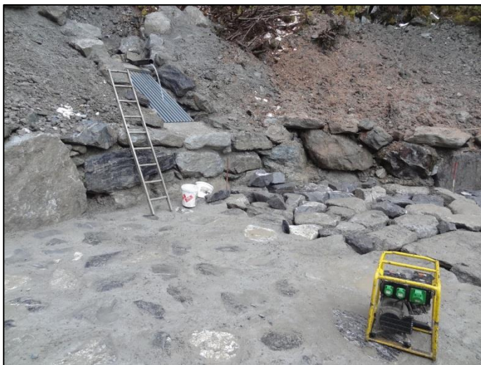
Photo 2 : pavage en cours de pose
