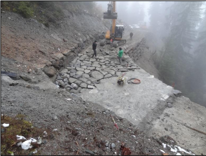
Photo 3 : Construction de l'ouvrage
