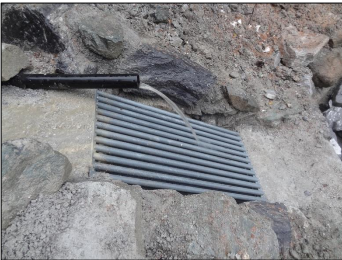
Photo 4 : Détail de la grille, inclinaison env. 45°
