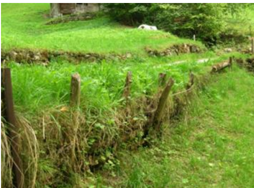
Ouvrage avant assainissement
