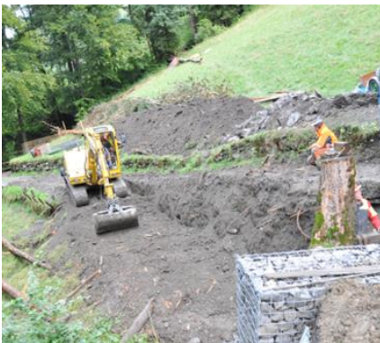
Creuse de la fondation
