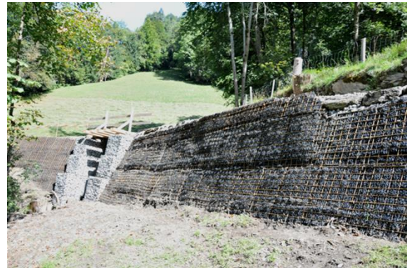
Après les travaux
