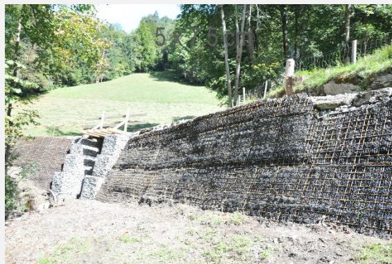
Fig. 1 Talus aval stabilisé avec de terre armée (H. Bader)
