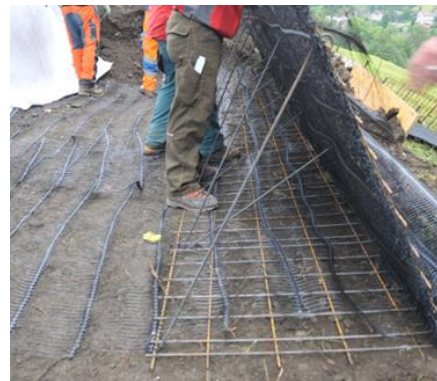
Mise en place de la structure métallique + géogrille
