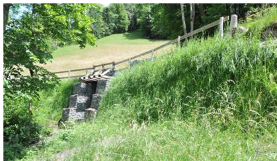
Ouvrage 1 année après sa réalisation
