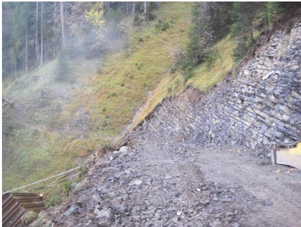
Abb. 4: Rohplanie der neuen Waldstrasse durch die Runse. Links die Stahlpalisaden zum Auffangen des Aushubmaterials (Bild: Von Moos).
