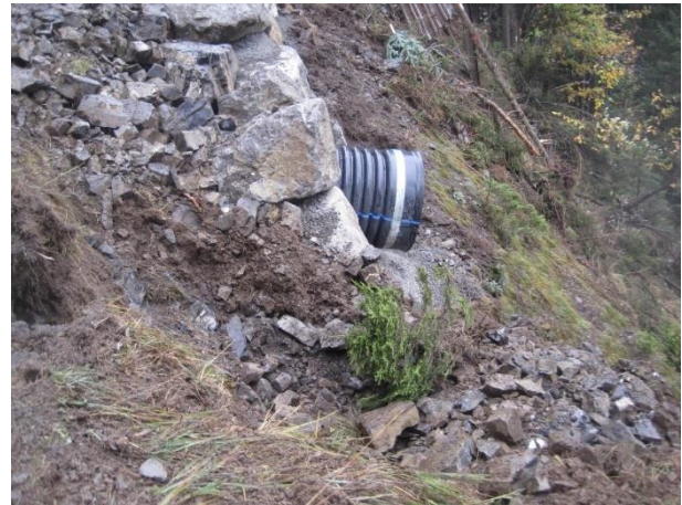
Abb. 5: Auskrägung eines Durchlasses (PP-Rohr) zur Vermeidung einer Unterkolkung (Bild: Von Moos).
