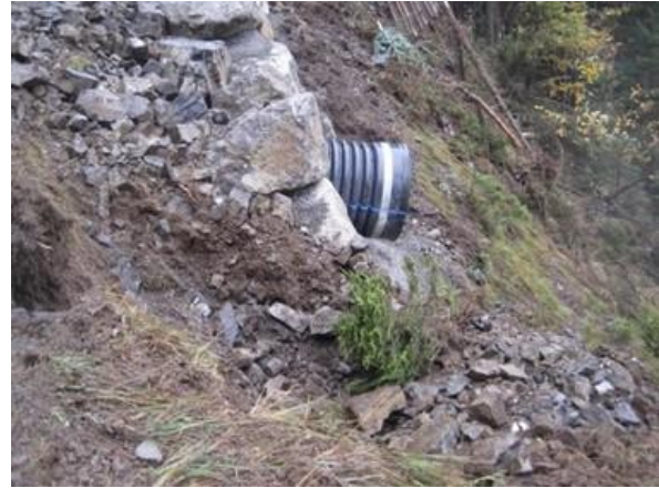
Illustration 9 : Prolongement du passage busé ( tuyau en PP) pour éviter un affouillement
