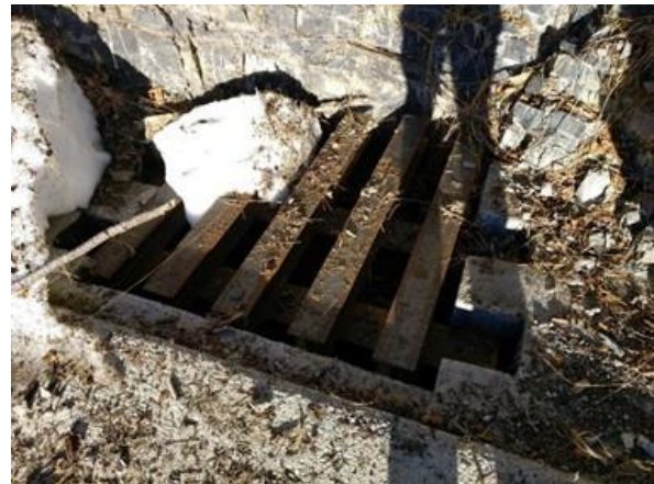
Illustration 11 : Grille en acier composée de profilés en H
