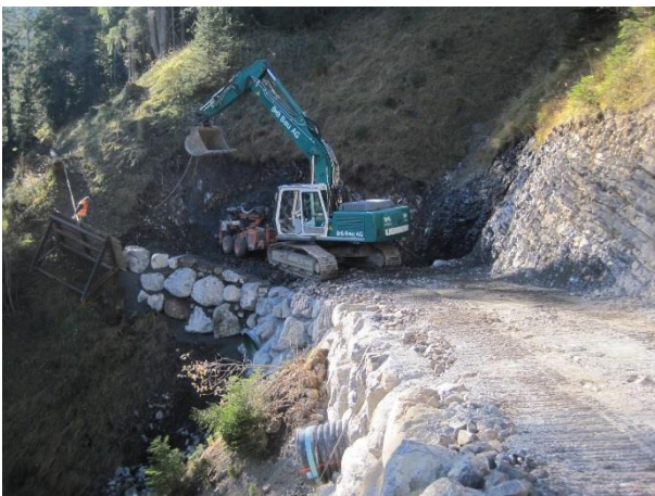
Abb. 6: Starke bergseitige Einschnitte (Bild: Von Moos).
