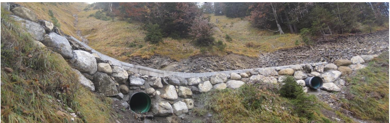
Abb. 8: Ausgeführte Furt von unten. Links die Furt «gross» und rechts die Furt im Ausbaustandard «klein» (Bild: Von Moos).
