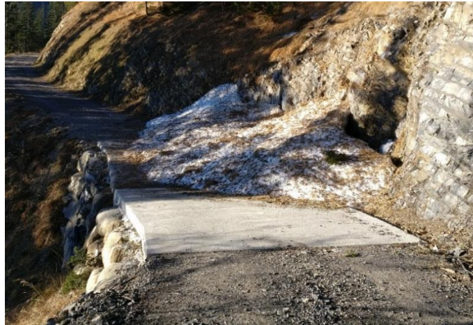
Abb. 1: Furt mit eingerutschtem Schnee (Bild: A. Von Moos)
