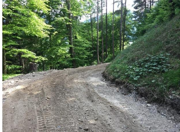
Abb. 2: Vorbereiten: Brechen des Ausgangsmaterials (Foto: Fobatec).
