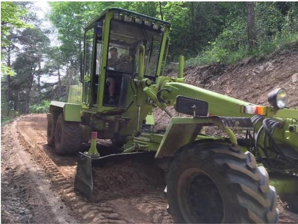
Abb. 8: Anlage und Planieren des künftigen Strassenprofils mit dem Grader (Planiermaschine; Foto: Fobatec).
