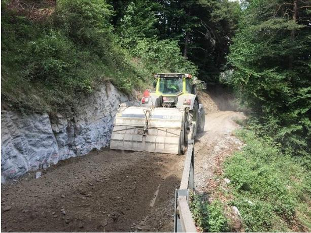
Abb. 6: Mischen mit der Fräse (Foto: W Krättli).
