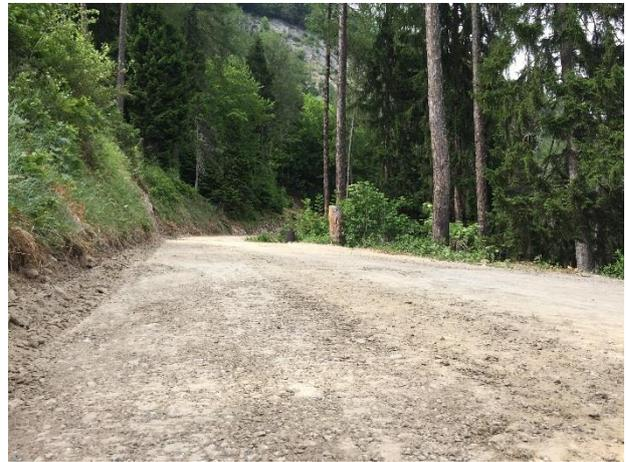
Abb. 9: Fertig verdichteter und somit stabilisierter Strassenkörper nach der Profilierung (Foto: Fobatec).
