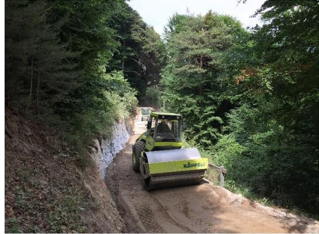
Abb. 7: Vorverdichten mit Walzenzug zur Vermeidung von vorverdichteten Spuranlagen durch die Maschinen (Foto: Fobatec)
