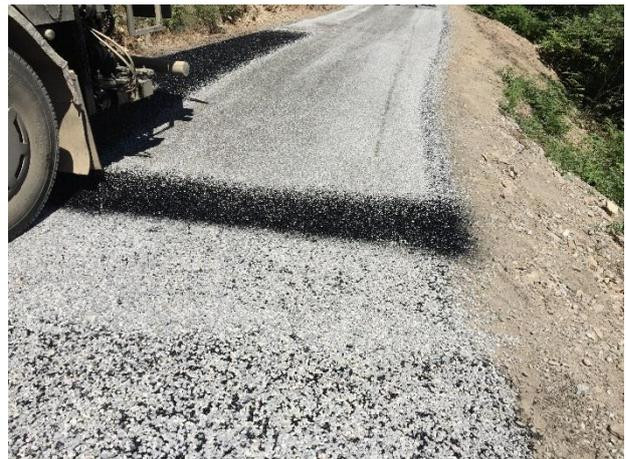
Abb. 10: Unten der zweite Bitumenauftrag mit aufliegender Splittabstreuung. Der gut sichtbare Bitumenstreifen ist der Dritte Bitumenauftrag. Darüber befindet sich die dritte Abstreuung mit der feinsten Kornabstufung (Foto: Fobatec).
