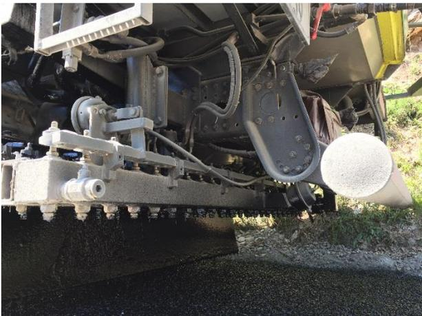
Abb. 9: Gleichmässiges Auftragen des Bitumens mit einem Sprühbalken (Foto: Fobatec).
