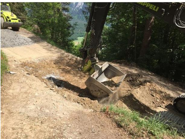
Abb. 5 (links): Bei Strassenabschnitten, die von Leitungen durchquert werden, oder die mit Stützmauern gesichert sind und entsprechend schmal sind, hat man zum Schutz der bestehenden Infrastruktur auf das Brechen verzichtet und stattdessen eine neue Kofferung / Tragschicht eingebaut und sachgemäss verdichtet (Foto: Fobatec).
