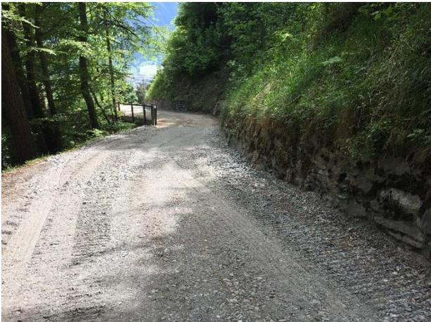
Abb. 3: Vorbereiten: Abschnitt entlang von Kunstbauten werden normal gekoffert und nicht stabilisiert (Foto: Fobatec).
