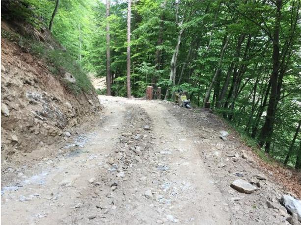
Abb. 1: Vorbereiten: Aufreißen des Strassenkörpers (Foto: Fobatec).
