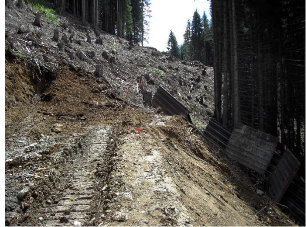
Abbildung 8: Rohbau bei Kilometer 0.68 mit fortlaufender Absteckung des Wegverlaufs (Foto: H. Richener)
