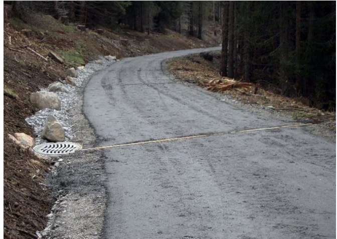
Waldweg mit ton-wassergebundener Verschleisssschicht und Querabschlägen aus zusammengeschweissten Bahnschienen (Quelle: H. Richener)
