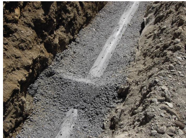
Abbildung 4: Bergseitige Sickerleitungen in vernässten Bereichen (Foto: H. Richener)
