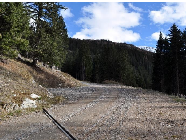
Abbildung 11: Waldweg mit Querabschlag und Lagerplätzen im Herbst 2018 bei Kilometer 0.96 (Foto: J. Hehli)
