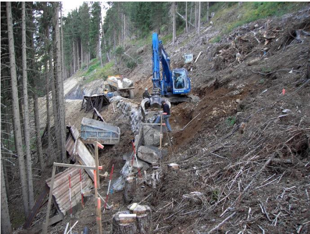
Abbildung 9: Bau der talseitigen Blocksteinmauer bei Kilometer 0.7 (Foto: H. Richener)
