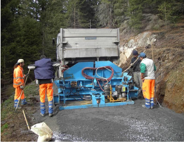
Abbildung 13: Einbau Verschleisssschicht beim Verbindungsweg im Herbst 2009 (Foto: H. Richener)
