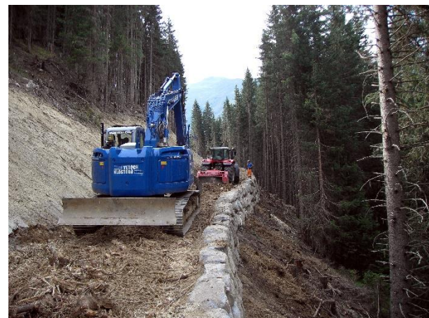
Abbildung 6: Zerkleinern von Wurzelstöcken bei Kilometer 0.47 (Foto: H. Richener)
