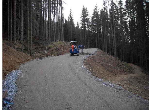
Abbildung 2: Einbau eines Querabschlages bei Kilometer 0.06 (Foto: H. Richener)
