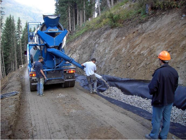
Abbildung 7: Befüllung der Längsdrainage mit Filterkies bei Kilometer 0.66 (Foto: H. Richener)
