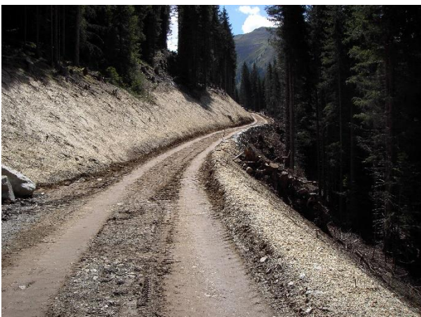
Abbildung 5: Rohbau bei Kilometer 0.41 (Foto: H. Richener)
