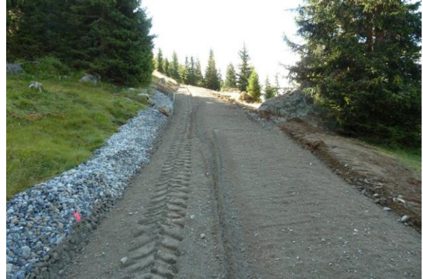
Abbildung 14: Verschleisssschicht vor Planie mit Grader und dem Verdichten beim Waldweg im Herbst 2011 (Foto: H. Richener)
