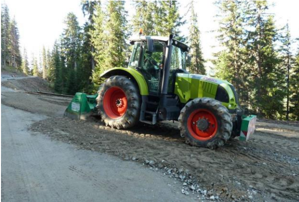
Abbildung 15: Brechen von vorgelegtem Bachmaterial für die Verschleisssschicht beim Waldweg im Herbst 2011 (Foto: H. Richener)
