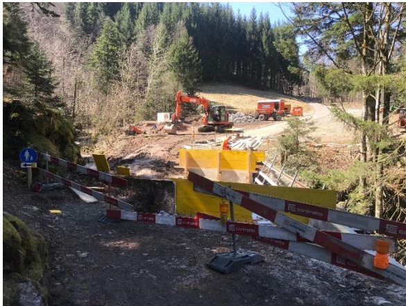
Abbildung 10: Umleitung für Fussgänger während den Bauarbeiten
