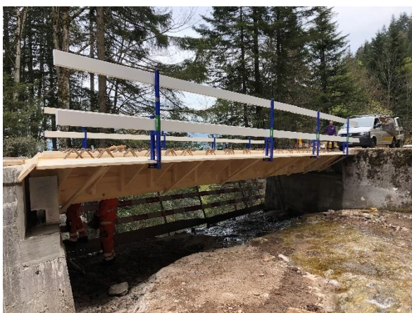
Abbildung 12: Die an den äusseren BSH-Trägern montierte provisorische Schalung der Auskragungen
