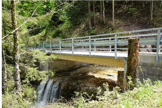
Die fertige UHFB-Holz-Brücke
