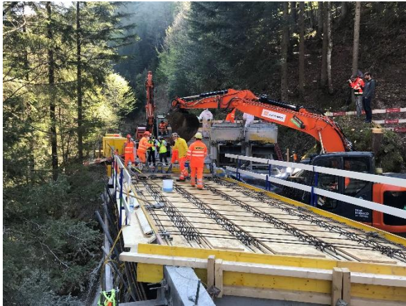
Abbildung 14: Einbau des UHFB
