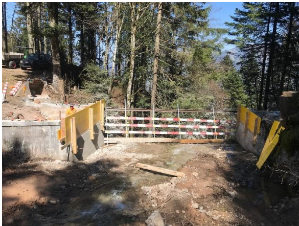
Illustration 8 : Travaux de coffrage en vue du bétonnage des culées
