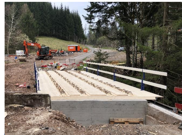
Illustration 13 : Porteur BLC et coffrage en panneau de bois massif
