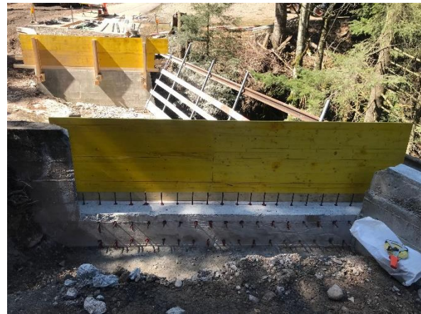
Illustration 9 : Coffrage des culées
