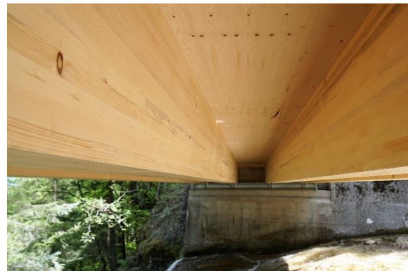
Illustration 19 : Le pont terminé vue de dessous
