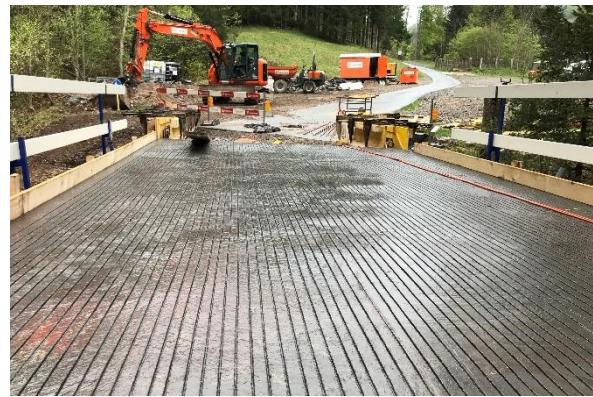
Illustration 17 : BFUP terminé avec fentes fraisées pour assurer l'adhérence
