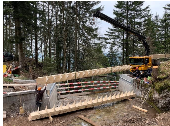
Abbildung 11: Versetzen der BSH-Träger mit vorbereiteter Tragkonstruktion für die äussere Schalung
