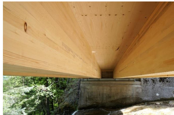
Abbildung 19: Die fertige Brückenuntersicht
