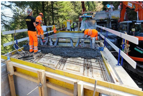
Abbildung 16: Einbau des UHFB
