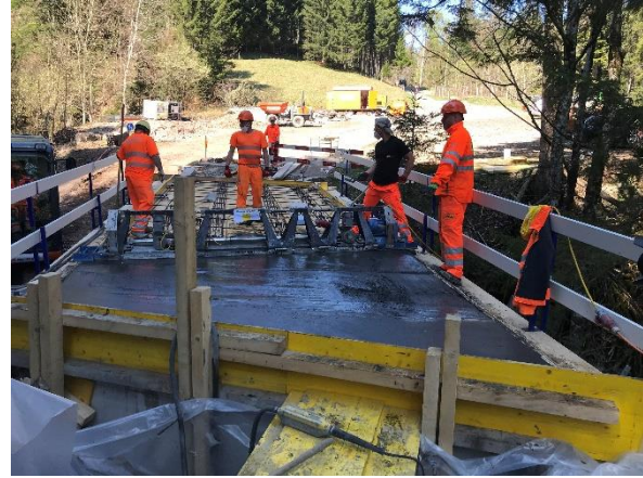
Illustration 15 : Mise en place du BFUP et vibrage
