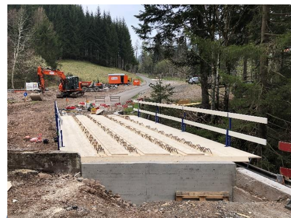
Abbildung 13: BSH-Träger, äussere Schalung und 3-Schicht-Platten fertig versetzt
