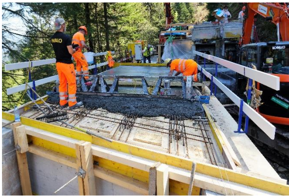
Illustration 16 : Mise en place du BFUP
