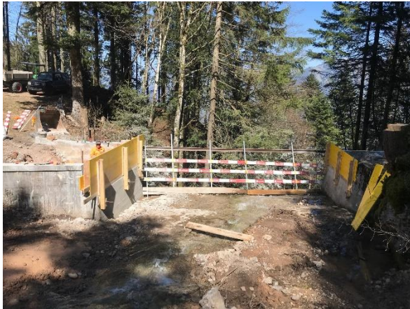
Abbildung 8: Schalungsarbeiten zur Betonierung der Widerlager
