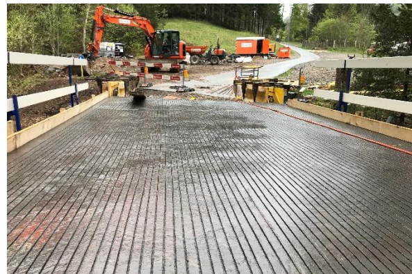
Abbildung 17: Die fertige UHFB-Fahrbahn mit den gefrästen Rillen zur Erhöhung der Rutschfestigkeit
