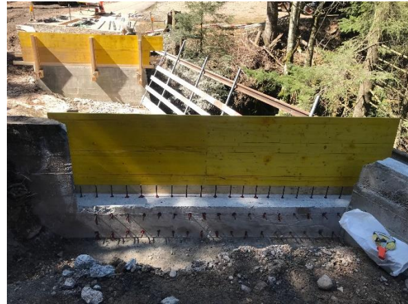
Abbildung 9: Schalung der Widerlager
