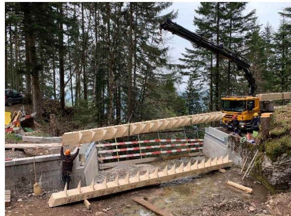
Illustration 11 : Mise en place de BLC avec éléments pour coffrage extérieur
