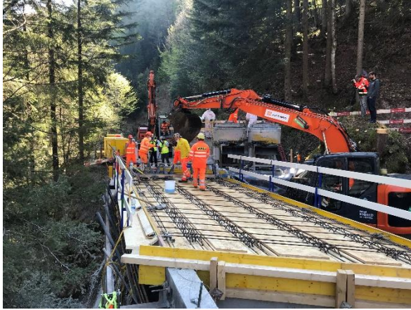
Illustration 14 : Mise en place du BFUP
