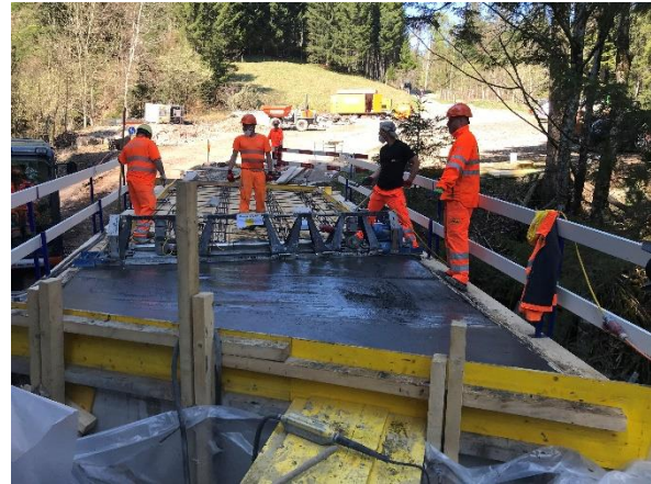
Abbildung 15: Einbau des UHFB, Glätten der Oberfläche mittels Vibrobalken
