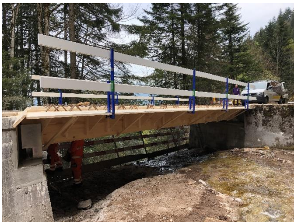
Illustration 12 : Les poutres BLC extérieures sont équipés d'un coffrage temporaire
