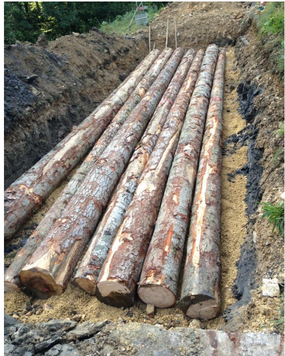
Figure 6 : Mise en place des grumes
