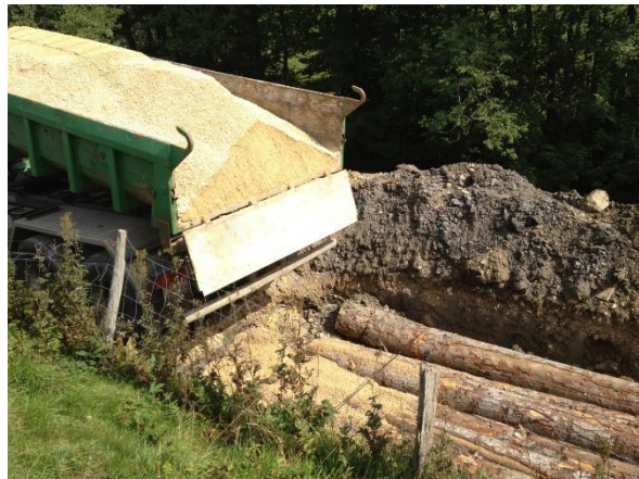
Figure 1: Grumes posées pour former le platelage. Le coffre sera remblayé directement dessus.
