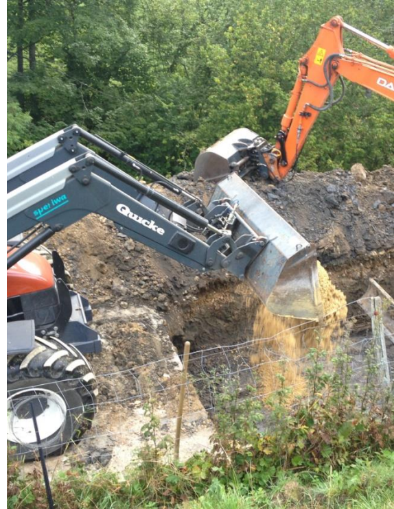
Figure 4 : Égalisation de la fouille avec grave
