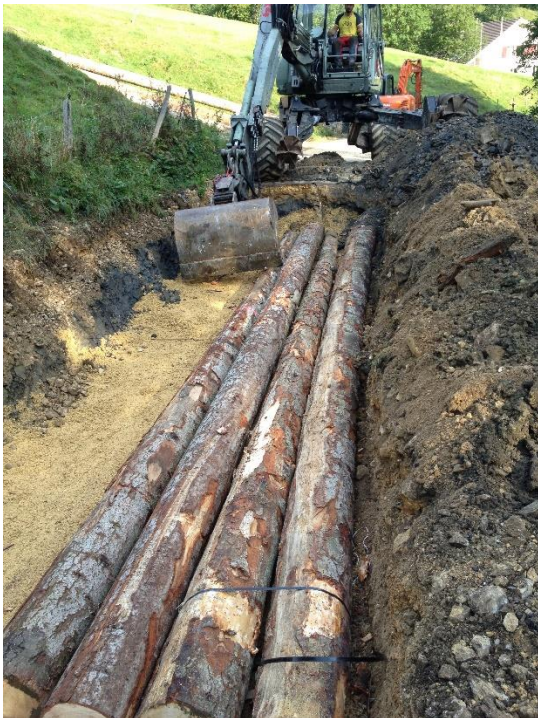
Figure 5 : Mise en place des grumes
