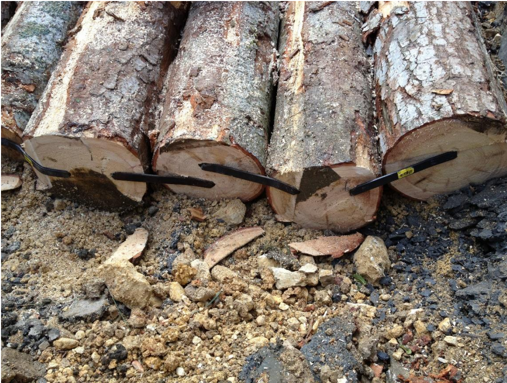
Figure 7 : Fixation à l'aide de clameaux
