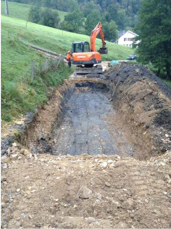
Figure 3 : Creuse de la fouille
