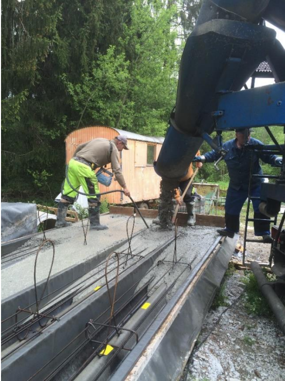
Illustration 5 : Les glissières de sécurité préparées sont placées dans les moules, recouvertes de béton puis le béton est vibré.
