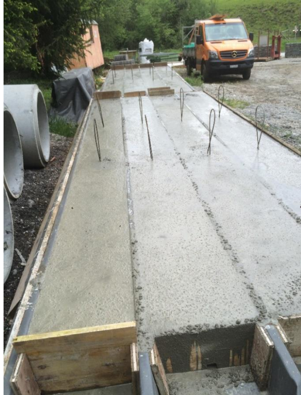
Abbildung 6: Austrocknen der verfüllten Gussformen an einem möglichst schattigen Ort
