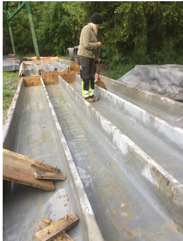
Abbildung 4: Vorbereitete Gussformen aus mit Folie überzogenen Schalungsbrettern zur „Serienfertigung“
