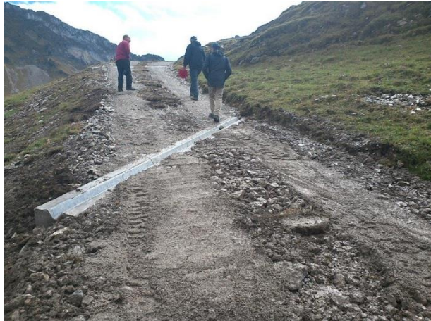
Querabschlag aus Leitplanken, Alpstrasse zur oberen Brecca
