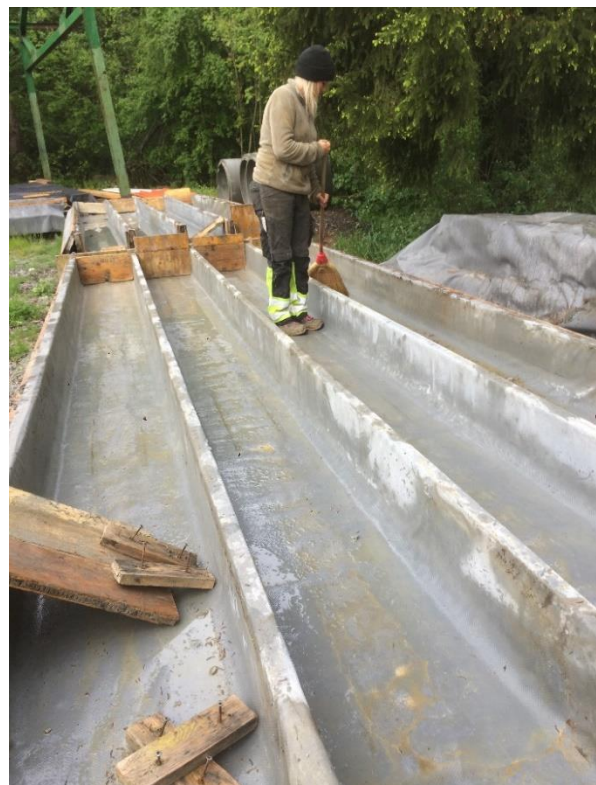
Illustration 4 : Moules préparés à partir de planches de coffrage recouvertes d'un plastique pour la "production en série".
