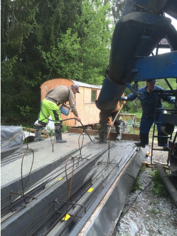
Abbildung 5: Die vorbereiteten Leitplanken werden in die Guss-formen eingelegt, mit Beton eingedeckt und dieser verdichtet
