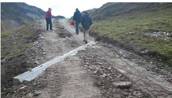
Illustration 8 : Rigole transversale terminée. A noter le type long (type B) permet de travailler avec un angle plus faible.
