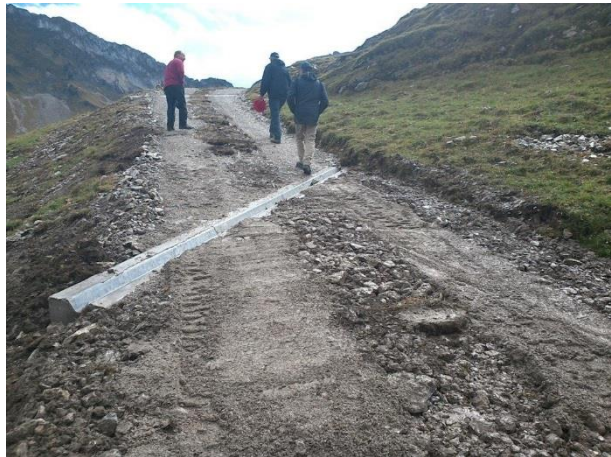
Rigole transversale avec glissière de sécurité, Route d'alpage « zur oberen Brecca »
