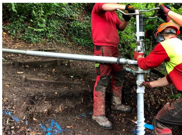
Fig. 4 : Vissage avec tige de guidage et visseuse (CFPF)
