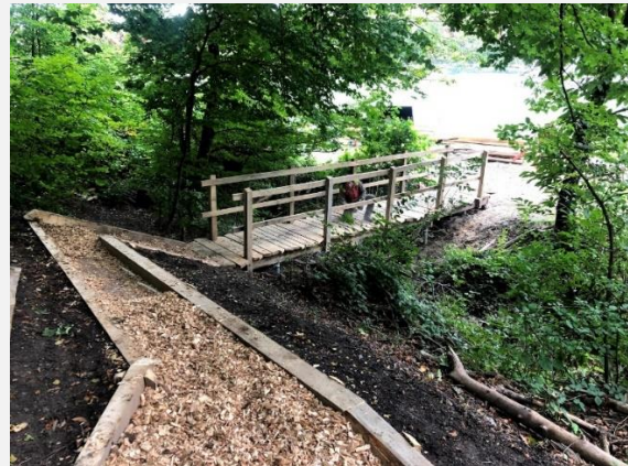
Fig. 1 : Passerelle terminée (CFPF)
