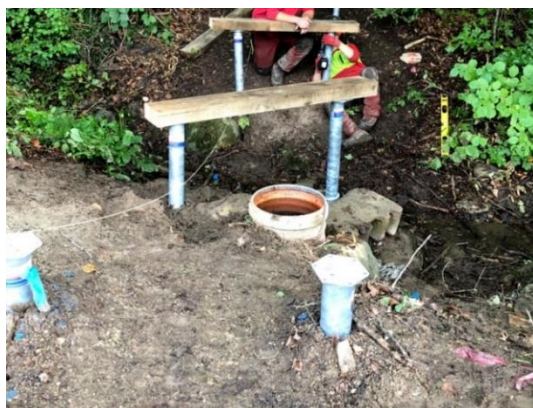
Fig. 7 : Pose directe de la structure bois (CFPF)
