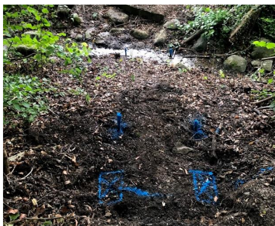
Fig. 3 : Piquetage des appuis (CFPF)
