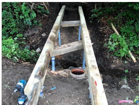
Fig. 8 : Pose directe de la structure bois (CFPF)
