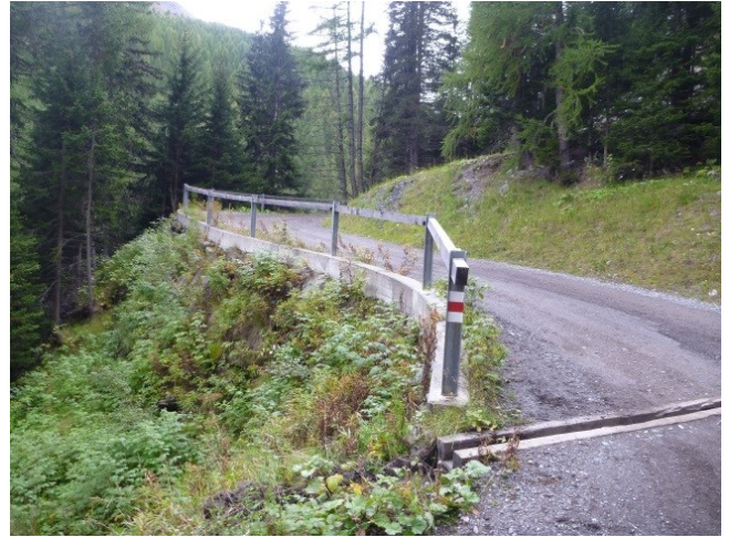
Abbildung 7 Kordon mit Bündnerzaun aufgesetzt (INP 120)
