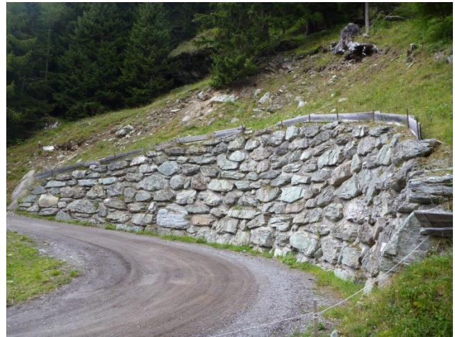
Ausbau Waldstrasse und Neubau Maschinenweg Val Faller
