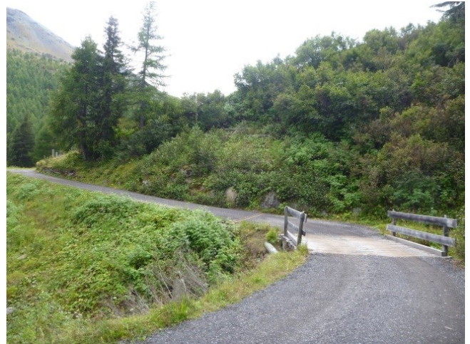
Abbildung 9 Bachübergang mit Stahlträger-Holzbrücke (HEB 300)
