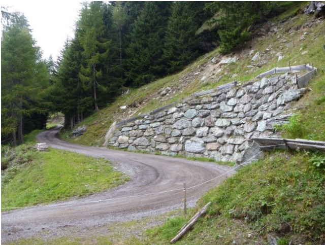
Abbildung 8 Wendeplatte mit bergseitiger, vermörtelter Blocksteinmauer
