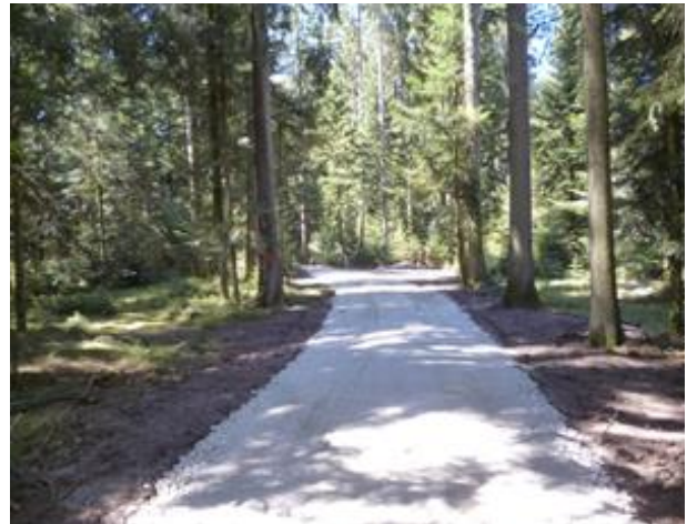
Illustration 10 : Après les travaux. L'eau peut s'écouler sur le côté.
