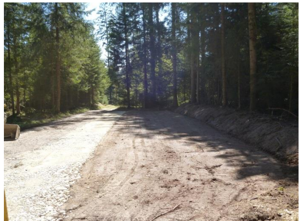
Abbildung 6 Unbefestigter Lagerplatz mit Entwässerungsgraben aussen.
