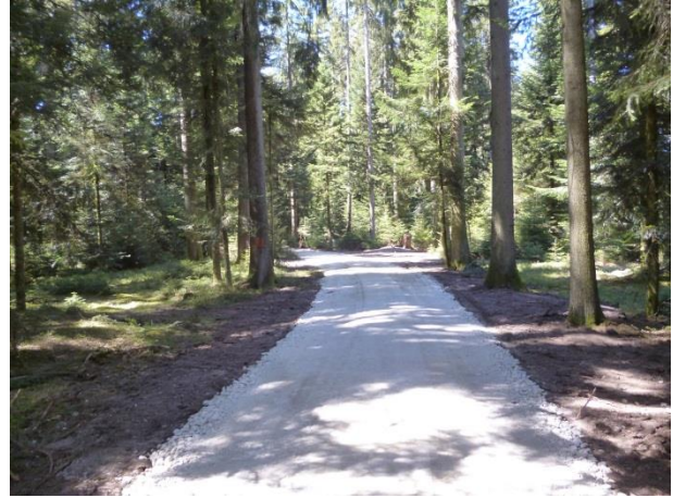
Abbildung 8 Nach dem Bau. Das Wasser kann seitlich abfließen und versickern.
