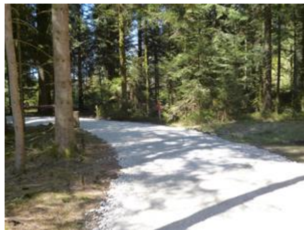
Illustration 6 : Après les travaux
