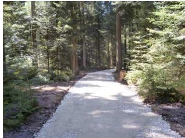
Illustration 4 : Après les travaux
