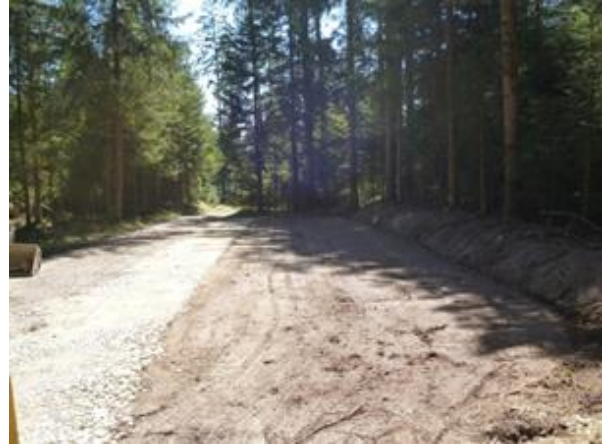
Illustration 8 : : Après les travaux place de dépôt non consolidée avec drainage latéral
