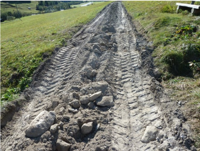
Abbildung 6 Aufreißen des alten Strassenkörpers.
