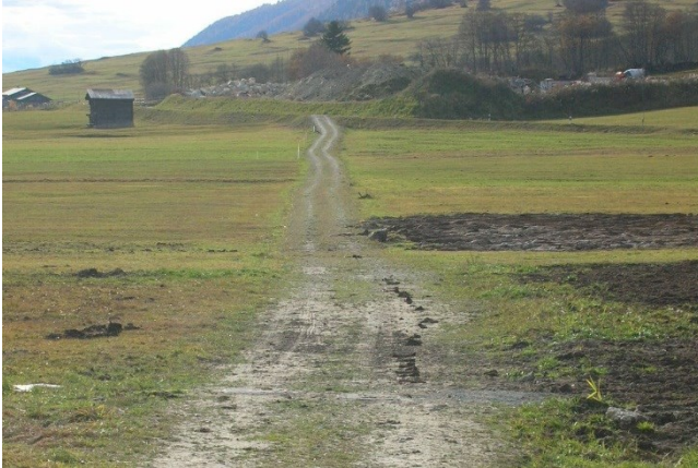
Abbildung 12 Flurweg mit Schotterrasen ein Jahr nach der Fertigstellung.
