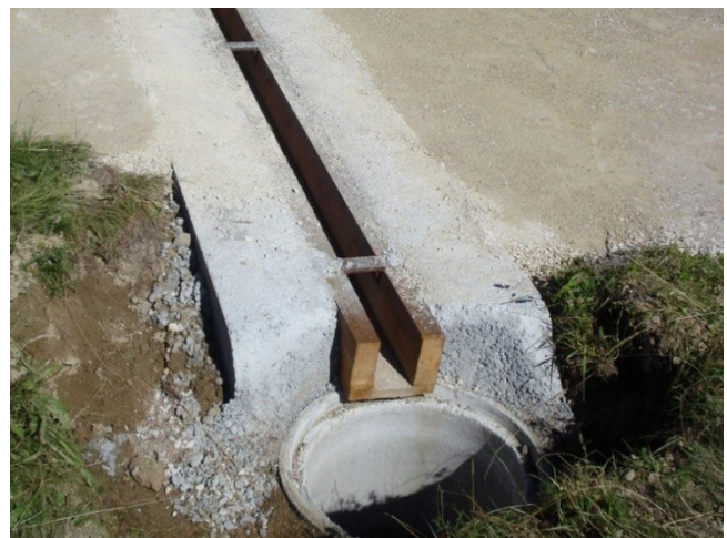
Abbildung 11 Einbetonierter Querabschluss mit Sickerschacht ist relativ aufwendig im Einbau.
