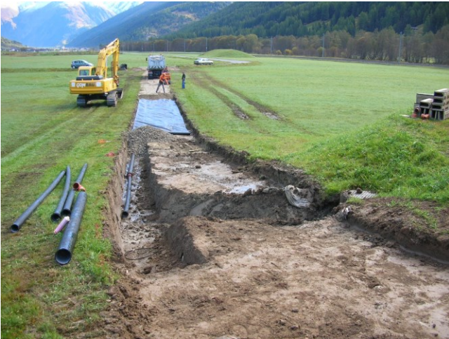
Abbildung 8 Einbau Geogewebe Sytec SG 30/30 sowie Sickerleitung und Kieskoffer 0/63.
