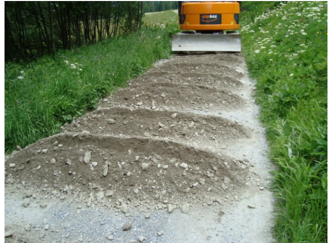
Abbildung 9 Einbau Kieskoffer mit Hilfe eines Baggers.
