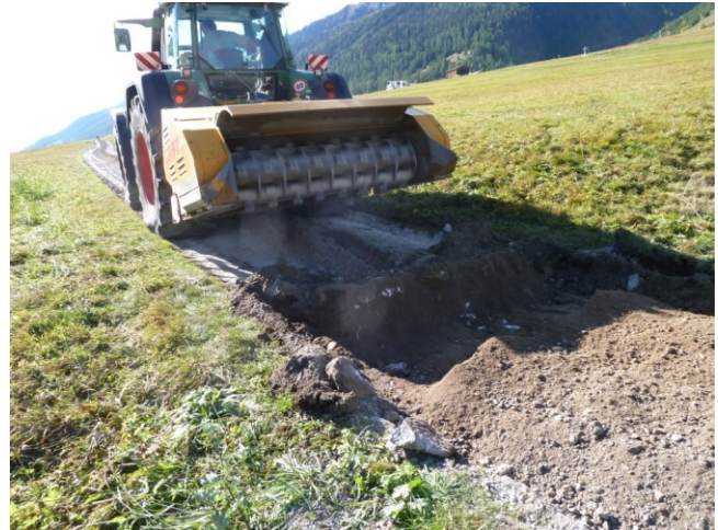
Abbildung 7 Fräsen der aufgerissenen Strasse bis 30 cm tief.
