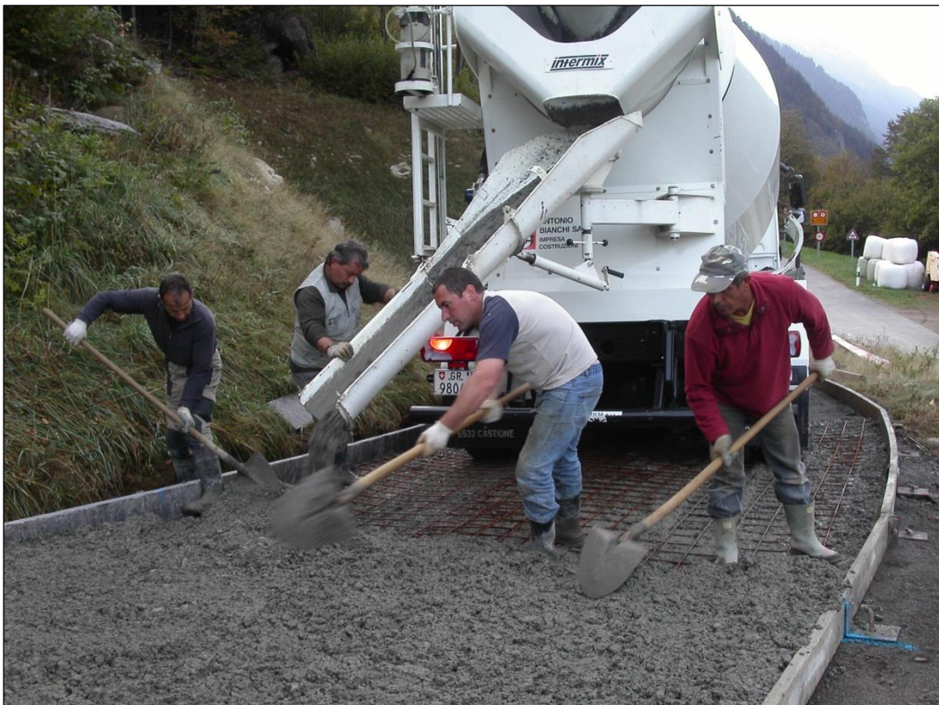
Foto 2: Posa del secondo strato di calcestruzzo sul primo (fresco su fresco) e sulla rete d'armatura. Il giunto di contrazione è stato marcato sul cassero e sul cordolo.
