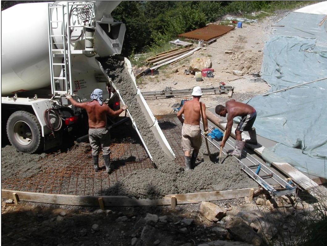
Foto 3: Posa del calcestruzzo in un tornante con raggio m 8,0 (larghezza strada m 5,50). Dopo la vibratura, la talocciata e la scopatura, la superficie viene coperta appena possibile.
