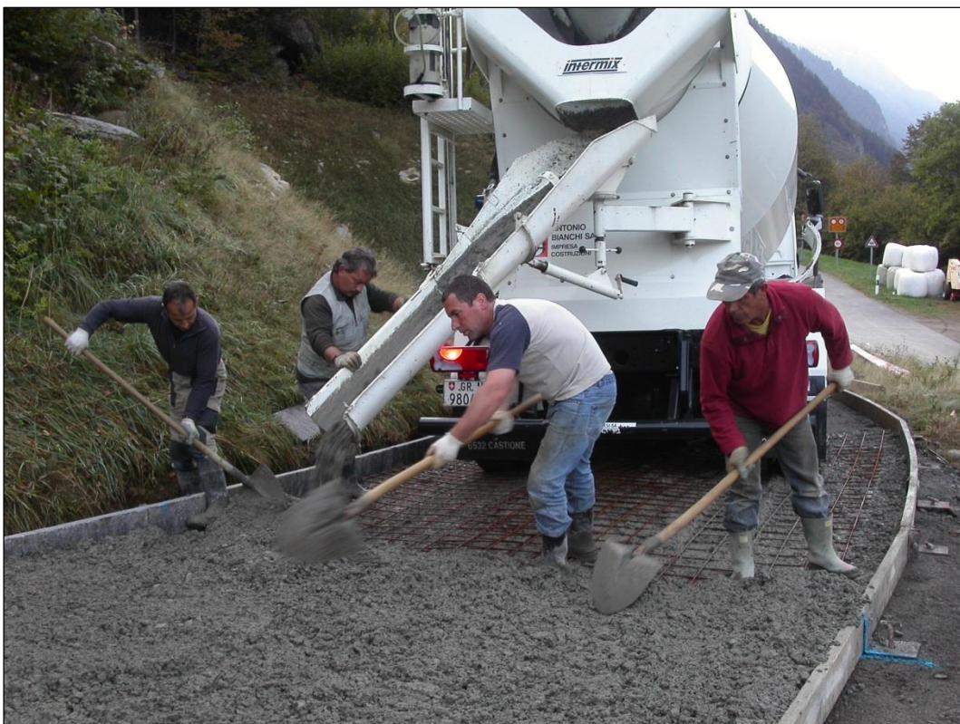
Foto 1: Einbau der ersten Schicht Beton (6 cm) auf dem Planum. Bergseits (links) sieht man den Randstein und talseits die Schalung mit Höhe cm 16.
