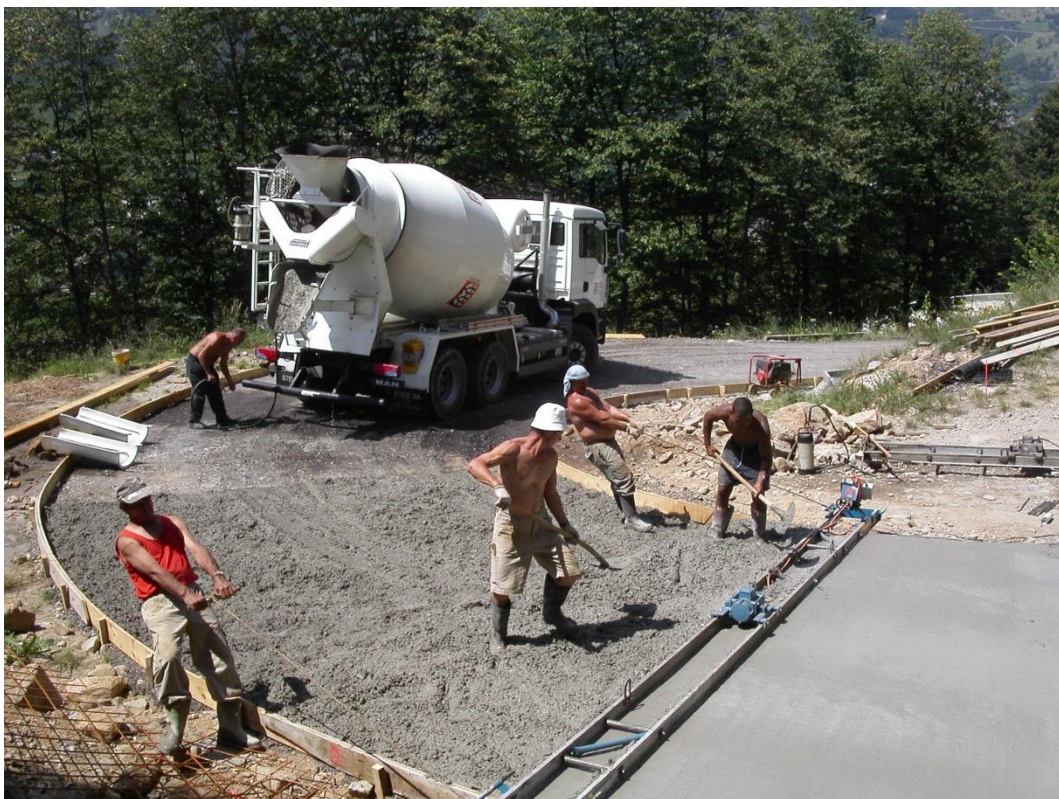
Foto 4: Costipamento adeguato con staggia vibrante di 6 m.
