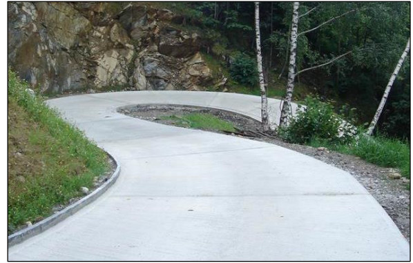
Uno dei 10 tornanti pavimentati in calcestruzzo della strada forestale Stabi
