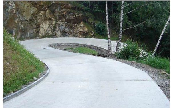
Einer der 10 betonierten Wendeplatten des Waldweges Stabi
