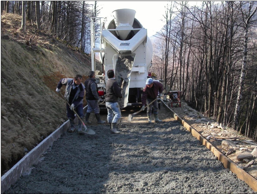
Foto 1: Einbau der ersten Schicht Beton (6 cm) auf dem Planum. Bergseits (links) sieht man den Randstein und talseits die Schalung mit Höhe cm 16.
