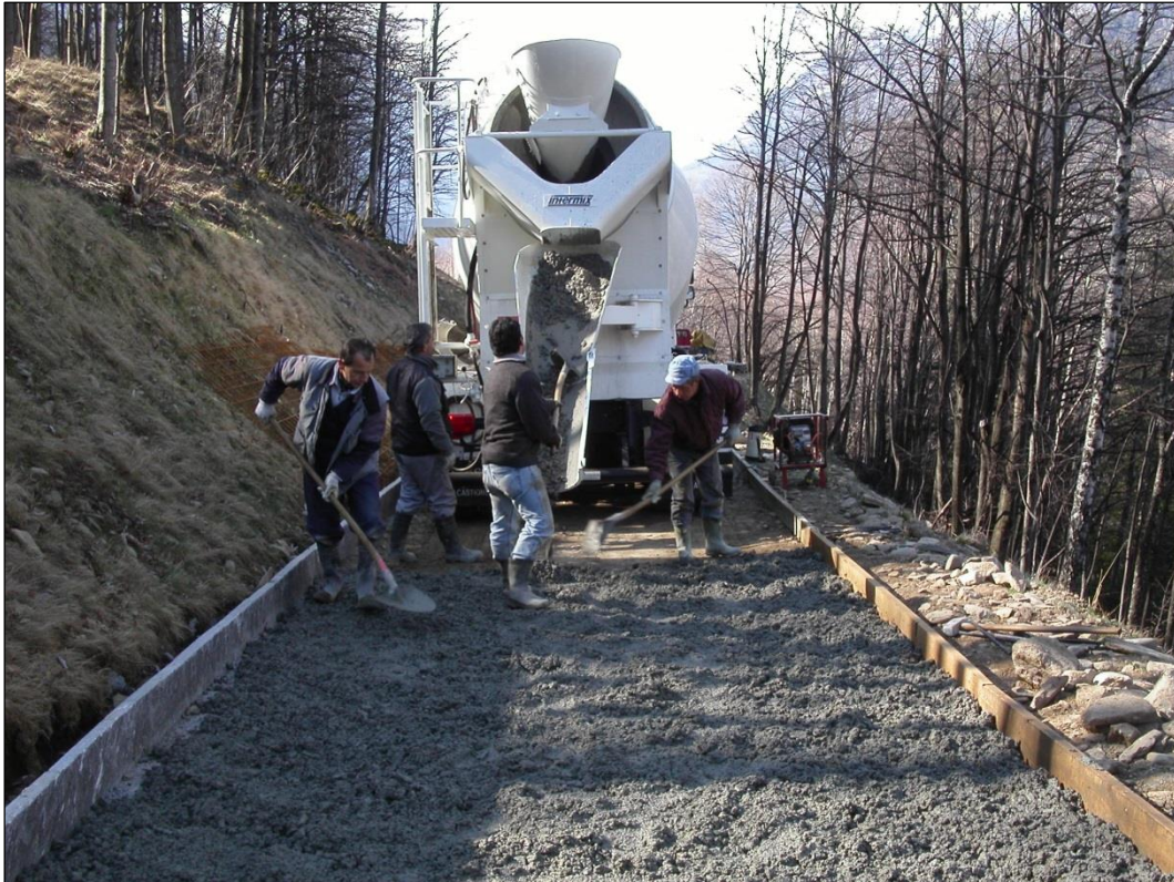
Foto 1: Posa del primo strato di calcestruzzo sul planum. A monte (sinistra) si intravede il cordolo in sasso, a valle il cassero esterno spessore cm 16.
