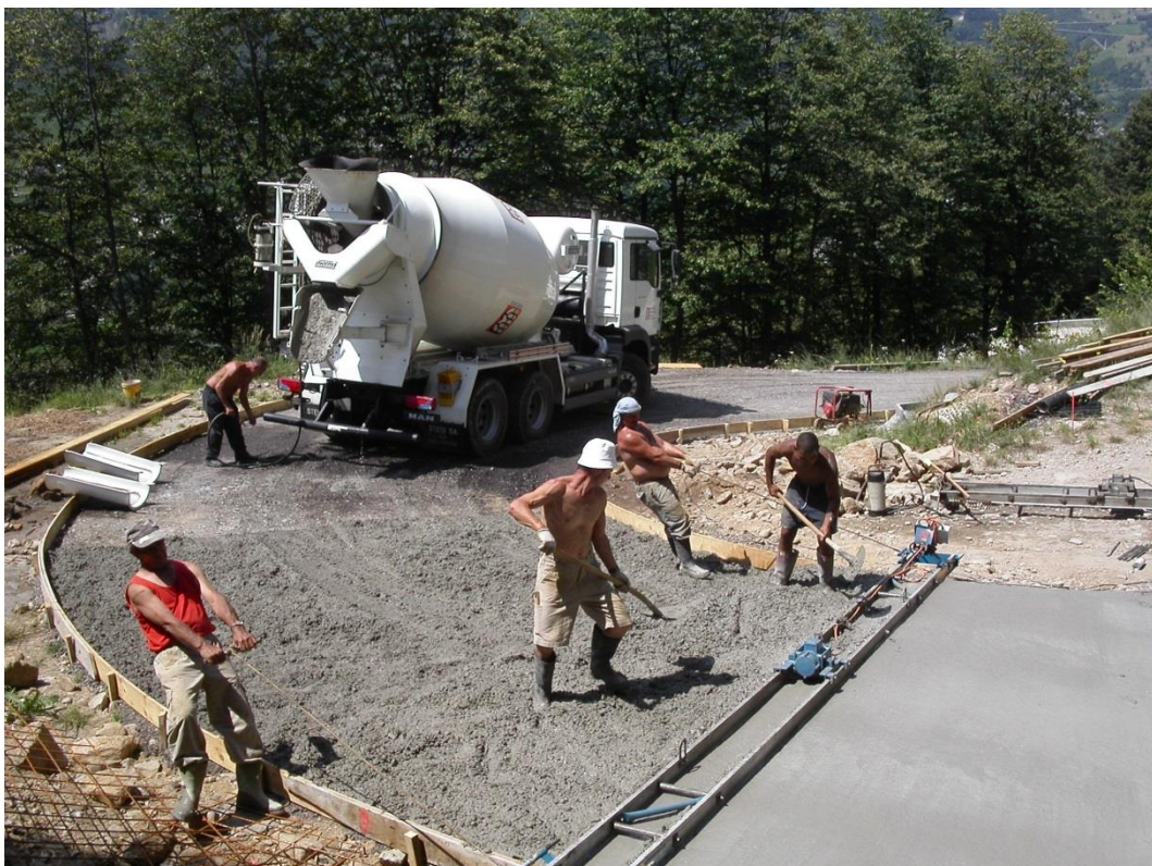
Foto 4: Geeignetes Vibrieren mit Vibrobalken von 6,0\ m .
