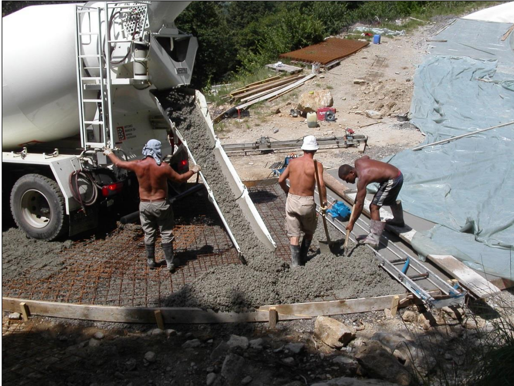
Foto 3: Einbau des Betons in eine Wendeplatte mit Radius m\ 8,0 (Breite Strasse m\ 5,50 inkl. Rigole). Nach dem Vibrieren, taloschieren und Besenstrich wird die Oberfläche zugedeckt.
