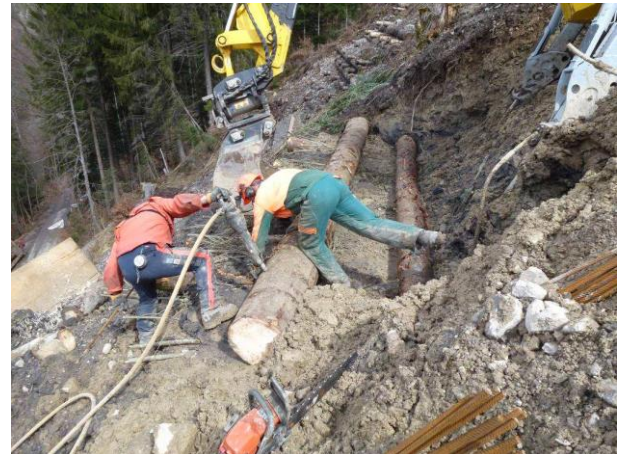
Abbildung 4: Einbau der Rundhölzer mithilfe des am Seil gesicherten Schreitbaggers (12.03.2013)
