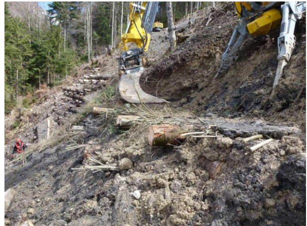
Abbildung 10: Der Einsatz von Weidenbuschlagen dient der Begrünung und begünstigt die Entwässerung (12.04.2013)
