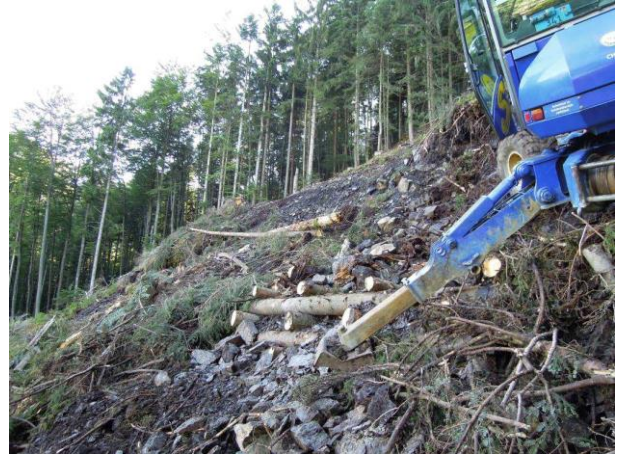
Abbildung 8: Im Anrissgebiet kamen z.T. auch einwandige Holzkasten zum Einsatz (Quelle: geotest, 21.08.2012)
