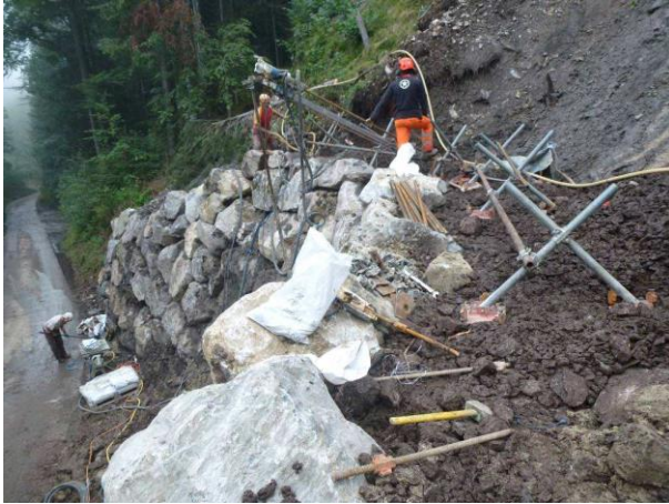
Abbildung 7: Die Selbstbohranker werden mit einem Lawinenbohrgerät (Bohrlafette) eingetrieben (05.09.2012)
