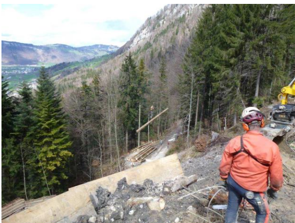
Abbildung 5: Der Materialtransport und dabei v.a. das Holz erfolgt mit dem Mobilseilkran (12.04.2013)
