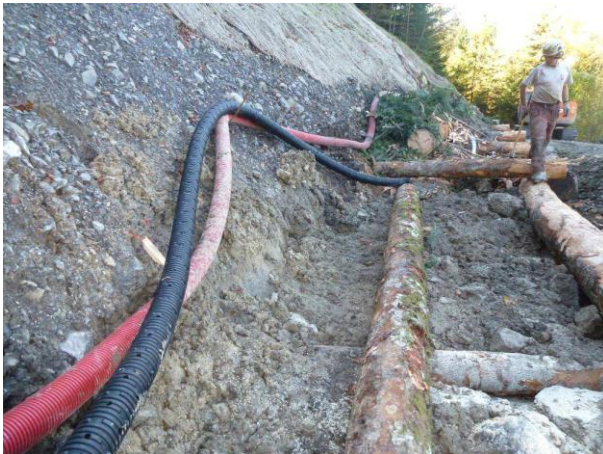
Abbildung 3: Der Hangfuss wird mit doppelwandigem Holzkasten abgestützt, luftseitige Hölzer werden entrindet (19.10.2012)
