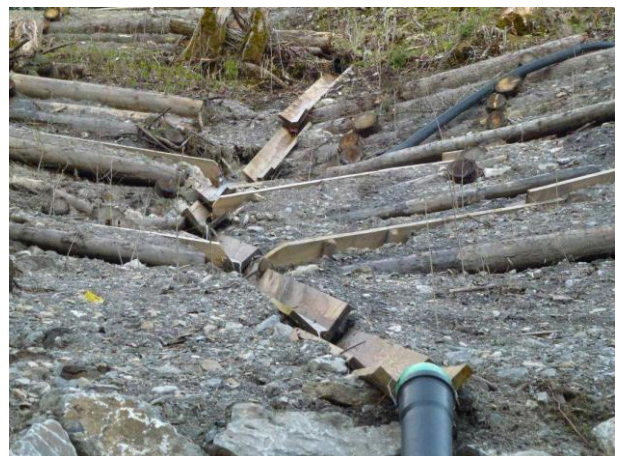
Abbildung 12: Zur oberflächlichen Entwässerung wurden die V-Holzkännel fischgratförmig angeordnet (25.04.2013)
