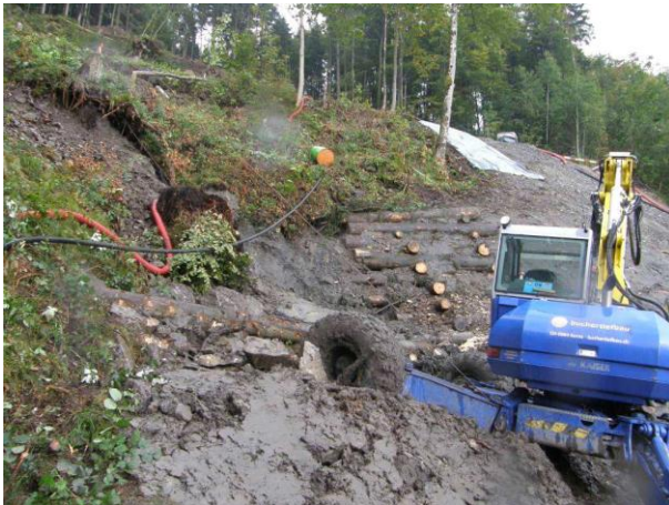
Abbildung 9: Die erstellten Holzkasten im steilen und vernässten Hang werden eingedeckt (24.09.2012)
