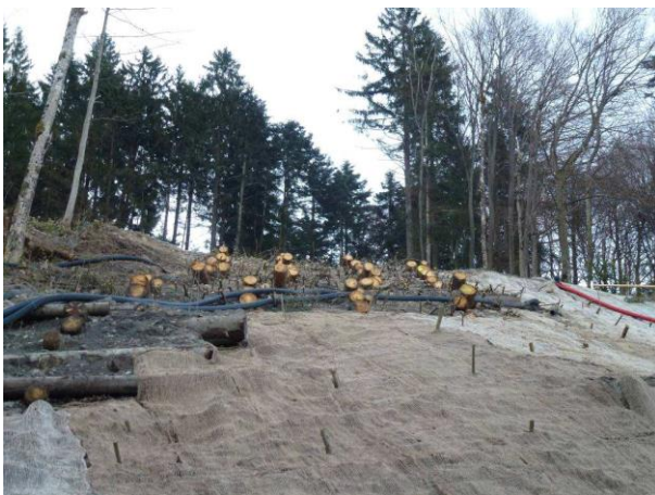
Abbildung 11: Oberflächensicherung mittels Jutenetz und Stecklingen (25.04.2013)
