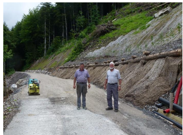
Abbildung 6: Fertiggestellte Böschungssicherung. Der Holzkasten wurde am Schluss bis auf \frac{3}{4} seiner Höhe angedeckt (21.06.2013).
