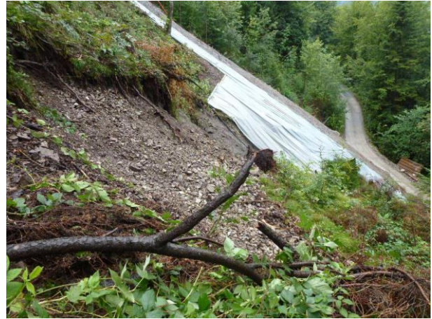
Abbildung 2: Plastikabdeckung als Sofortmassnahme, um Niederschlagswasser oberflächlich abzuführen (01.09.2012)
