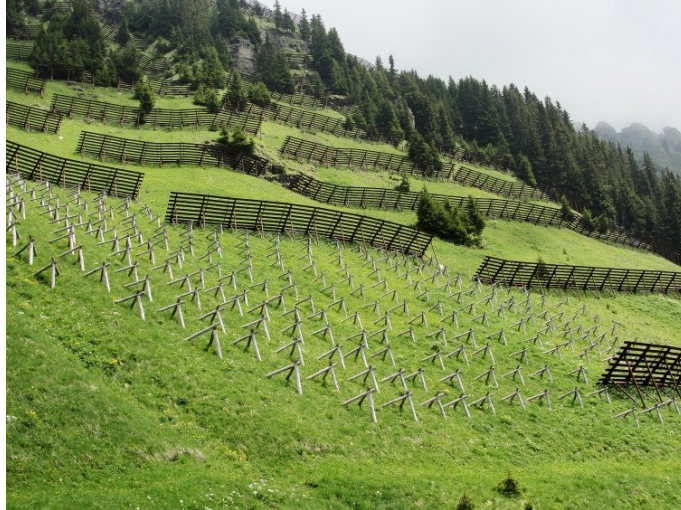
Abbildung 11 Dreibeinböcke am unteren Rand der Verbauung.
