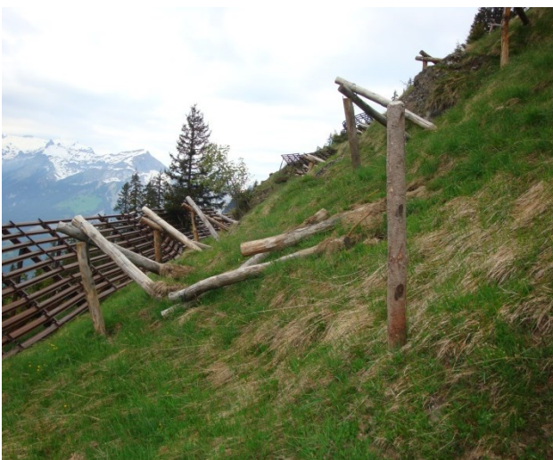
Abbildung 9 Beschädigte Dreibeinböcke
