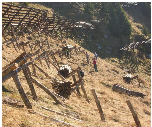
Abbildung 10 Bauphase der Dreibeinböcke
