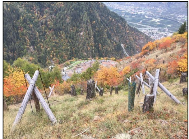
Figure 1 : Trépieds construits à Isérables
