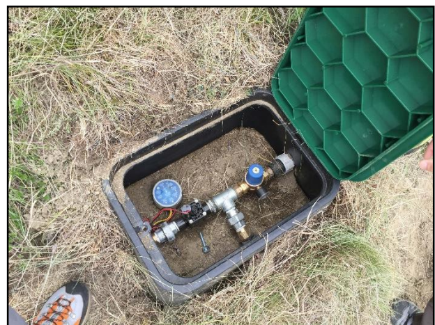
Figure 13 : vanne de dérivation avec débitmètre
