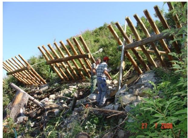
Abb. 8: Installation der Stützen an mit Seilen gesicherten Rechen; Bestimmung deren Länge und Lage der Bodenplatte
