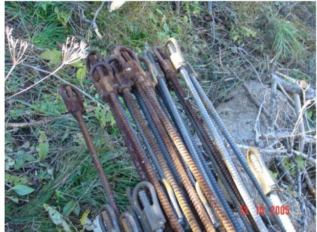
Abb. 6: Stabanker mit Haltebügel, an welchen die Stahlseile zur Verankerung der Bodenpfetten eingeschlaufft werden
