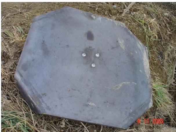
Abb. 9: Unterseite der Stahlplatte mit den aufgeschossenen Hilti-Nägeln als Fundamentplatte der Stützen
