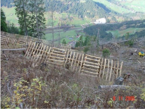
Abb. 11: Talwärtiger Blick ins Verbauungsgebiet vom oberen Rand aus; Haupt- und Zwischenwerke (Rechen-/Brückenrost)
