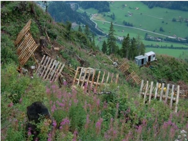
Abb. 13: Talwärtiger Blick mit Rechen im Vordergrund und Schutzbaracken im Hintergrund
