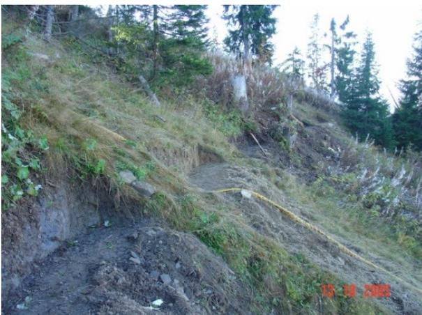
Abb. 3: Ausgehobene Bermen, in welchen die Anker versetzt
