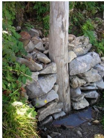
Abb. 16: Lose Steine werden zu Trockenmauern auf den Bodenplatten der Stützen erstellt (Schutz und Gewicht)
