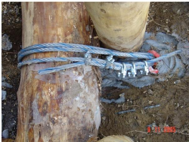
Abb. 7: Die Bodenpfette ist über das Stahlseil und den fünf Seilklemmen am injizierten Anker befestigt
