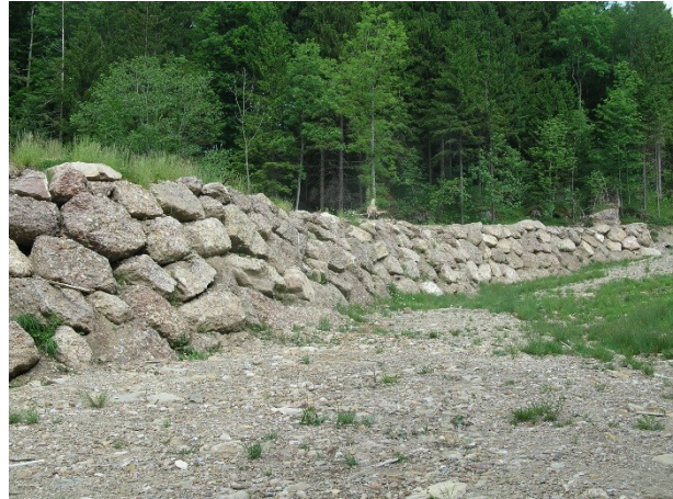
Abbildung 2: Fertiggestellter unterer Schutzdamm mit Blocksteinfront
