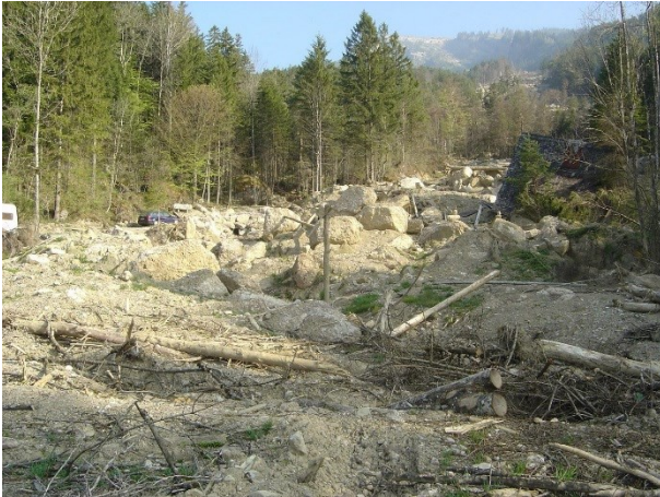
Abbildung 1: Prozessgebiet Grisselenbach nach den Ereignissen vom August 2005
