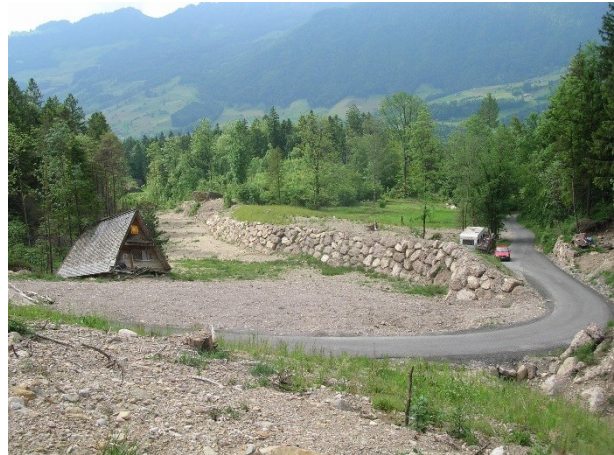
Abbildung 4: Blick in Richtung Tal mit unterem Schutzdamm. Die Strasse senkt sich zur Gerinneachse zum Schutz vor ausbrechender Geschiebemasse. Das vom Murgang 2005 verschobene und schräg gestellte Gebäude wurde als „stummer Zeuge“ an Ort und Stelle belassen.
