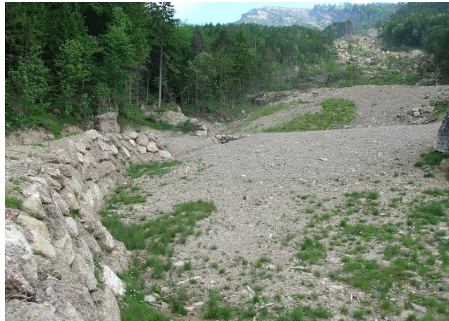
Unterer Murgangdamm Grisselenbach, Sicht ins Prozessgebiet
