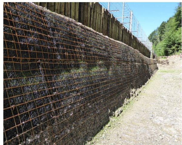
Abbildung 13 Bewehrte Erde zur Gestaltung der übersteilen Dammfront, mit welcher der Einschlagwinkel verbessert und dynamische Energieaufnahme ermöglicht wird.
