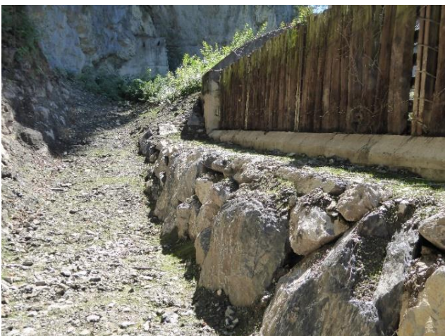
Abbildung 12 Die statisch wirkende Palisade besteht aus zwischen Trägern eingespannten Eisenbahnschienen und vorgelagerten Holzschwellen (Dämpfung).
