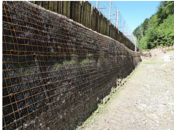
Damm aus bewehrter Erde, vorgelagerter Betonmauer und statisch wirkender Palisade
