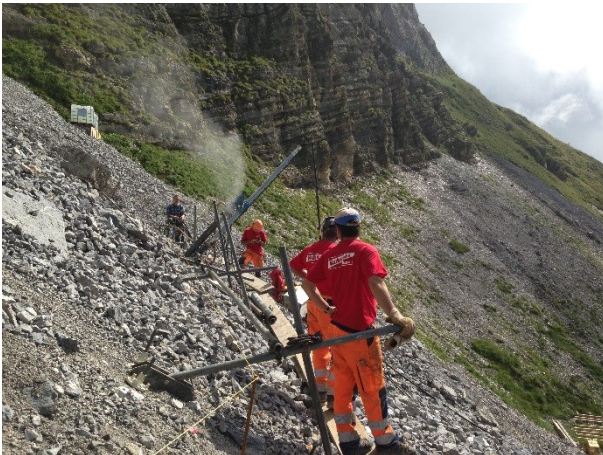
Abbildung 3: Bohrarbeiten für die bergseitigen Zuganker der Ankerzangen (Epp 2013)
