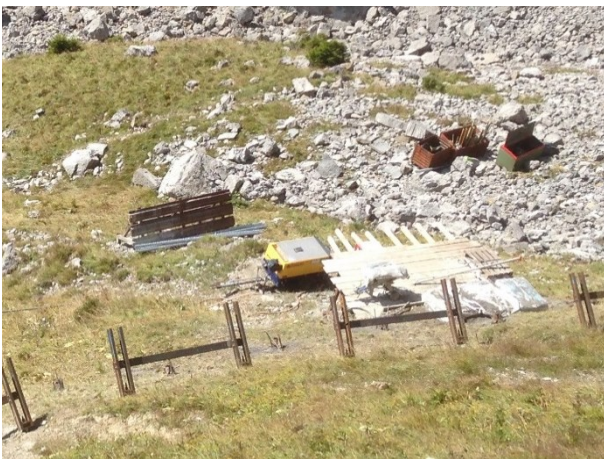
Abbildung 9: Stahlböcke als temporärer Depotplatz und Auf-fangvorrichtung für das Materiallager (Epp 2013, verändert)
