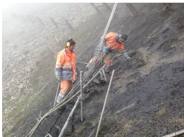
Abbildung 6: Bohrarbeiten für die talseitigen Verankerungen der Stützen (Epp 2013)
