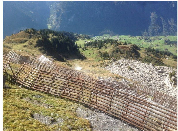
Abbildung 16: Blick talwärts über Verbauung und Lawinenzug, Detail: Zwischensätze als Werkverbindungen (Epp 2014)
