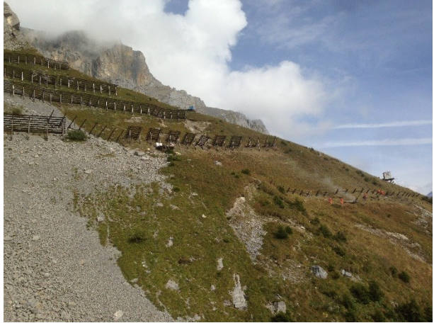
Abbildung 14: Montage der Stahlschneebrücken in Etappen, Blick in die östliche Hälfte der Verbauungsfläche (Epp 2014)
