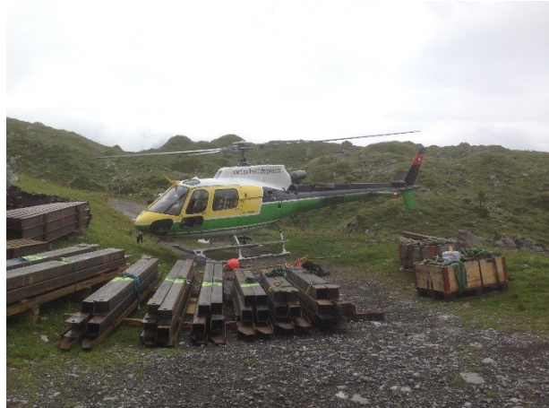
Abbildung 2: Für den Flugtransport vorbereitetes Stützverbau-Material auf dem Installationsplatz Mettener Butzli (Epp 2014)
