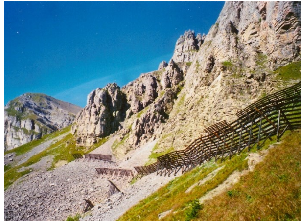
Stahlschneebrücken Grotzenegg (Kalbermatter GmbH 2014)
