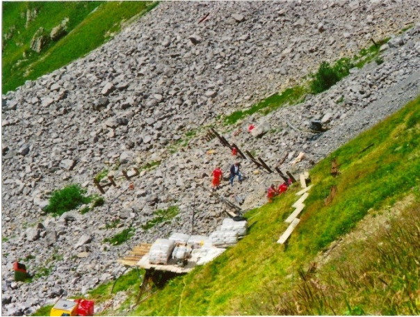
Abbildung 7: Temporäre Holzplattform als Lagerplatz für benötigtes Material und Werkzeuge (Kalbermatter GmbH 2013)
