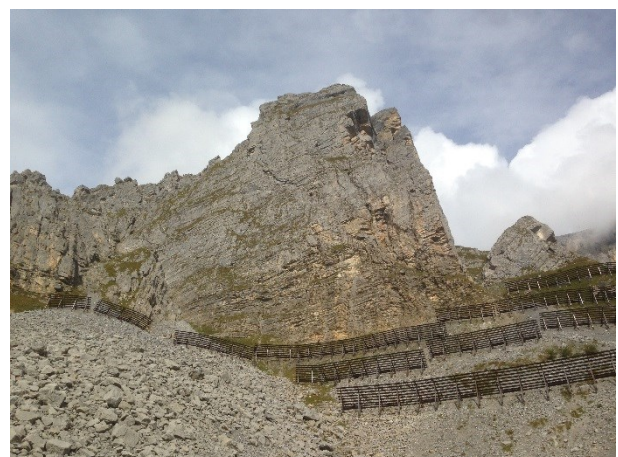
Abbildung 17: Fertiggestellte obere Werkreihen unterhalb des Berglichopf (Epp 2014)
