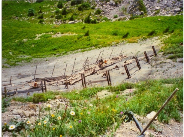
Abbildung 8: Erleichterte und sicherere Bohr- und Montagearbeiten durch Arbeitsgerüste (Kalbermatter GmbH 2013)
